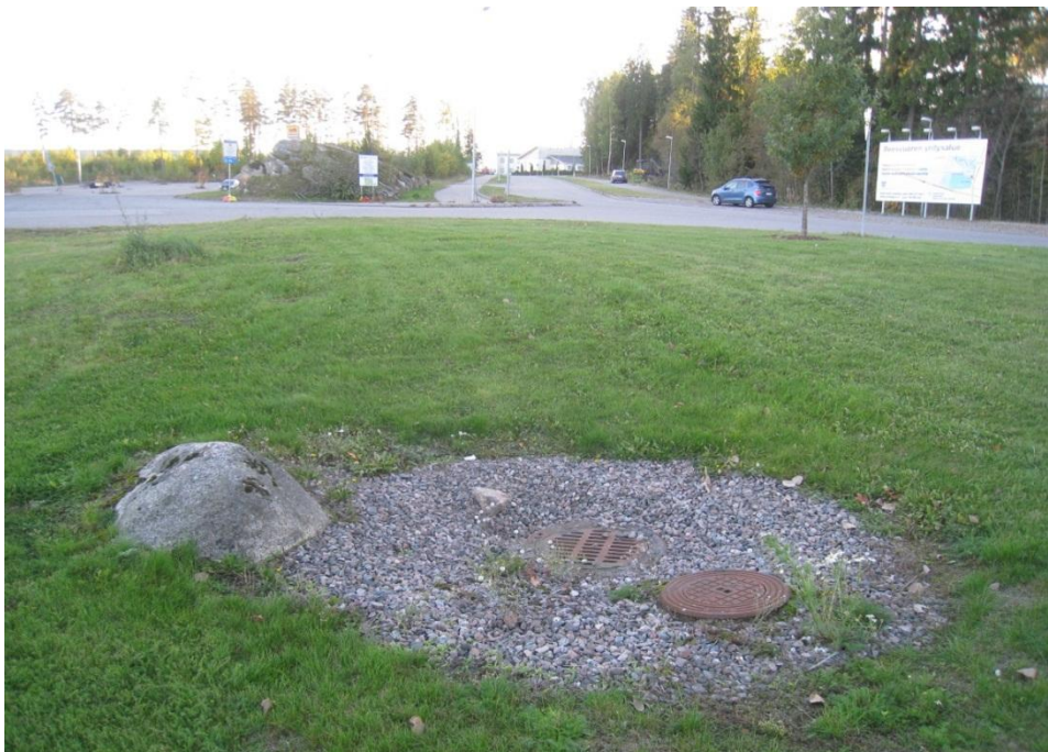
Kuva 6. Matala hulevesipainanne nurmialueella ja näkymä Ilvesvuorenkatua etelään päin
