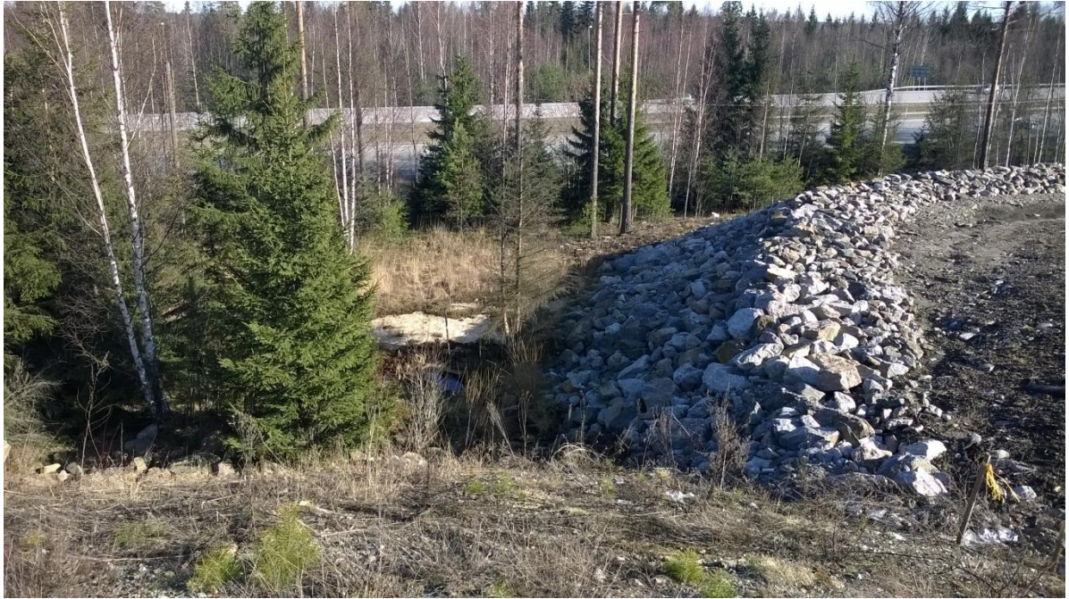
Kuva 11. EV-alueen eteläreunaa. Hulevesien laskuja sijoittuisi kiviluiskan alapuolelle
