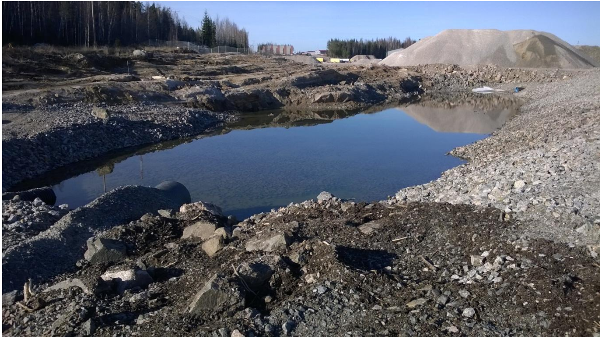
Kuva 7. Rakenteilla oleva Ilvesvuoren hulevesiallas 1
