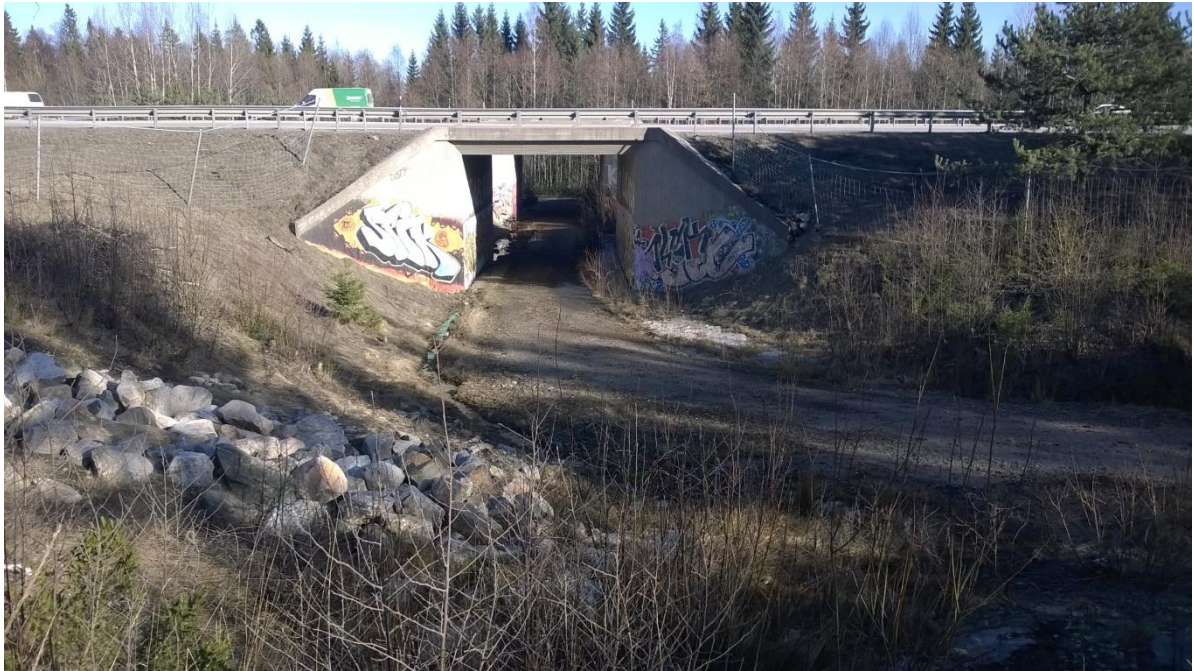
Kuva 12. Moottoritien alittava alikulkukäytävä. Hulevesikouru on vielä rakentamatta
