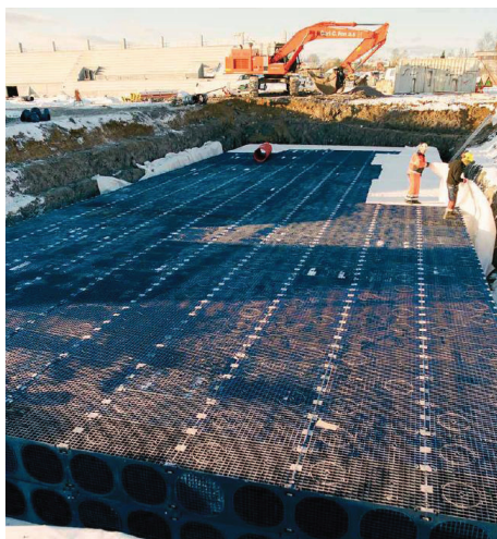
Kuva 16. Hulevesikasetit ovat esimerkki maanalaisesta hulevesien viivytys- ja imeytysjärjestelmästä
