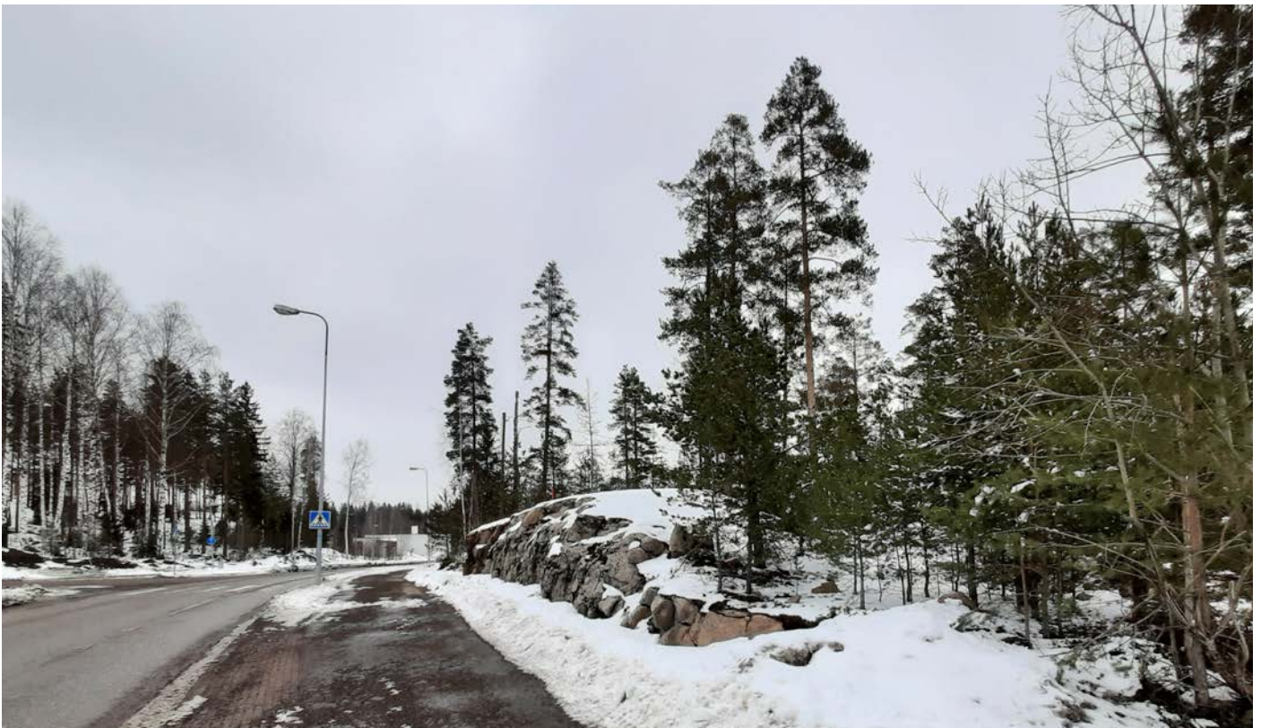
Näkymä Ilvesvuorenkatu 4:n ajoliittymän kohdaltalta pohjoiseen. Kallion lakialue kadun oikealla puolella.
