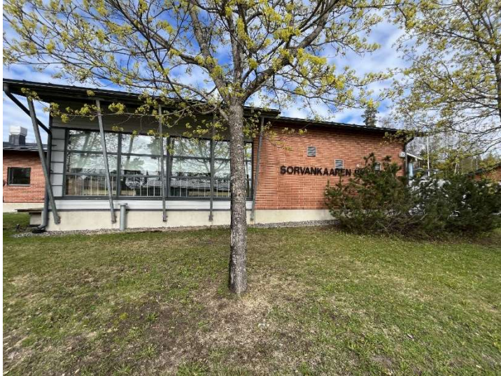
Kuva 1. Liikuntasalin ja väestönsuojan päätyä.
