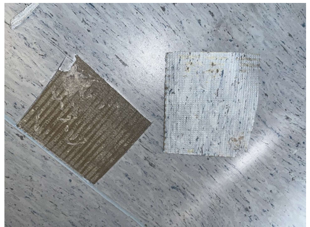
Kuva 32. Päiväkodin johtajan huone, väestönsuoja.
