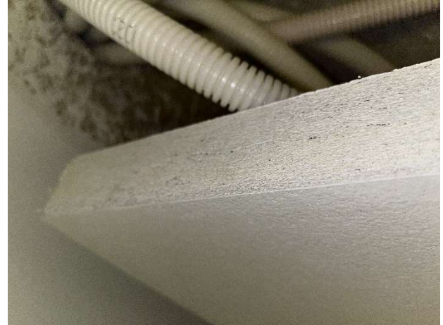
Kuva 94. Akustiikkalevyt on reunoiltaan pinnoitettuja.
