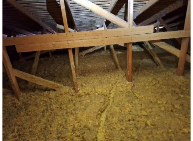
Kuva 72. Puhallusvillan pinnassa näky jyrsijöiden kulkureittejä.
