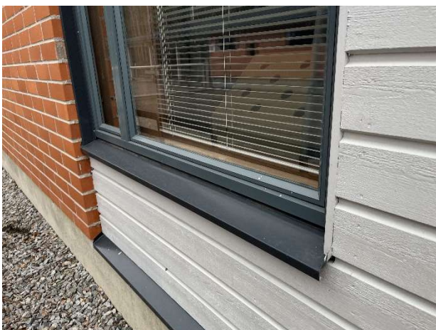
Kuva 43. Ulkoseinän puuverhousta.
