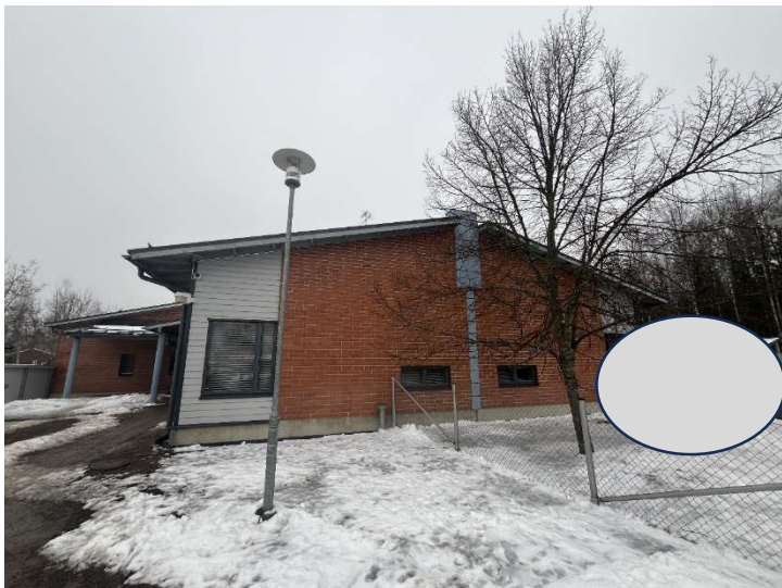
Kuva 4. Parkkipaikan puoleista päätyä.
