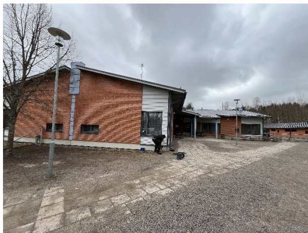
Kuva 42. Parkkipaikan puoleista päätä.
