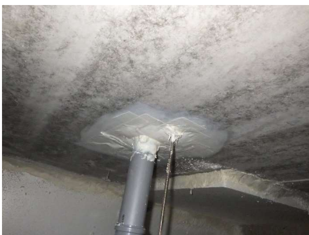
Kuva 20. Läpiviennit on tiivistetty.
