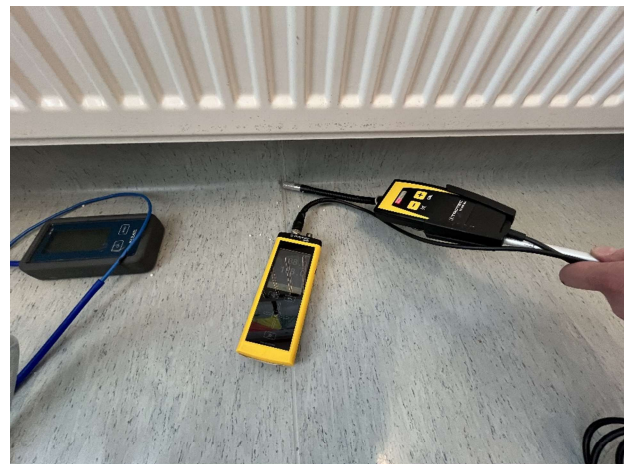
Kuva 83. Merkkiainekaasun havaittiin kulkeutuvan sisäilmaan muovimaton sauman kautta.
