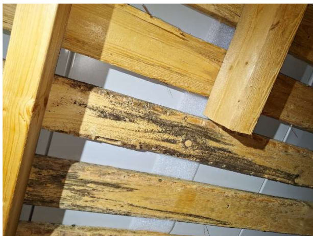
Kuva 75. Mikroivaurioita ruodelaudoissa.
