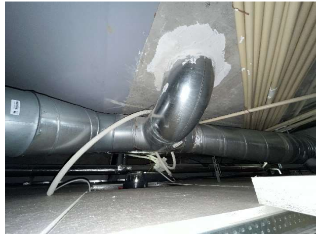
Kuva 96. Alaslaskujen yläpuolista tilaa.
