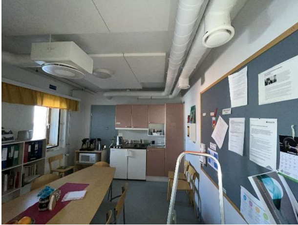
Kuva 93. Kattoon liimattua akustiikkalevytystä.
