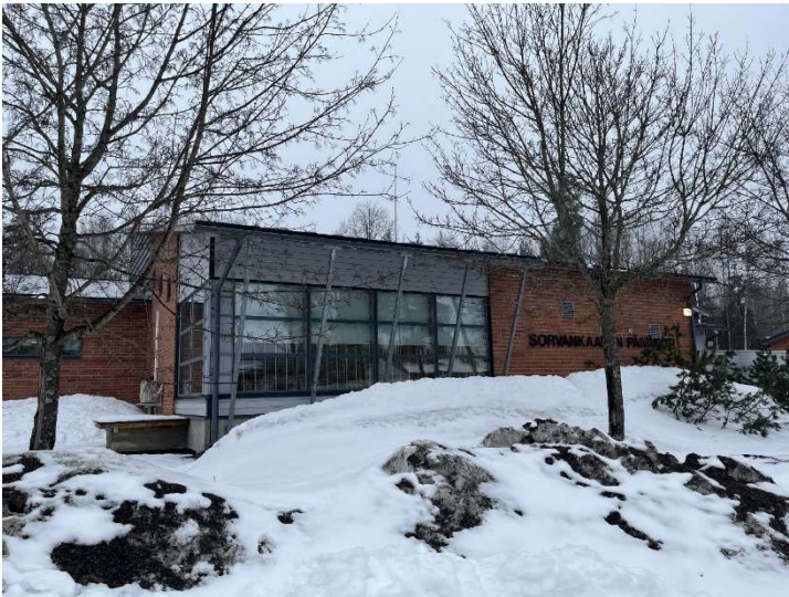
Kuva 11. Liikuntasalin ja väestönsuojan päätyä.
