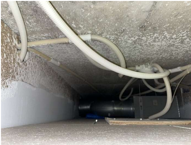
Kuva 95. Alaslaskujen yläpuolista tilaa.
