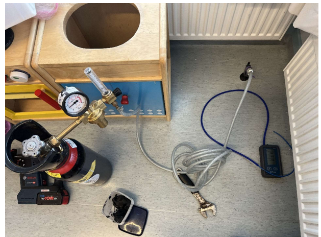
Kuva 81. Merkkiaineen syöttöä alapohjarakenteen eristetilaan.
