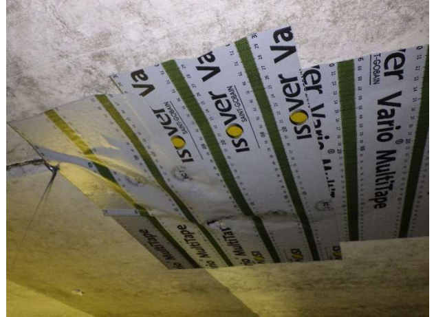
Kuva 23. Tiivistämätön läpivienti.
