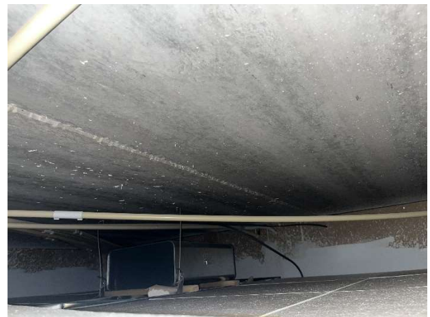
Kuva 98. Alaslaskujen yläpuolista tilaa.
