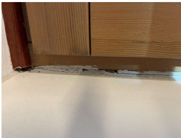
Kuva 56. Ikkunan ja ulkoseinärakenteen välissä havaittiin uretaanieriste.
