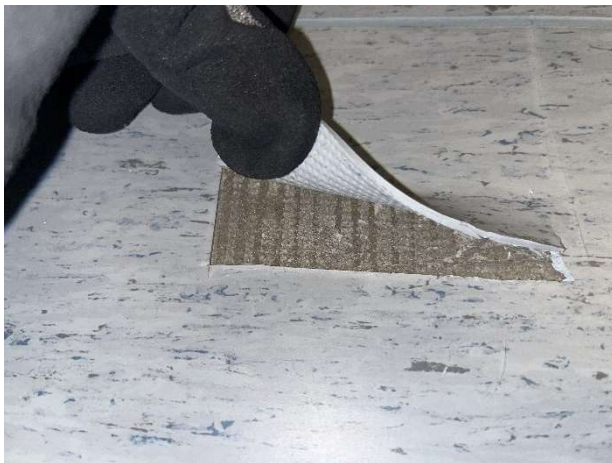
Kuva 31. Päiväkodin johtajan huone, väestönsuoja.
