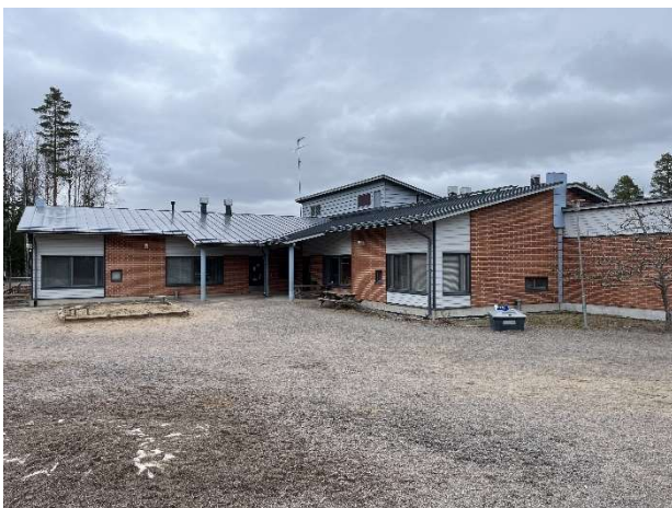
Kuva 41. Ulkoseinät ovat puu- ja tiiliverhoituja
