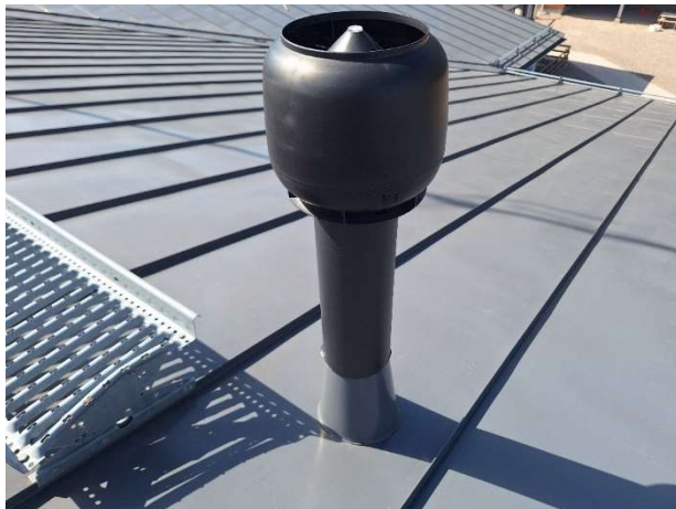
Kuva 67. Viemärin tuuletusputki.
