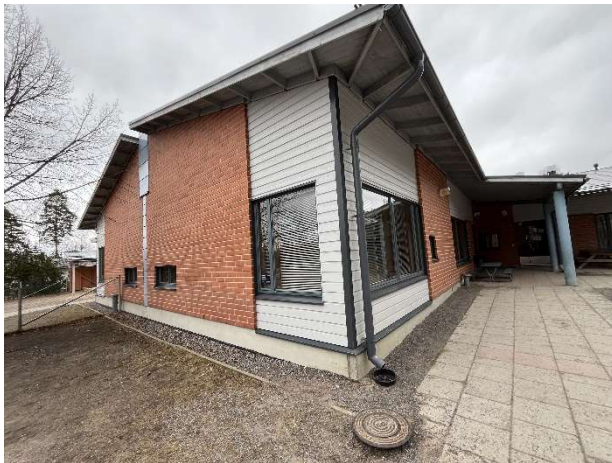
Kuva 13. Rakennuksen ulkoseinien vierustojen sepelöintiä, laatoitusta ja sadevesien ohjausta.
