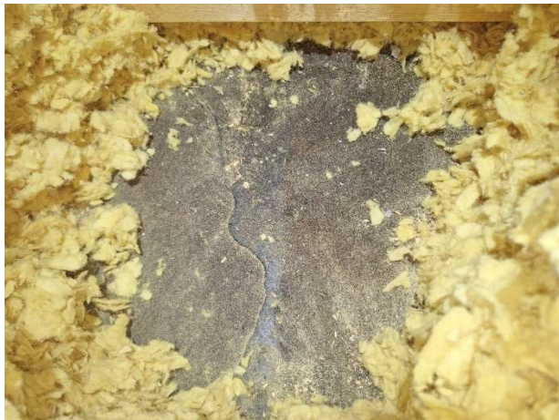
Kuva 73. Ontelolaatan päällä on kumibitumikermi.
