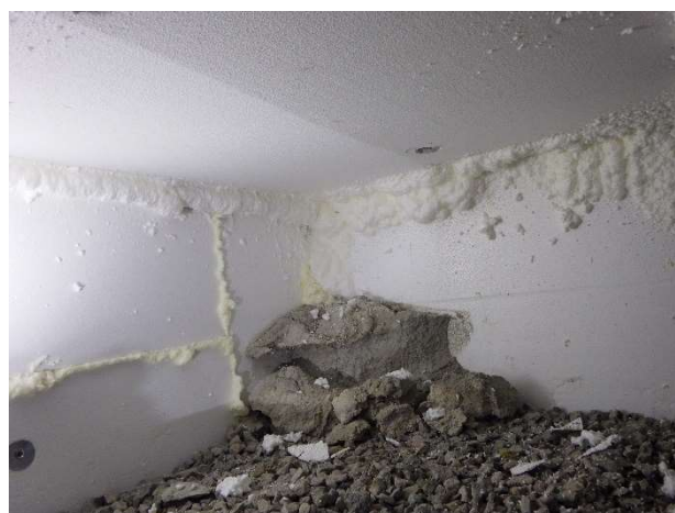
Kuva 21. Alapohjan rakenneliittymiä on tiivistetty ryömintätalasta käsin.
