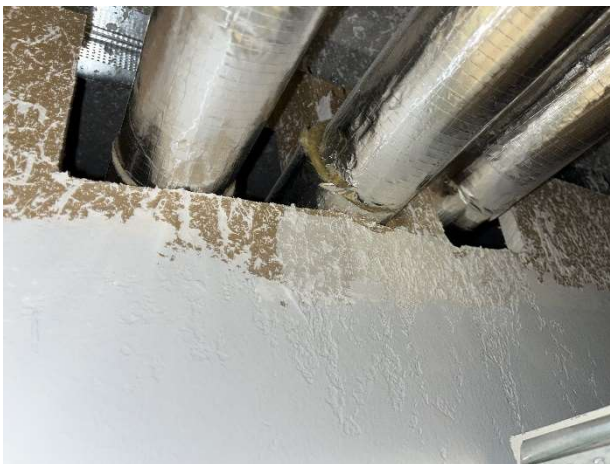
Kuva 97. Alaslaskujen yläpuolista tilaa. Putkieristeiden päissä havaittiin avointa mineraalivillapintaa vähäisissä määrin.
