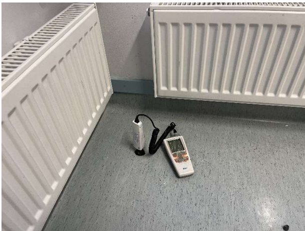
Kuva 26. Alapohjan eristetilän olosuhdemittausta.
