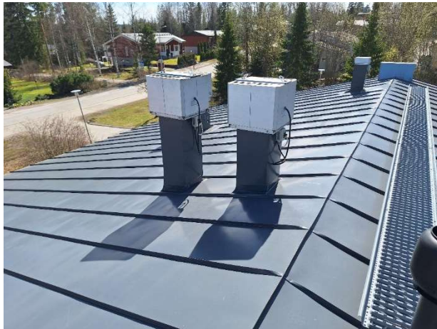
Kuva 65. Vesikaton läpivientejä.
