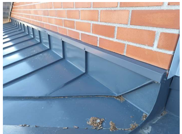
Kuva 64. Rintataitepellitykset on tehty asianmukaisesti.
