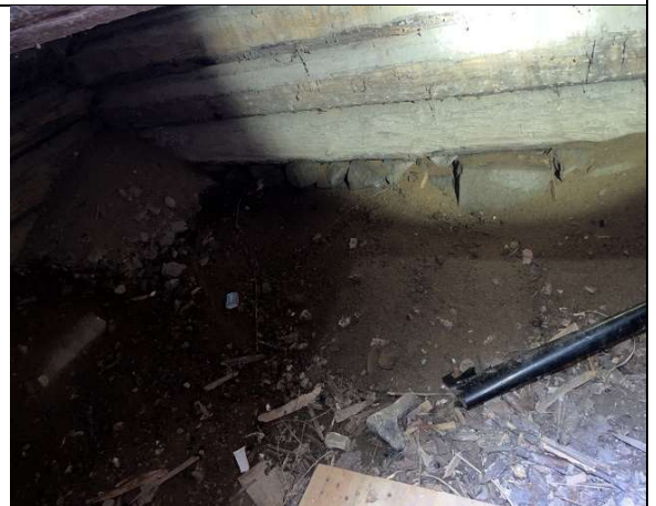
Kuva 6 Ryömintätilaa ja ulkoseinän alaosan hirsirunkoa.
