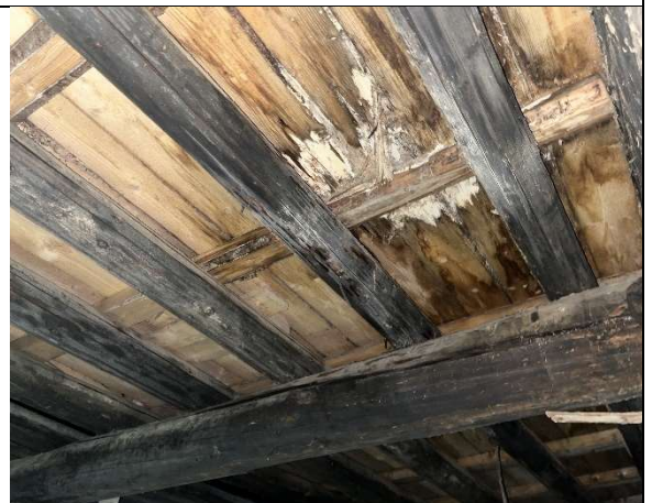
Kuva 48 Välipohjan lahovaurioita.
