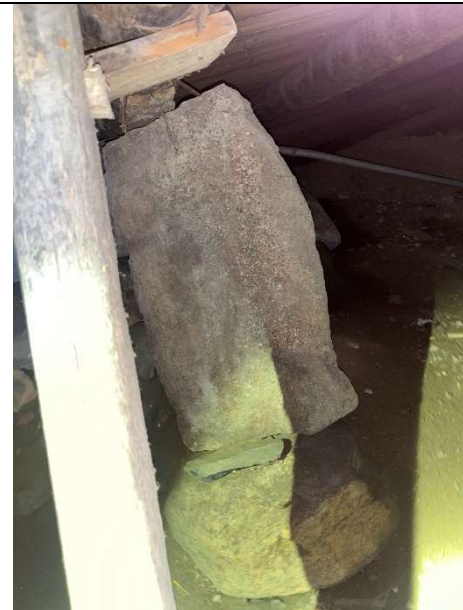
Kuva 7 Alapohjarakenteiden tuentaa
