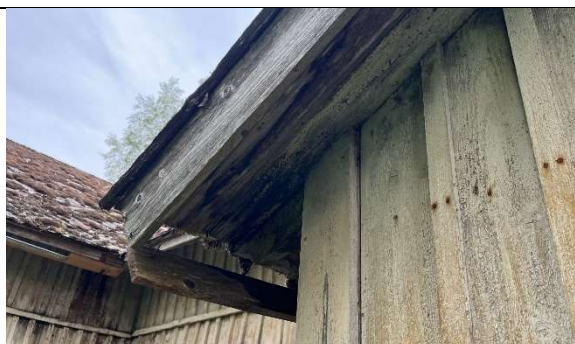
Kuva 15 Lahonneita räystäsrakenteita.
