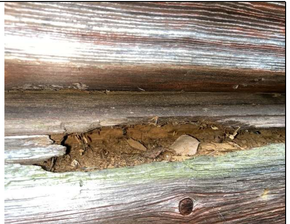
Kuva 35 Ulkoseinähirsissä lahovaurioita.
