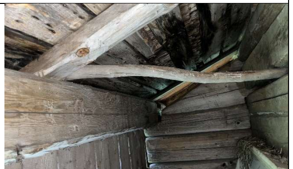
Kuva 30 Ulkoseinähirsien lahovaurioita.
