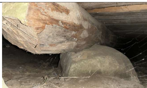
Kuva 18 Alapohjaa ja ryömintätilaa.
