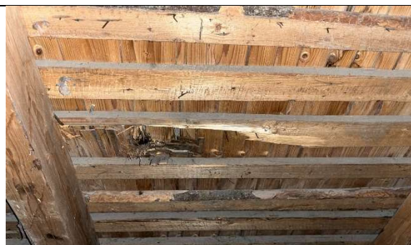
Kuva 16 Yläpohjan kosteusvaurioita.
