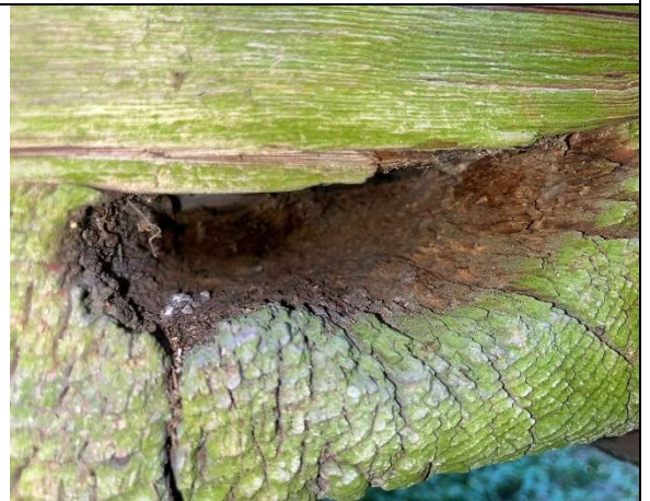
Kuva 37 Lattialankuissa lahovaurioita.
