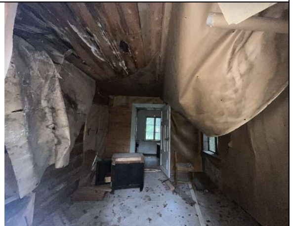
Kuva 23 Välipohjan lahovaurioita.
