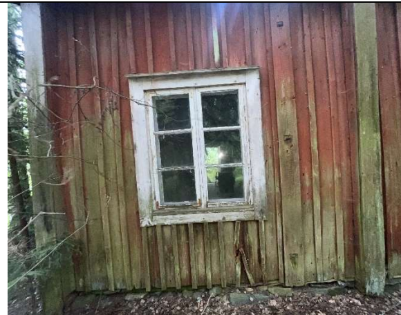
Kuva 24 Ulkoseinäverhousta.
