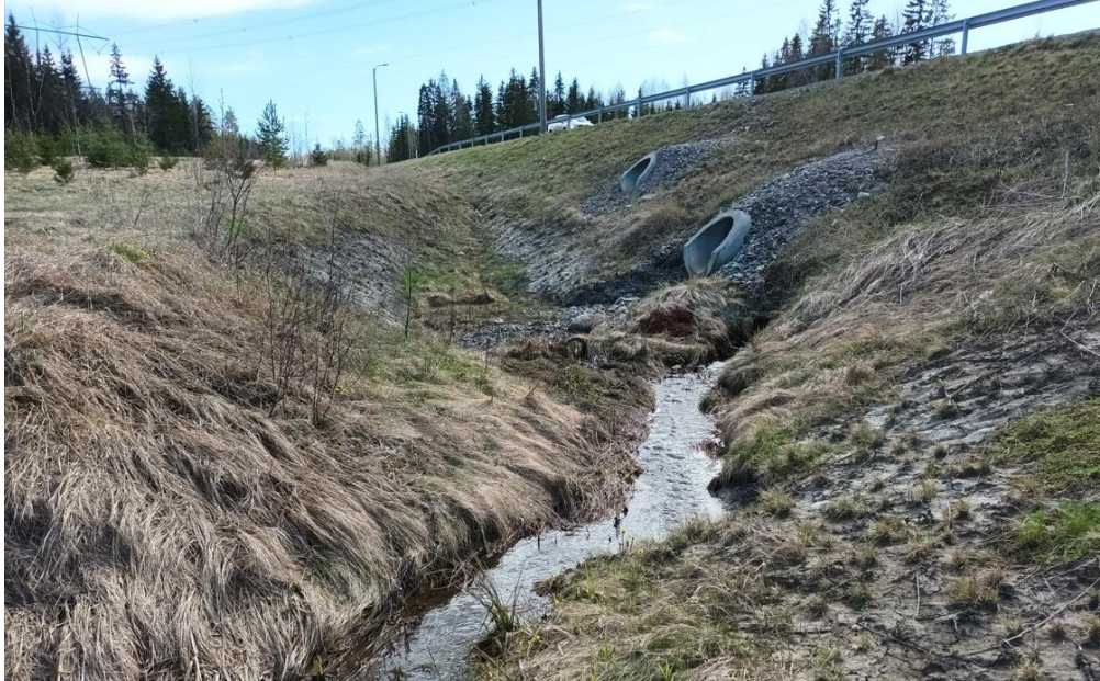
Kuva 10. Klaukkalan kehätien alittavat rummut kehätien itäpuolella. [Ramboll 5/2024]
