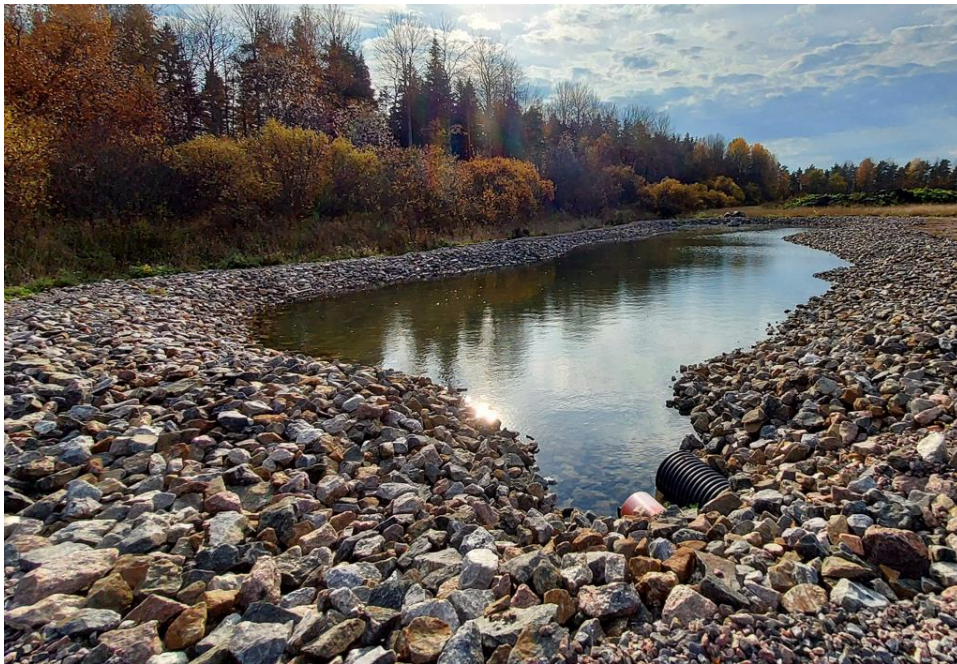
Kuvat 18. Maanpäällisillä hulevesien hallintarakenteissa voidaan viivyttää hulevesiä sekä parantaa niiden laatua [Ramboll 2021].
