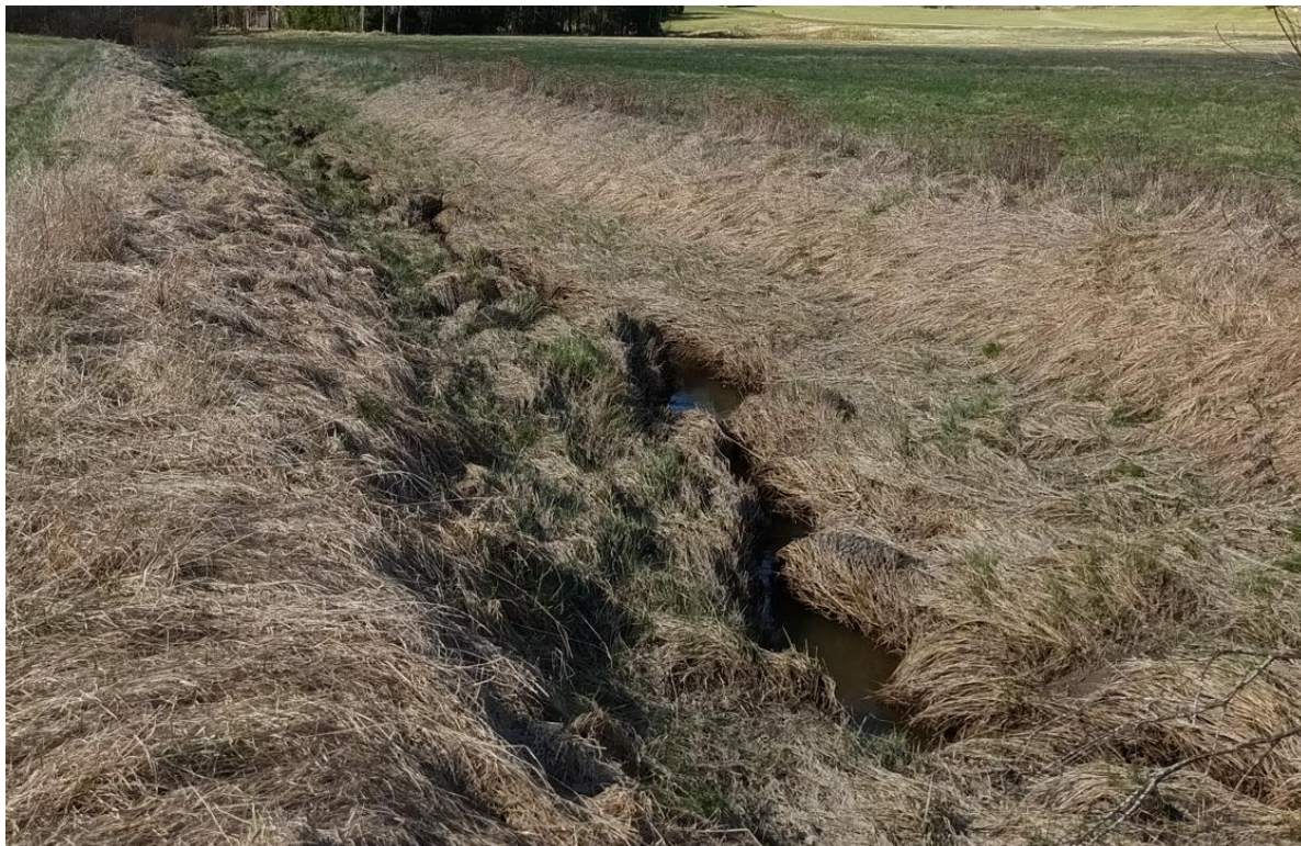
Kuva 7. Yleiskuva suunnittelualueelta, nykyinen oja ja vesien purkureitti suunnittelualueelta luoteeseen. [Ramboll 5/2024]
