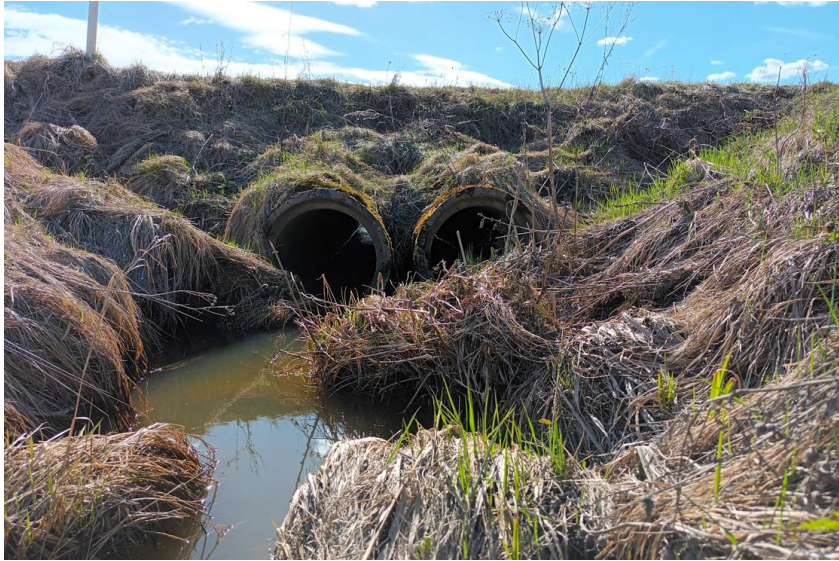
Kuva 12. Aittakalliontien alittavat 600 mm betonirummut suunnittelualueen pohjoisosassa. [Ramboll 5/2024]
