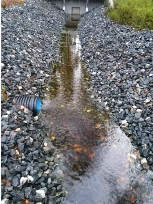
Vihtilammen pato Sääksojan suuntaan ja sivuojan vedet tuova putki.
