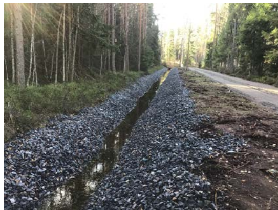
Sääksojan yläjuoksun eroosiosuojattu uoma.
