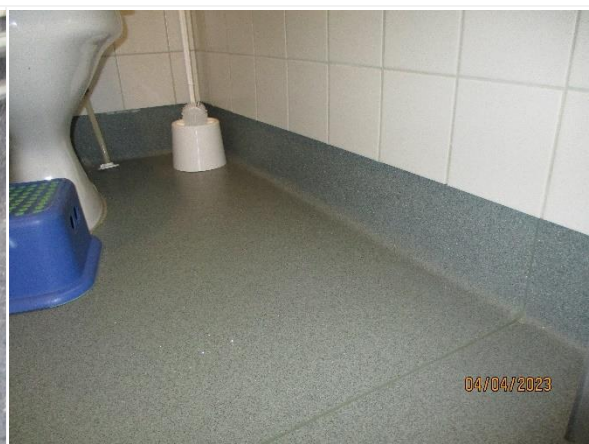
Kuva 20. Märkätilojen muovimatot ovat pääsääntöisesti hyväkuntoisia.
