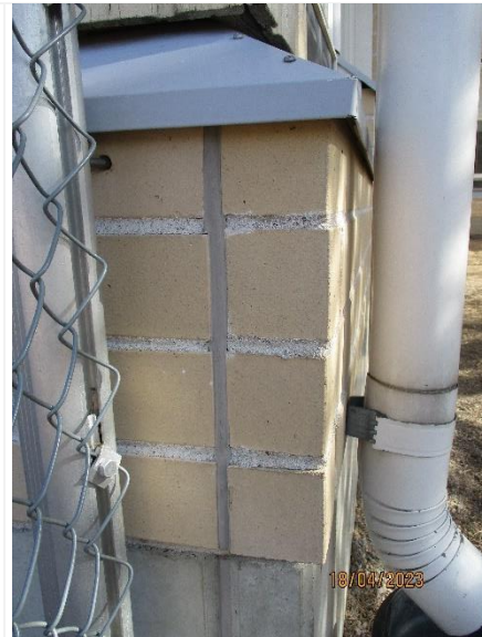
Kuva 29. Julkisivumuurauksen liikuntasäama.
