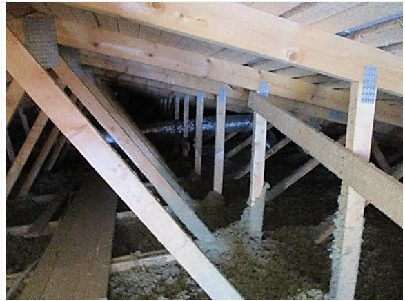
Kuva 35. Yläpohjatilaa rakennuksen laajennusosalla.
