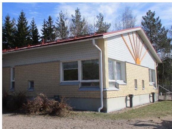
Kuva 26. Julkisivupinnat ovat hyväkuntoisia.
