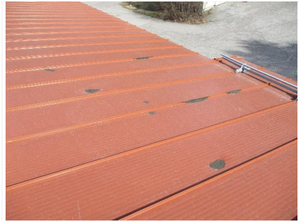
Kuva 39. Vesikatteen pinnoitteeseen on tehty paikkakorjauksia.
