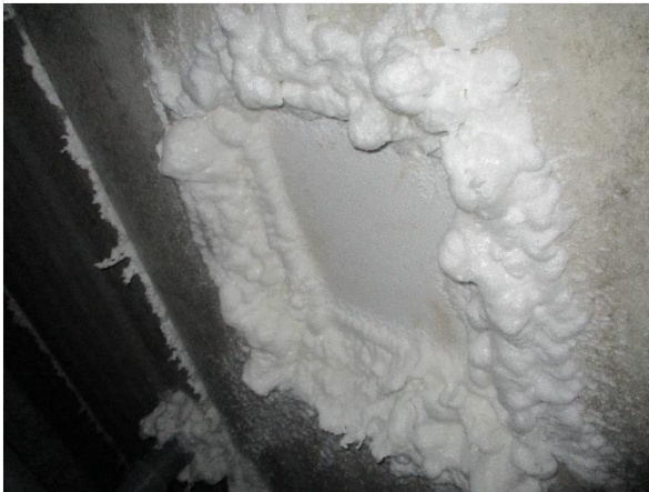
Kuva 18. Käytöstä poistettu alapohjarakenteen kulkuluukku.
