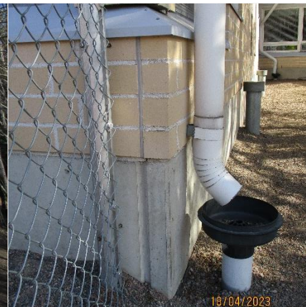
Kuva 4. Kattosadevedet on johdettu syöksytorvilla rännikaivoihin.
