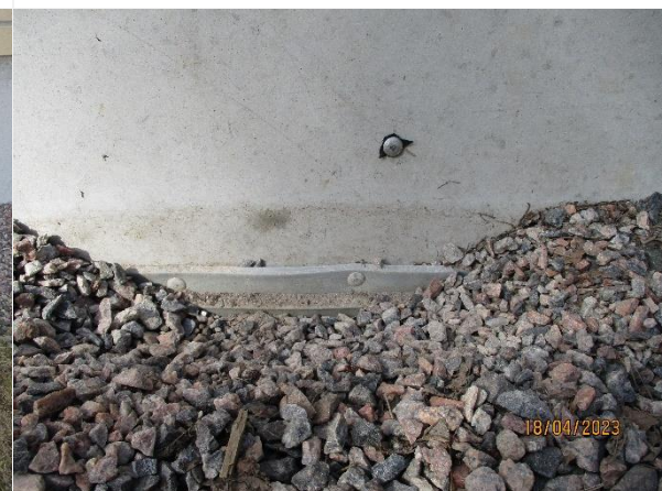
Kuva 6. Sokkelin ulkopintaan on asennettu perusmuurilevy vedeneristeeksi.
