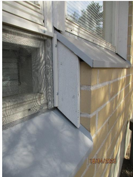
Kuva 28. Ikkunoiden vesipelleissä ei havaittu puutteita.
