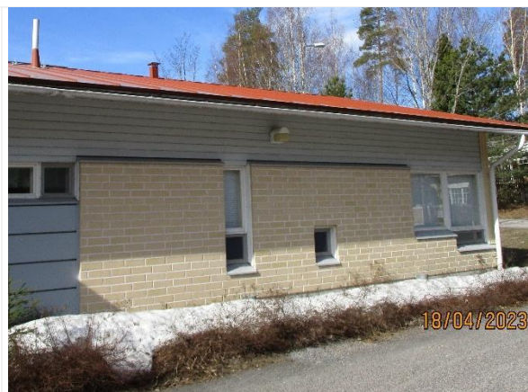
Kuva 27. Julkisivupinnat ovat hyväkuntoisia.
