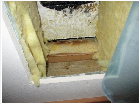
Kuva 25. Ulkoseinän rakenneavaus RA2.
