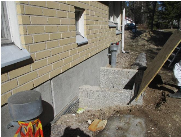
Kuva 14. Kulkutie rakennuksen laajennusosan alapohjatilaan.
