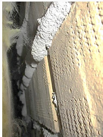
Kuva 24. Tuuletusrako julkisivumuurauksen takana RA1.
