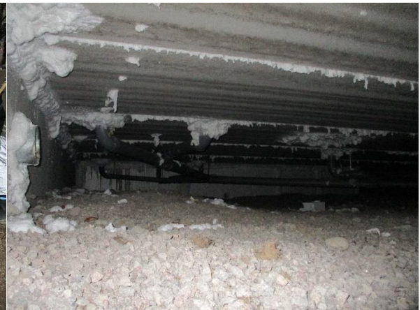
Kuva 15. Rakennuksen laajennusosan alapohjatila.
