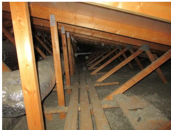
Kuva 32. Yläpohjatilaa rakennuksen alkuperäisellä osalla.
