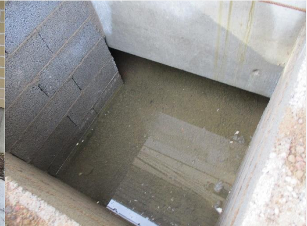
Kuva 13. Alapohjatilan kulkutie on kaivettu sala-ojitustason alapuolelle.
