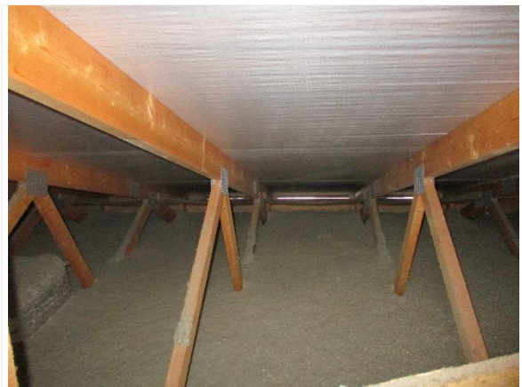
Kuva 33. Yläpohjatilaa vesikaton yläräystäälle päin, alkuperäinen rakennusosa.
