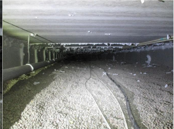
Kuva 17. Rakennuksen laajennusosan alapohjatiilaa.
