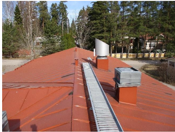
Kuva 38. Vesikattoa rakennuksen alkuperäisellä osalla.
