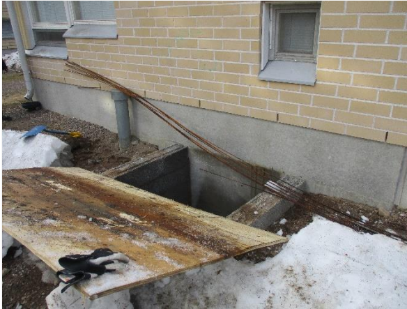
Kuva 12. Kulkutie alkuperäisen osan alapohjatilaan.
