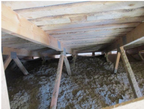
Kuva 36. Yläpohjatilaa vesikaton yläräystäälle päin, laajennusosa.
