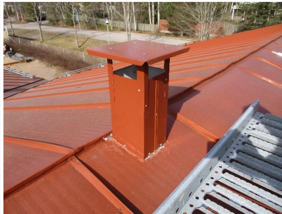
Kuva 40. Ylösnostojen pellityksissä ei havaittu puutteita.
