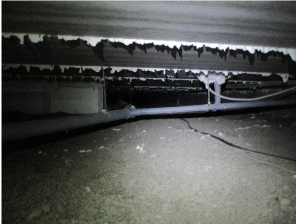
Kuva 16. Rakennuksen laajennusosan alapohjatiilaa.
