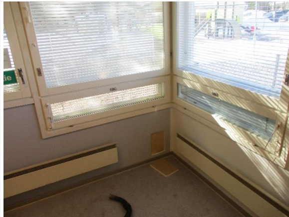
Kuva 22. Ulkoseinän rakenneavaus RA1.
