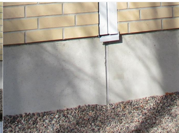
Kuva 9. Sokkelin elementtisaumat ovat hyväkuntoisia.
