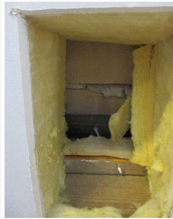
Kuva 23. Ulkoseinän rakenneavaus RA1.
