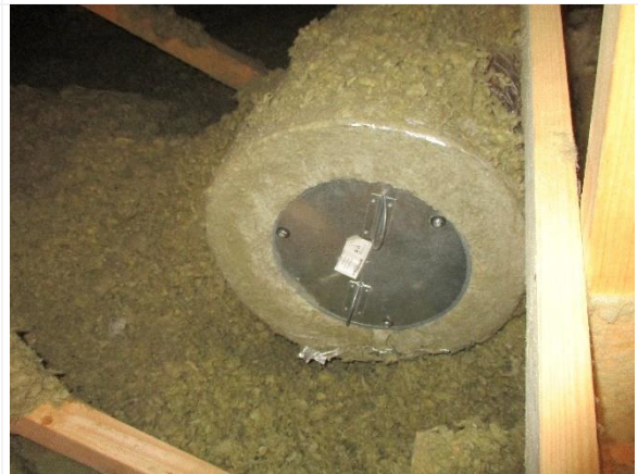
Kuva 37. Ilmanvaihtokanavien puhdistusluukut ovat yläpohjan eristekerroksessa, laajennusosa.
