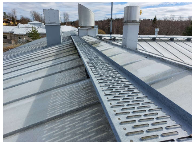
Kuva 83. Kulku vesikatolla on toteutettu asianmukaisesti.
