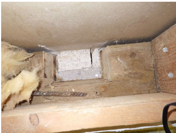
Kuva 49. Kuvaa rakenneavauksen sisältä.
