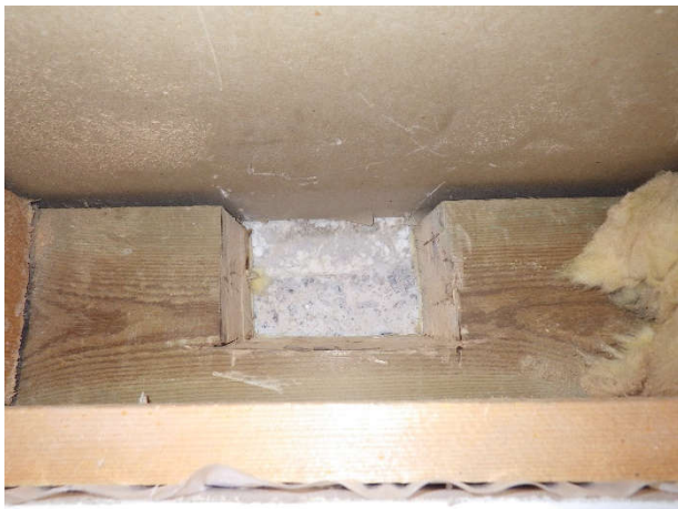
Kuva 33. Kuvaa rakennearauksen sisältä.
