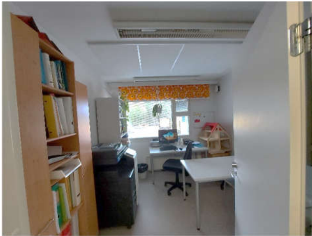
Kuva 73. Päiväkodin johtajan huoneen akustiikkalevyverhoilua katossa.
