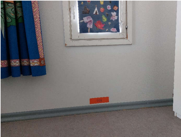
Kuva 51. Rakenneavaus 6 tehtiin tilan 17 koillisseinään.
