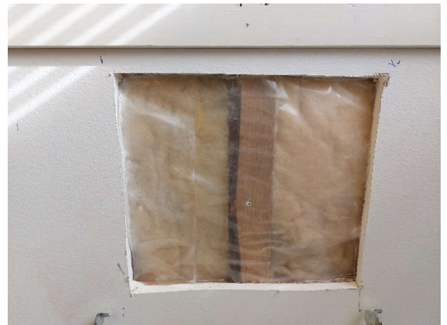
Kuva 56. Lämmöneristeiden sisäpinnalla ei havaittu viitteitä kosteus- ja mikrobivaurioista.
