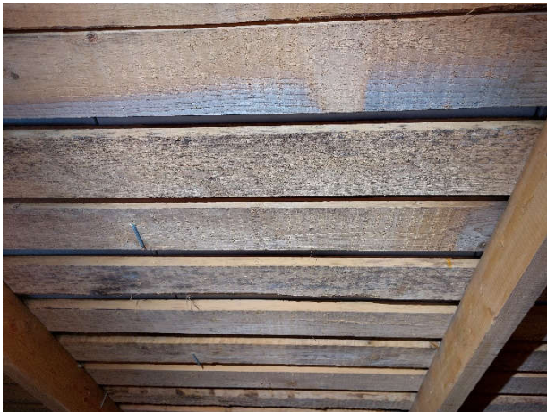
Kuva 90. Aluslaudoituksessa mikrobivaurio.
