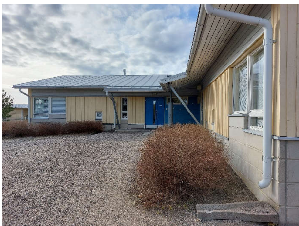
Kuva 13. Rakennuksen julkisivua sisäpihalla.
