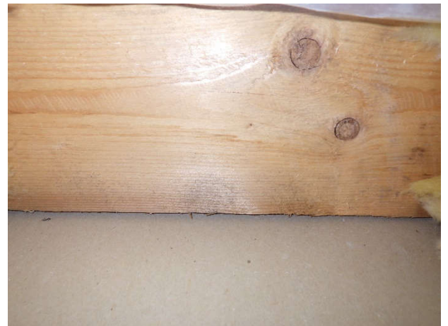
Kuva 38. Ikkunan apukarmissa ei havaittu aistinvaraisesti arvioituna viitteitä kosteus- tai mikrobivaurioista.
