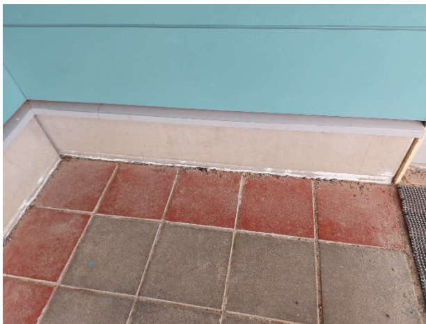
Kuva 17. Sokkeleissa havaittiin kosteuden aiheuttamia jälkiä.
