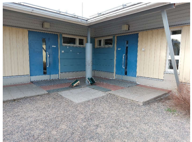
Kuva 14. Sisäänkäynnin edustalla oleva betonilaatta on kivilaatoitettu.
