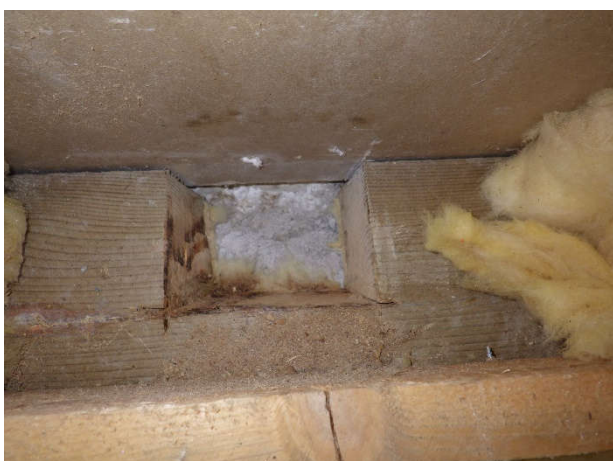
Kuva 41. Kuvaa rakenneavauksen sisältä.
