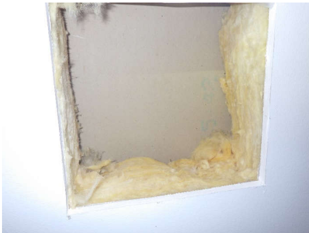
Kuva 37. Tuulensuojalevyn sisäpinnalla ei havaittu aistinvaraisesti arvioituna viitteitä kosteus- tai mikrobivaurioista.
