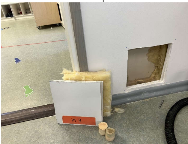
Kuva 69. Väliseinäavausta.
