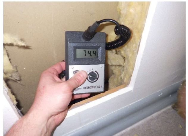
Kuva 34. Sokkelin yläpinnassa ei havaittu kohonneita lukemia pintakosteudentunnistimella.
