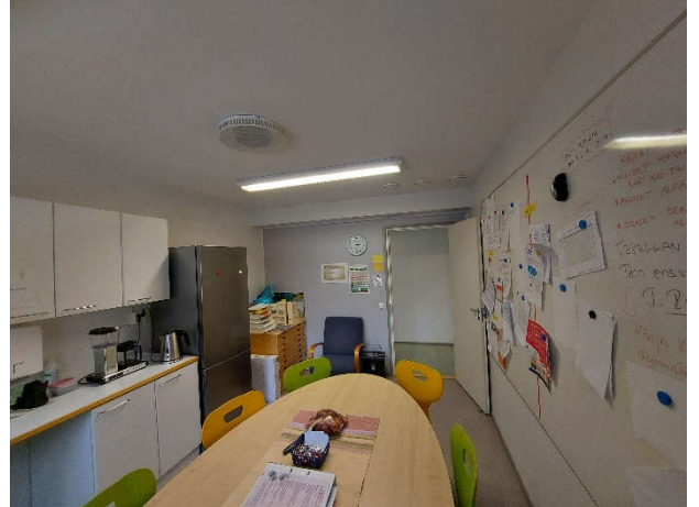
Kuva 72. Henkilökunnan taukotilassa on kipsilevykatto.
