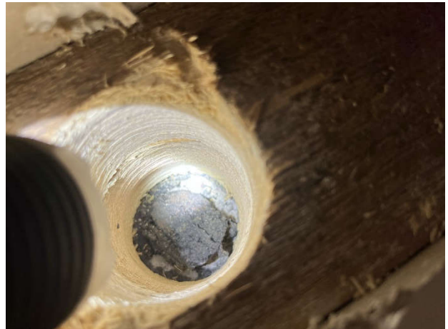
Kuva 66. Alaohjauspuun alla on bitumikermi.
