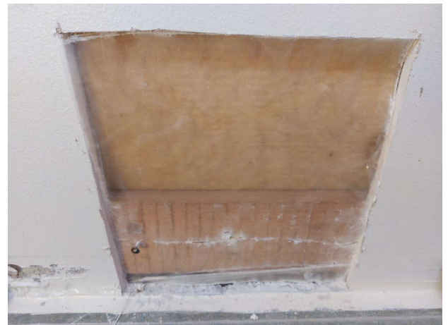
Kuva 60. Lämmöneristeiden sisäpinnalla ei havaittu viitteitä kosteus- ja mikrobivaurioista.
