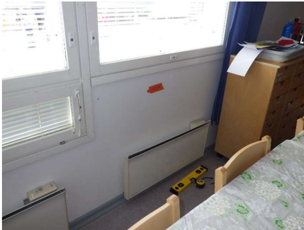
Kuva 35. Rakenneavaus 2 tehtiin tilan 25 lounaan puoleiselle seinustalle.
