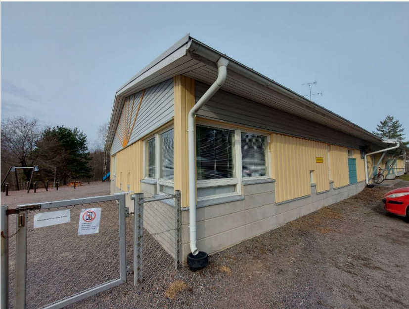
Kuva 5. Isosuon päiväkoti, rakennuksen takaosaa.
