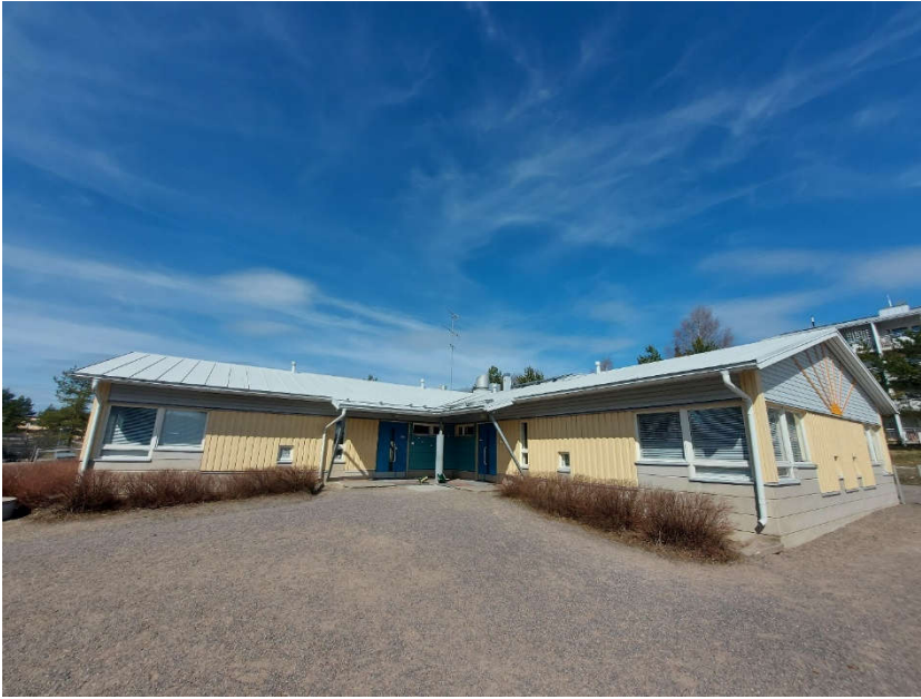
Kuva 4. Isosuon päiväkoti, sisäpihaa.
