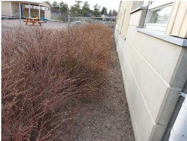
Kuva 15. Istutukset on toteutettu asianmukaisesti.
