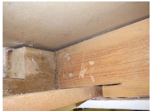
Kuva 50. Kuvaa rakenneavauksen sisältä.
