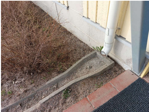
Kuva 9. Osa kattosadevesistä ohjataan betonikouruilla pois rakennuksen vierustalta.
