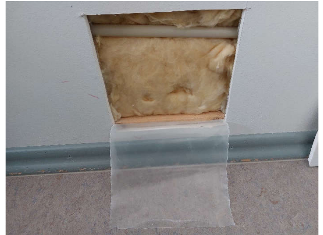
Kuva 52. Lämmöneristeissä ei havaittu puutteita.
