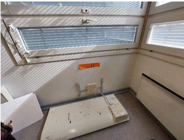
Kuva 55. Rakenneavaus 7 tehtiin tilan 18 koillisseinään.
