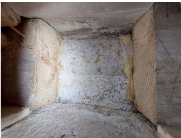
Kuva 53. Kuvaa rakenneavauksen sisältä.
