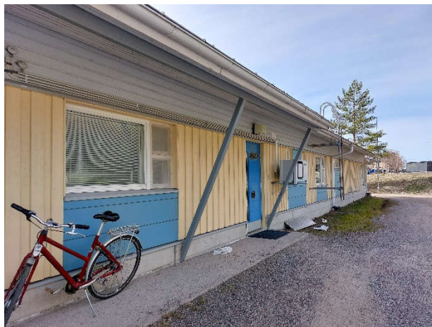
Kuva 7. Yleiskuvaa rakennuksen vierustalta.
