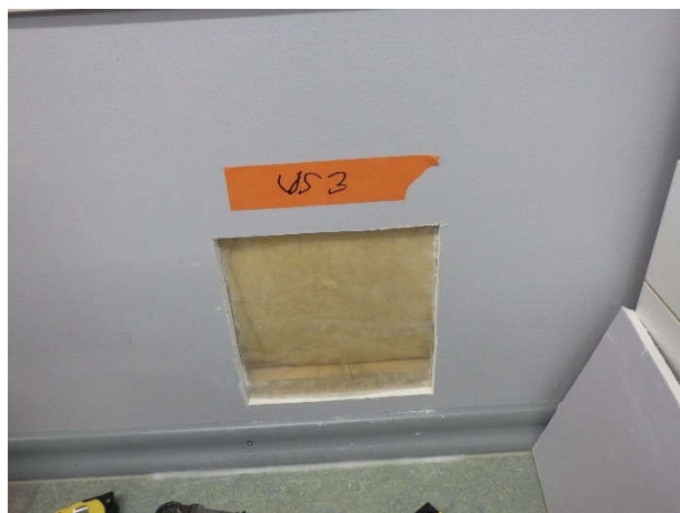
Kuva 40. Lämmöneristeessä ei havaittu puutteita.
