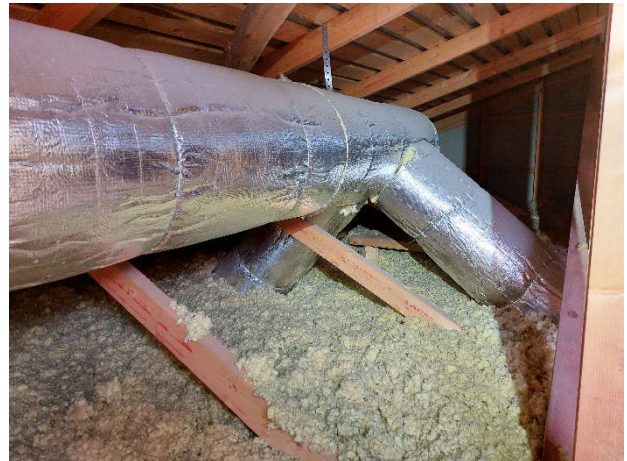
Kuva 91. Ilmanvaihtokanavia.
