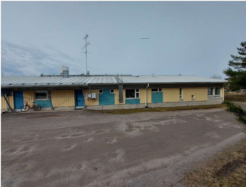
Kuva 6. Isosuon päiväkotii, rakennuksen takaosaa.
