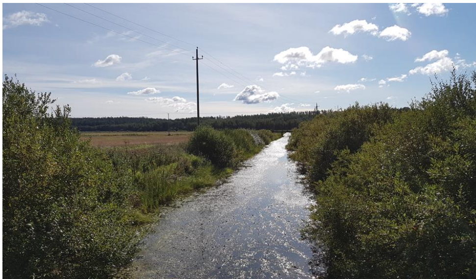
Kuva 10. Vanhalta järveltä tuleva kuivatusoja pumppaamolta päin katsottuna, josta vedet pumpataan Kyläjokeen. [Ramboll 9/2021]
