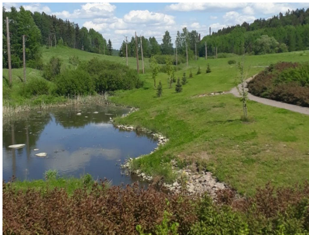
Kuva 6. Alueen pohjoispuolella on jo rakennettu hulevesien viivytyksallas.
