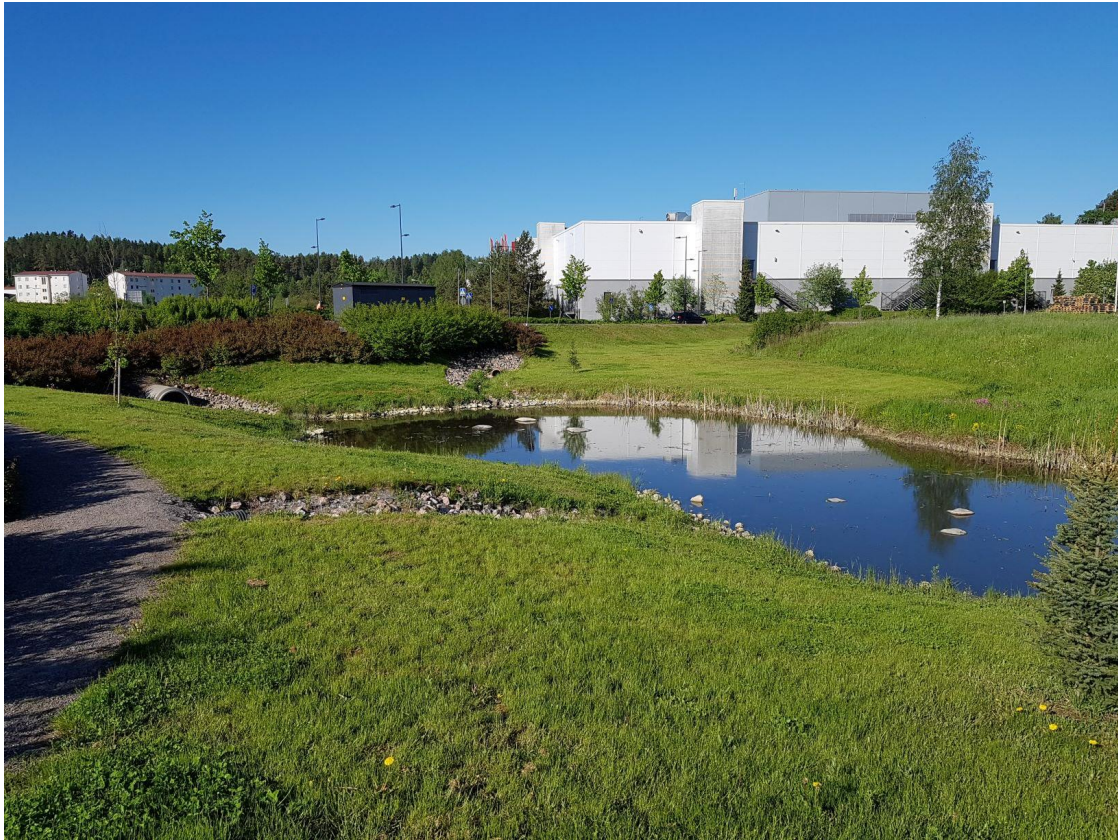
Kuva 12. Rakennettu hulevesiallas Viirintien pohjoispuolella. [Ramboll 6/2021]
