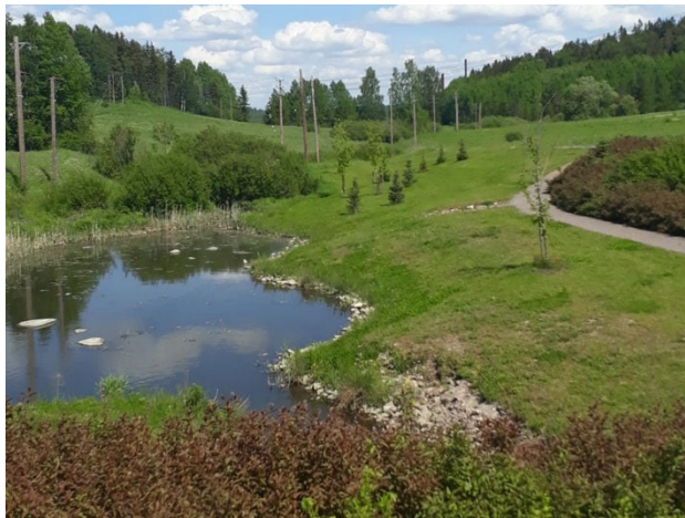
Kuva 6. Alueen pohjoispuolella on jo rakennettu hulevesien viivytysallas.
