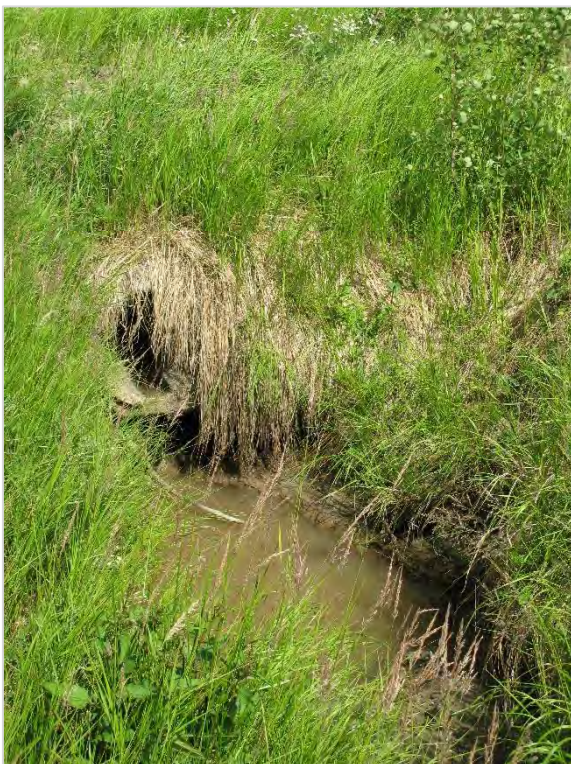
Kuva 10. Rumpuputken toisella puolella veden väri muuttuu ruskeaksi. Kuivana aikana rumpu on nousuete ylävirtaan mahdollisesti pyrkiville kaloille
