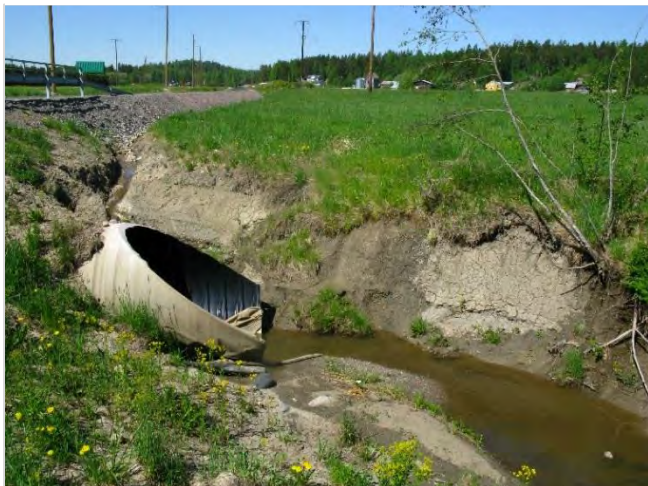
Kuva 1. Rajamäentien alittava rumpu on mitoitukseltaan riittävä.
