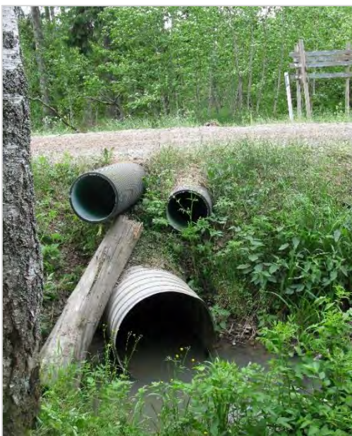
Kuva 17. Heinojan tien alittavat kolme rumpua.
