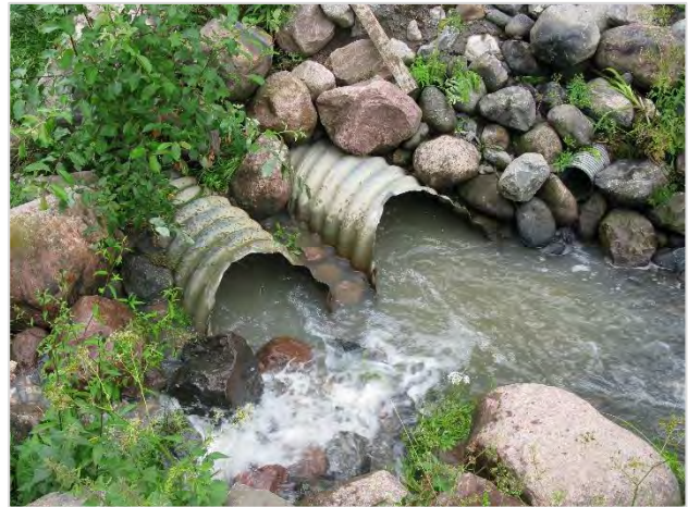
Kuva 15. Yksittäisen rankkasateen jälkeisenä aamuna vesi on miltei täyttänyt Aspinniituntien rummut. Vettä oli edellisenä iltana satanut 26 mm Röykän mittauspisteellä (Sademäärä 5.7.2018).
