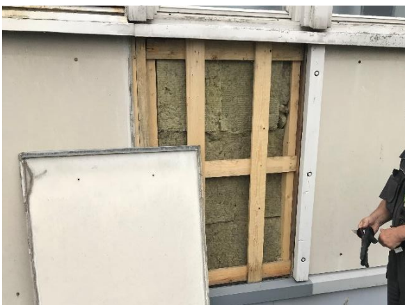
Kuva 75 Levyrakenteen takana eristeenä on käytetty mineraalivillaa. Seinärakenne on ollut paikallisesti avattuna (ilmanvaihtokoneiden haalausaukko). Seinärakenne on muilta osin alkuperäinen puurunkorakenne (vinolaudoitettu ja mineraalivillalla eristetty rakenne).
