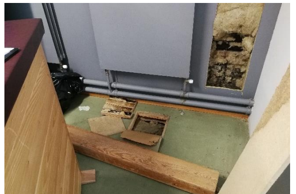
Kuva 98 Telinevaraston/patjavaraston 112 välipohjan rakenneavaus (VP3)
