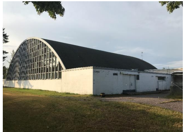
Kuva 62 Yleiskuva halli-/varasto-osan tiili- ja betonijulkisivuista.
