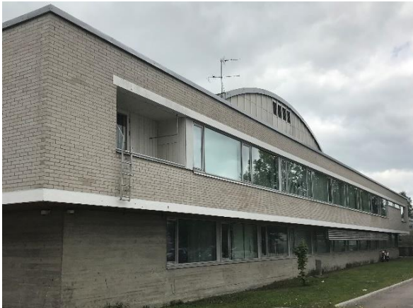
Kuva 59 Yleiskuuvaa rakennuksen eteläpuoleisesta tiili- ja betonijulkisivusta.
