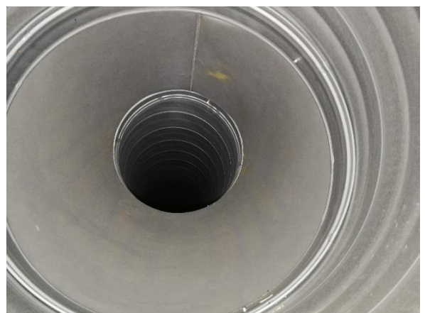
Kuva 151 Tanssisalin K50B pinnalla havaittiin jonkin verran pölyä.
