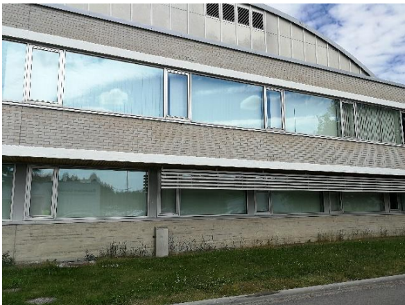
Kuva 76 Rakennuksen eteläseinustalla ikkunat ovat uusittuja MEK-tyypin alumiinirunkoisia ikkunoita.
