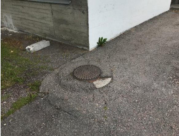
Kuva 17 Huonetilan K17 ulkokulmauksessa sijaitseva tarkastuskaivo.
