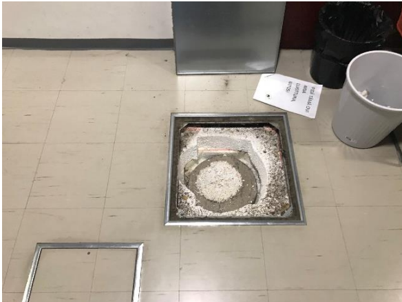
Kuva 11 Pohjakerroskäytävä K05A luokkahuoneiden edustalla. Käytävällä sijaitsee ko. käytäväalueelle uusitun salaojan tarkastuskaivo.
