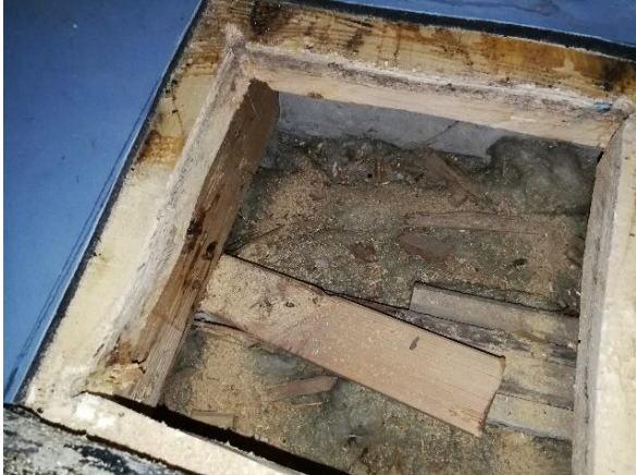
Kuva 95 Liikuntasalin välipohjan eristeenä on käytetty mineraalivillaa.
