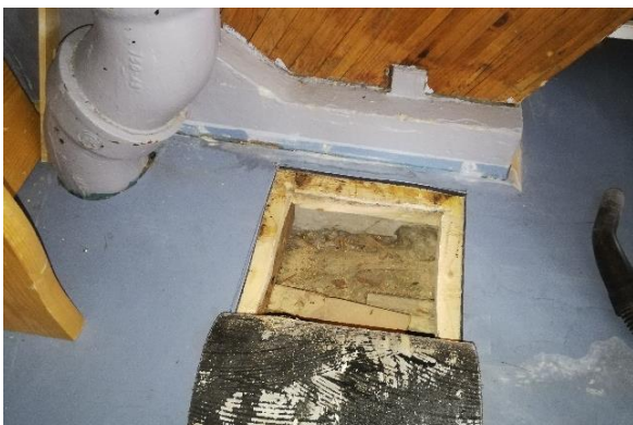
Kuva 93 Liikuntasalin välipohjan rakenneavaus (VP1) tehtiin kattovesien viemäroinnin viereen.
