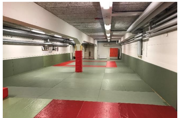
Kuva 44 Yleiskuva budosalista. Salin lattia on alkuperäisen betonilaatan päältä puukolattu levyrakenteinen lattia (ilmaväli levyn ja betonilattian välissä), jonka päälle pehmustepatjat on asennettu.
