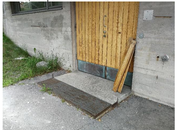
Kuva 83 Ensimmäisen kerroksen ulko-ovet ovat puurunkoisia.
