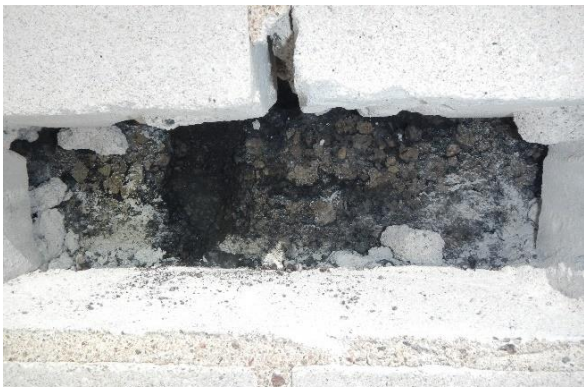
Kuva 67 Kalkkijiekkatiilen takana lämmöneristeenä on käytetty korkkia.
