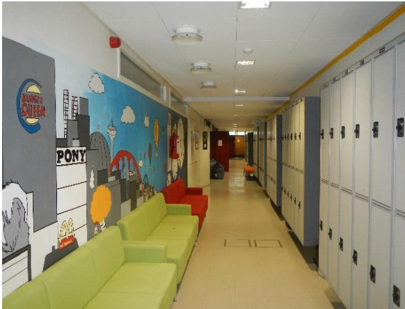
Kuva 45 Yleiskuva pohjakerroksen käytävätilasta varsinaisten luokkahuonetilojen vierustalla. Lattiatarakeet ovat pintakuivia, poikkeavaa kosteutta ei havaittu. Myöskään luokkahuonetilojen lattioissa ei havaittu poikkeavaa kosteutta.
