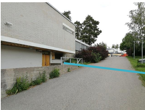
Kuva 5 Rakennuksen itäseinustalla sisäänkäynnin yhteyteen on rakennettu pengerrys.
