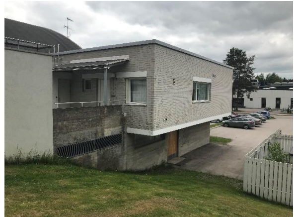
Kuva 60 Yleiskuuvaa rakennuksen tiili- ja betonijulkisivusta.
