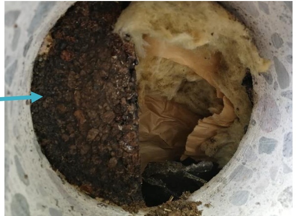
Kuva 72 Eristeenä on käytetty paperoitua mineraalivillaa ja pilarin kohdalla on käytetty korkkieristettä.
