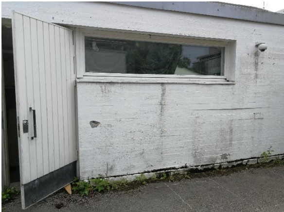
Kuva 55 Yleiskuvaa julkisivusta rakennuksen toisen kerroksen varastotilojen (tila 130) kohdalta.
