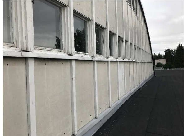
Kuva 74 Liikuntasalin ilmanvaihtokonehuoneen vastaiselle seinälle tehtiin ikkunoiden alapuolelle rakenneavaus vieriseltä lappeelta.
