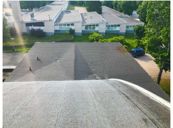
Kuva 114 Yleiskuva kaaren vesikatolta alemmalle vesikattolappeelle.
