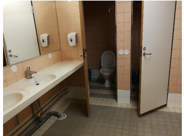
Kuva 46 Yleiskuva pohjakerroksen wc-tiloista. Lattiatarakeet ovat pintakuivia, poikkeavaa kosteutta ei havaittu.
