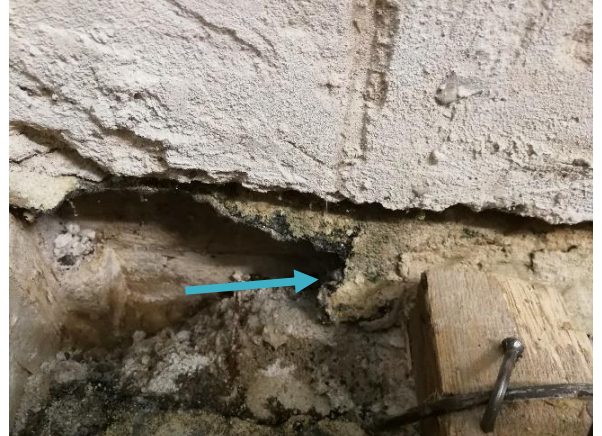
Kuva 34 Ulkoseinän alaosan bitumihuopakaista on käännetty alapohjarakennetta vasten.
