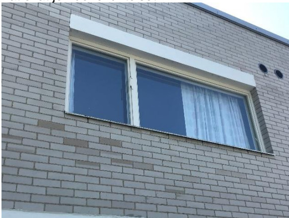
Kuva 82 Opettajanhuoneen ikkunat ovat niin ikään puurakenteiset.
