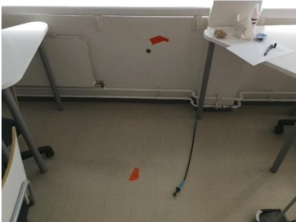
Kuva 73 Ensimmäisen kerroksen ulkoseinän mineraalivillalasteista otettiin materiaalinäytteitä pienemmistä rakenneavausrei'istä.
