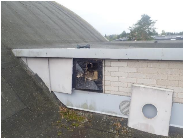
Kuva 115 Yläpohjan havaintopiste varasto-osan vesikaton ja kaariosan taitteessa.
