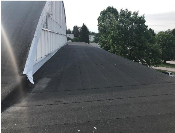
Kuva 113 Yleiskuva vesikattolappeelta eteläpuoleinen alue.
