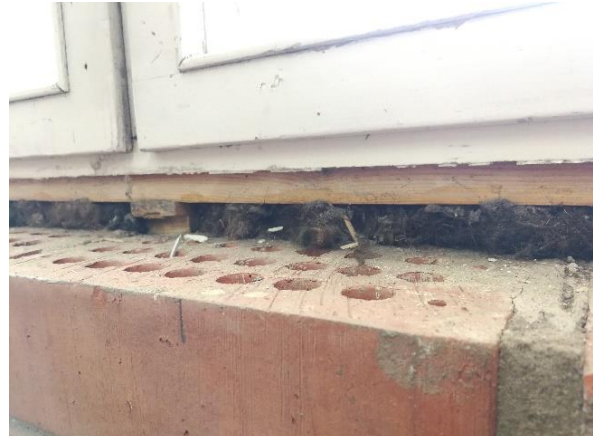
Kuva 81 Oppilaskunnan ikkunat ovat puurakenteisia ikkunoita, alkuperäinen rive-eriste.
