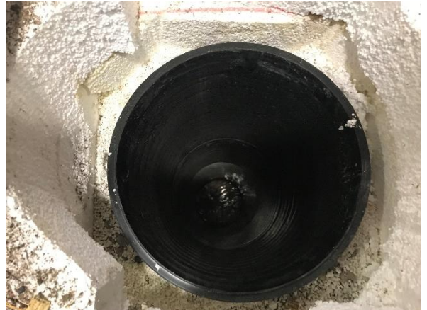
Kuva 12 Kuva edellisestä salaojan tarkastuskaivosta.
