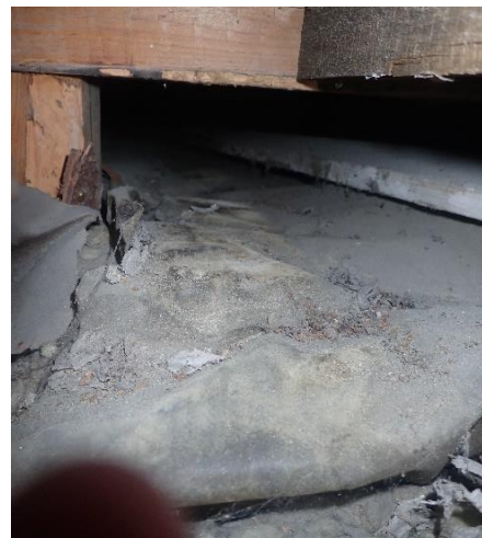
Kuva 118 Yläpohjan rakenneavauspiste (YP8), Yleiskuva yläpohjatilaan.
