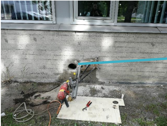
Kuva 71 Ensimmäisen kerroksen ulkoseinärakenteeseen tehtiin ulkopuolelta timanttiporaamalla rakenneavaus.
