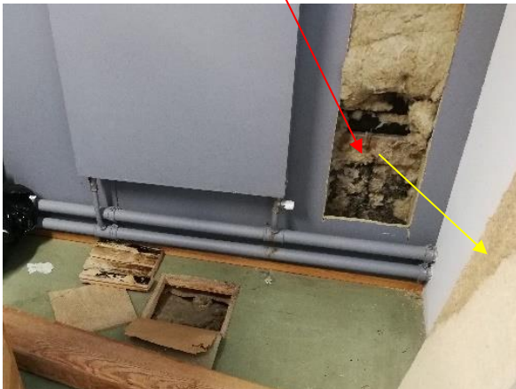
Kuva 28 Osittain maanvaraisen seinän rakennetta tarkasteltiin rakenneavauksilla liikuntasalin patjavaraston ulkoseinällä. Lastulevyseinässä seinälevyn taustapinnalla on havaittavissa selviä kosteusvauriojälkiä.
