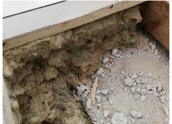
Kuva 36 Alapohjarakenne on eristetty mineraalivillalla.
