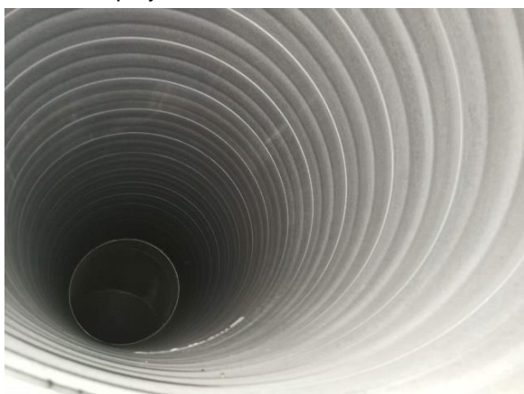
Kuva 150 Tanssisalin K50B pinnalla havaittiin jonkin verran pölyä.
