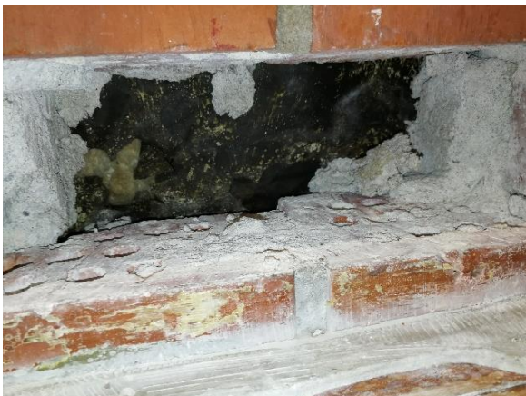
Kuva 24 Betonisen ulkokuoren sisäpinnassa on vedeneristeinä bitumisively.
