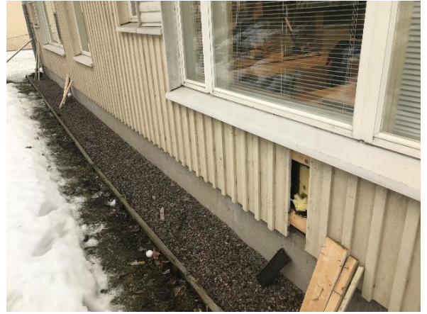
Kuva 5 Yleiskuvaa rakennuksen sokkelista.
