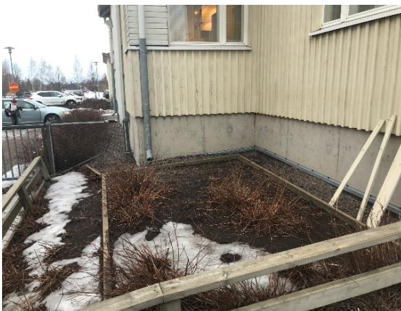
Kuva 50 Keittiösiiven edustalla pensaita rakennuksen vierustalla.
