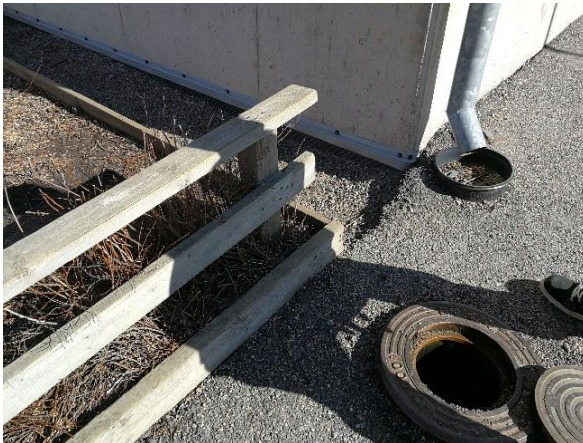
Kuva 6 Salaojien olemassaoloa tarkastettiin tarkastuskaivosta.
