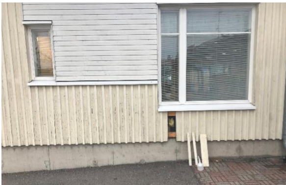
Kuva 20 Yleiskuvaa rakennuksen julkisivusta, ruokasalin kohdalta.
