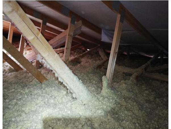
Kuva 43 Yläpohjan eristeenä on käytetty puhallusvillaä.
