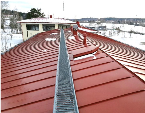
Kuva 40 Yleiskuvaa vesikatolta. Vesikate on hyväkuntoinen.
