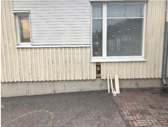
Kuva 4 Yleiskuvaa rakennuksen sokkelista.
