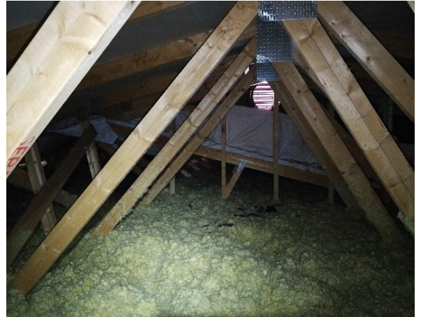
Kuva 45 Yläpohjan tuuletus tapahtuu räystäiltä sekä pää- tykolmioiden tuuletusaukoista.
