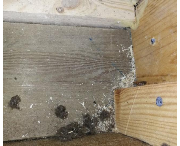
Kuva 25 Alaohjauspuuna on käytetty painekyllästettyä puutavaraa. Puurunkorakenteet ovat aistinvaraisesti havainnoiden terveistä ja vaurioitumattomia.
