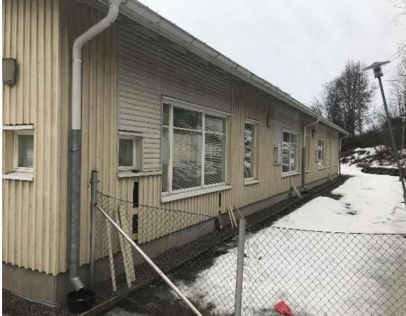
Kuva 18 Yleiskuvaa rakennuksen julkisivusta. Julkisivuverhoukset ovat hyväkuntoisia ja vaurioitumattomia.
