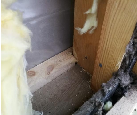
Kuva 24 Ulkoseinärakenne. Rakenneavauksia tehtiin ympäri rakennusta. Rakenneavauspisteistä todettiin yleisesti, että rakenteet ovat aistinvaraisesti havainnoiden terveitä ja vaurioitumattomia.
