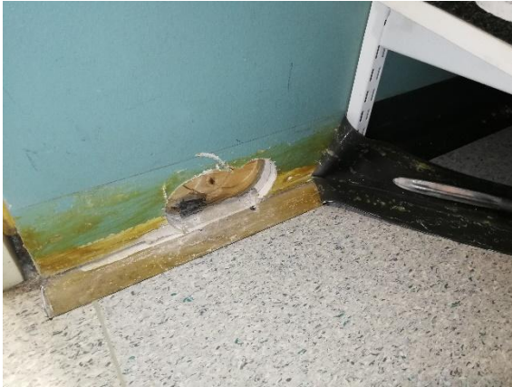
Kuva 37 Väliseinän rakennetta tarkasteltiin luokkahuoneen 106 vastaisella seinällä.
