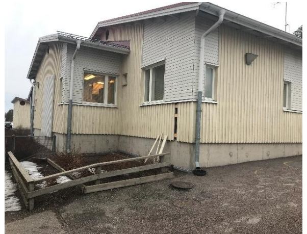
Kuva 19 Julkisivuverhouksena on pääasiassa käytetty peiterimalaudoitusta ja vaakapanelointia.
