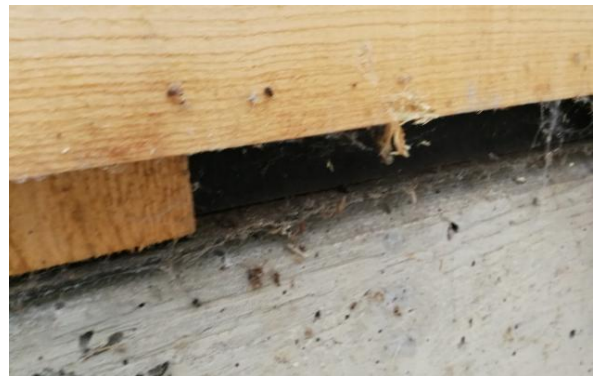
Kuva 21 Ulkoseinän alaohjauspuun alle on asennettu asianmukainen bitumihuopakaista.
