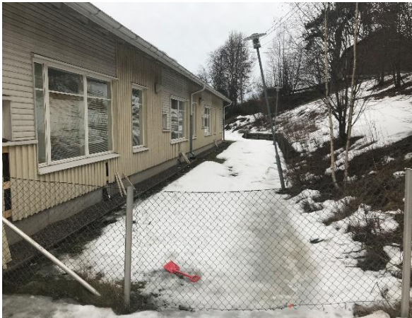
Kuva 48 Rakennus sijaitsee rinteeseen juurella. Pinta- ja valumavedet eivät rasita rakennuksen sokkelirakenteita.
