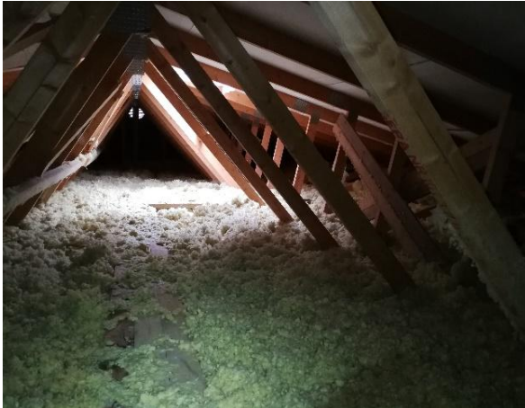
Kuva 42 Yleiskuvaa yläpohjasta. Yläpohjatilän tuuletus- vuudessa ei havaittu puutteita.
