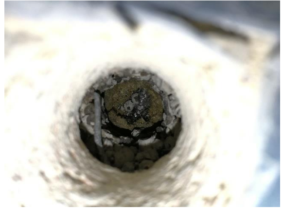
Kuva 18 Ulkoseinälinjalla alapohjassa (AP3) kulkee vanhat patteriputket, jotka on eristetty mineraalivillalla.
