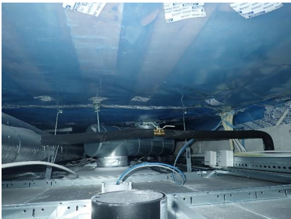
Kuva 52 Sähköläpiviennit ja alakaton kiinnikkeiden läpiviennit on tiivistetty höyrynsulkuteipillä.
