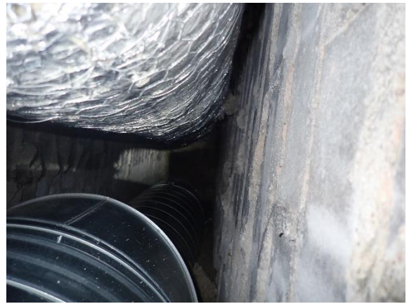
Kuva 32 Yläpohjatilaan avoimena päättyvä vanha savuhormiryhmä. Hormiryhmää on käytetty talotekniikan asennuksiin. Kuva hormin sisältä
