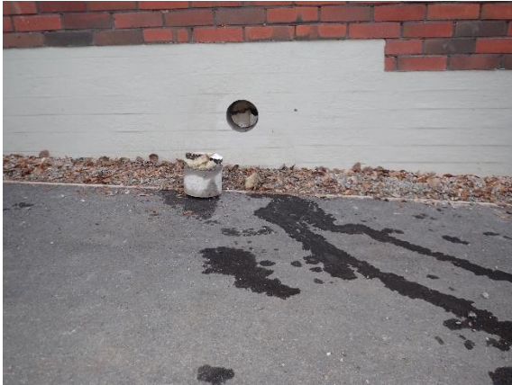
Kuva 7 Keittiön sokkelin rakenneavaus (US6). Sokkelit ovat betonirakenteisia.
