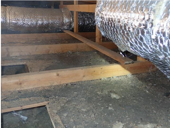
Kuva 36 Yleiskuvaa yläpohjasta. Ilmanvaihtokanavat kulkevat vanhan vesikatteen päällä, uudessa yläpohjassa.
