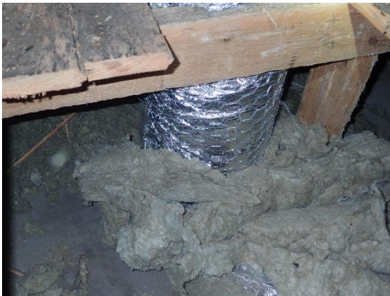
Kuva 42 Ilmavaihtoputkien läpiviennin ympärystä on lämmöneristetty mineraalivillalevyn kappaleilla.
