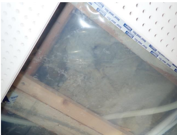
Kuva 48 Yläpohjaa on jälkikäteen tiivistetty alapuolelta höyrynsulkumuovilla.
