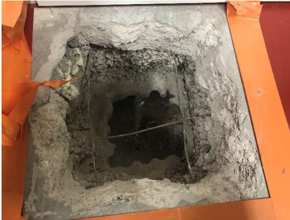
Kuva 17 Toinen suurempi alapohjan rakenneavaus (AP8) tehtiin varastoon 115.
