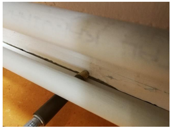
Kuva 27 Ilmavuotoa alapohjaliittymässä.
