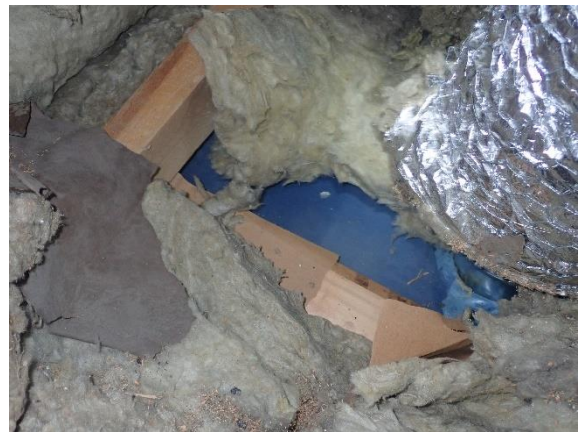
Kuva 39 Yläpohjaa on peruskorjauksen yhteydessä tiivistetty alapuolelta höyrynsulkumuovilla.
