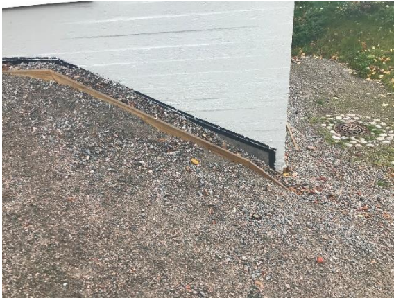
Kuva 56 Peruskorjauksen yhteydessä perusmuuria vasten on asennettu myös patolevy.
