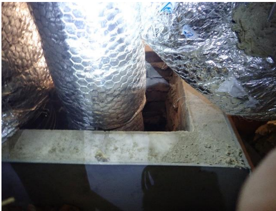
Kuva 31 Yläpohjatilaan avoimena päättyvä vanha savuhormiryhmä. Hormiryhmää on käytetty talotekniikan asennuksiin.
