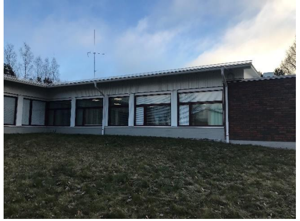
Kuva 22 Ikkunoiden alaosissa on betoninen kuorimuuri.
