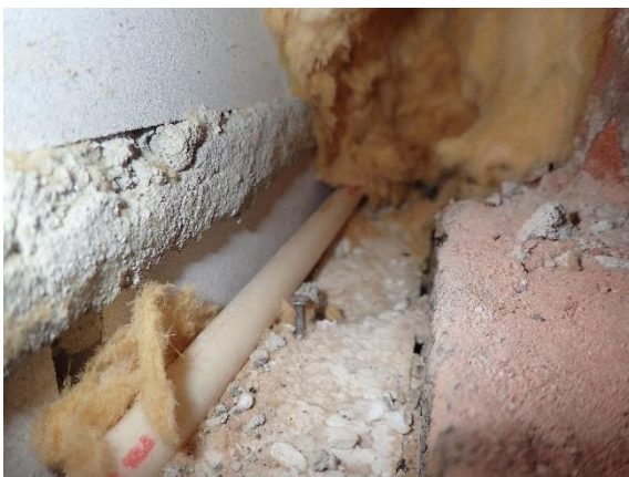
Kuva 11 Sokkelileikkauksessa eristeenä on paikoitellen käytetty EPS-eristettä (kuva US4)
