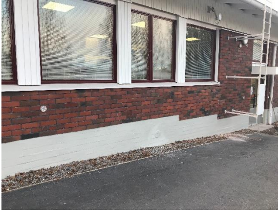
Kuva 21 Julkisivuverhouksena on käytetty pääasiassa tiiltä.
