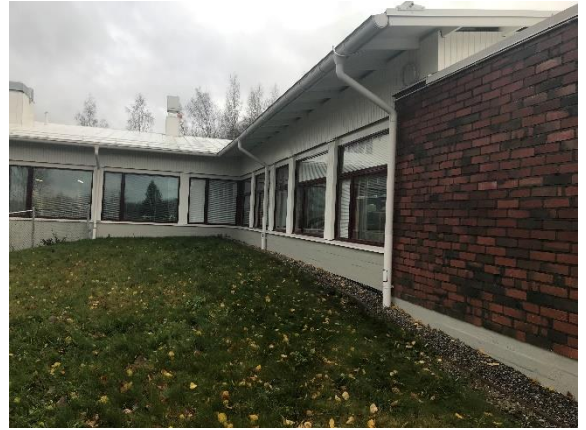
Kuva 57 Sisäpihalla maanpinta nousee lattiapinnan tasoon.
