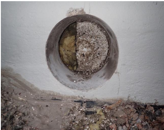
Kuva 9 Sokkelissa pilarin kohdalla eristeenä on käytetty EPS-lämmöneristettä.
