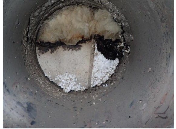
Kuva 8 Keittiön kohdalla sokkelin alaosassa käytetty EPS-eristettä, yläosassa mineraalivillaa (US6).
