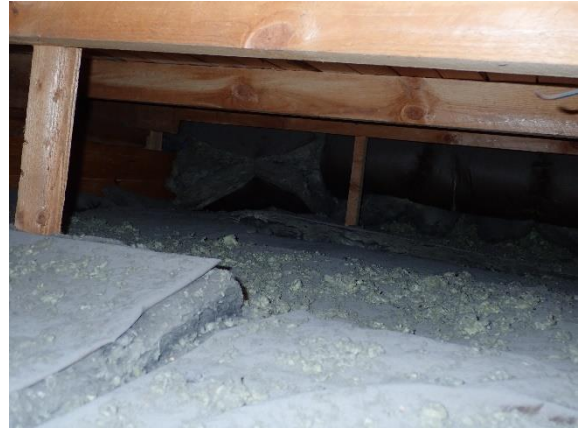
Kuva 37 Yleiskuvaa alkuperäisen vesikattorakenteen yläpohjasta.
