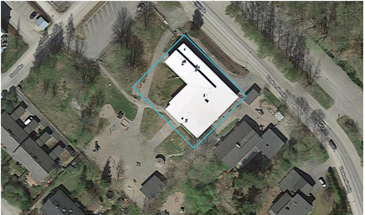
Kuva 1 Ilmakuva, tutkimuskohde korostettuna kuvassa.
