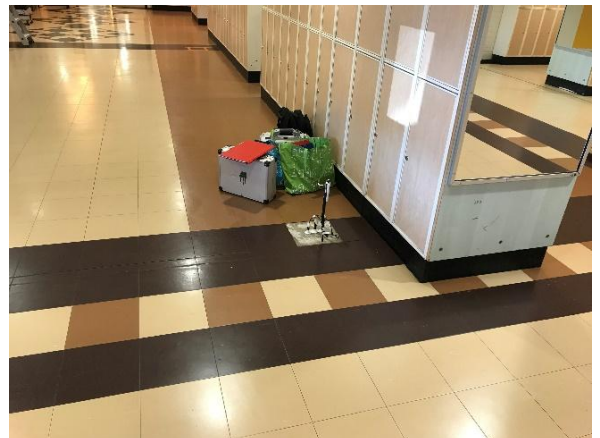
Kuva 42 Yleiskuva/esimerkki alapohjan rakennekosteus- mittauspisteistä eteisaulasta.
