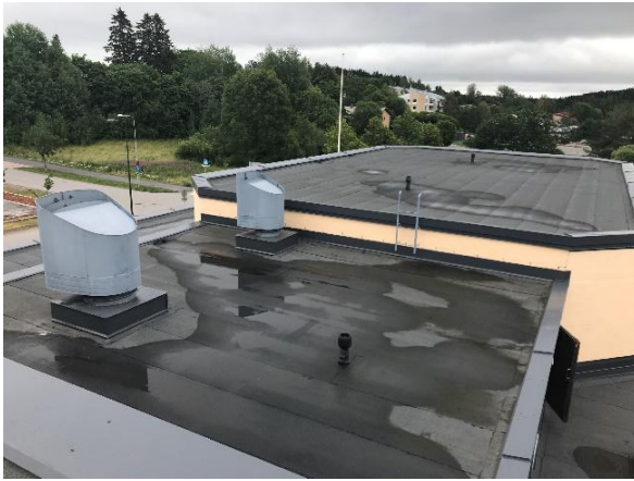
Kuva 80 Yleiskuvaa rakennuksen vesikatoilta.
