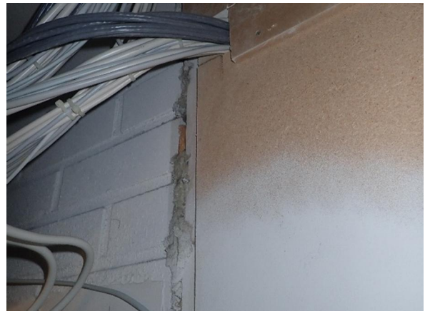
Kuva 97 Luokkatilojen ovien karmien liittymät väliseinäraukenteisiin on tiivistetty mineraalivillalla.
