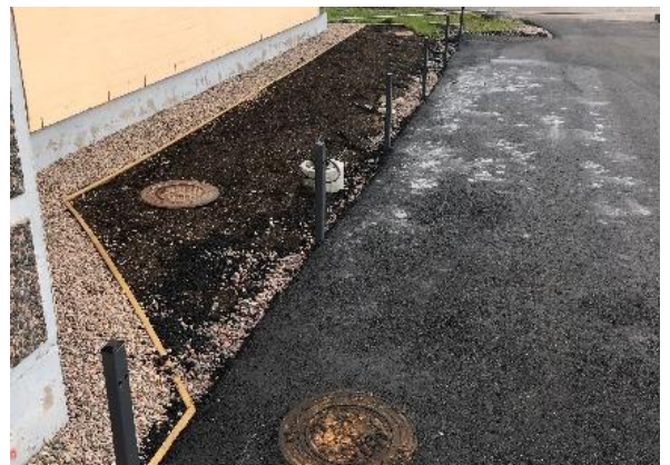
Kuva 12 Yleiskuva salaojien tarkastuskaivoista auditorion ja musiikkiluokkien puoleisella alueella.
