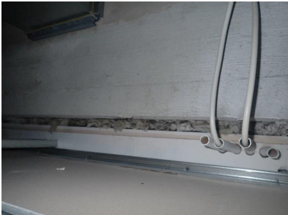
Kuva 96 Luokkatilojen ovien karmien liittymät väliseinäraukenteisiin on tiivistetty mineraalivillalla.
