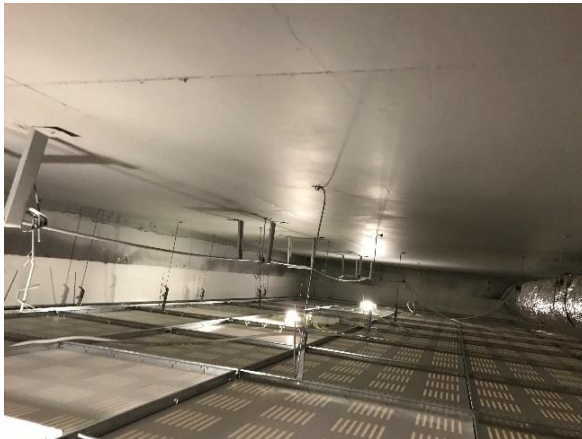
Kuva 90 Yleiskuvaa alakattojen päältä.
