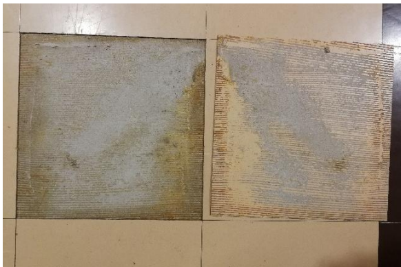
Kuva 29 Ruokailutilasta irrotettu laatta. Kosteuden aiheuttamia värimuutoksia tasoitteessa/liimajäämissä laatan reuna-alueilla. Aistinvaraisin havainnoin liima-aines on pilaantunut.
