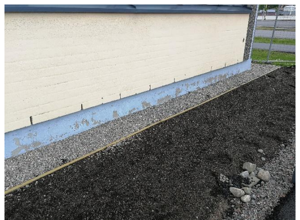
Kuva 52 Julkisivun tuulettuvuutta on jälkikäteen pyritty parantamaan avaamalla tiiliverhouksen pysytsaumoja ja tekemällä saumoihin reikiä.
