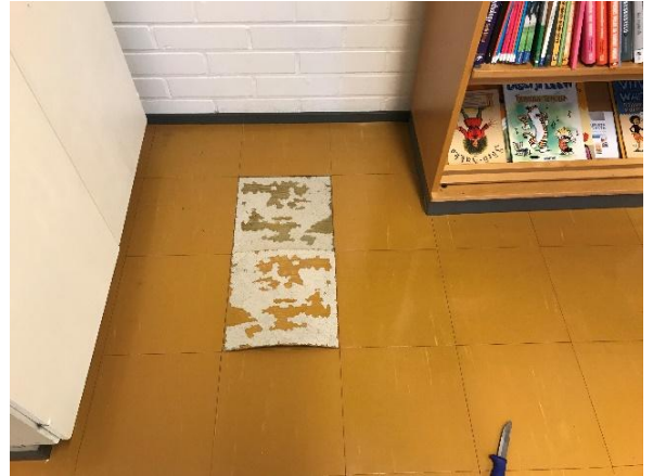
Kuva 32 Toisen kerroksen vinyylilaatoissa ei ollut havaittavissa saumojen erkaantumista tai vauriojälkiä laattojen alla. Pinnoitealustassa ei ollut havaittavissa poikkeavaa hajua.
