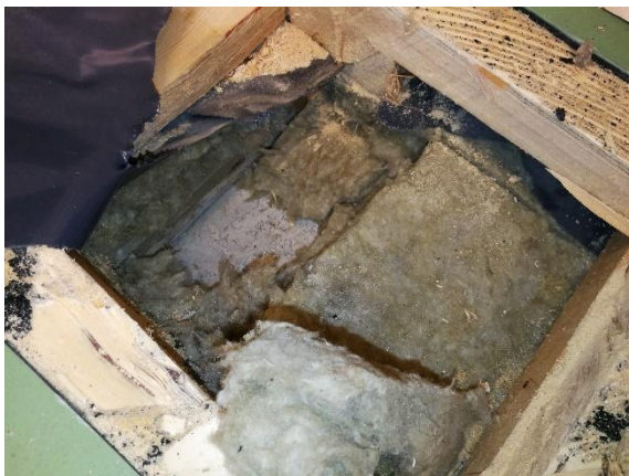
Kuva 37 Liikuntasalin lattiarakennetta. Eristeenä on käytetty mineraalivillaa.
