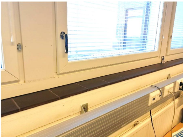
Kuva 61 Ikkunat ovat yleisesti vielä hyväkuntoisia.
