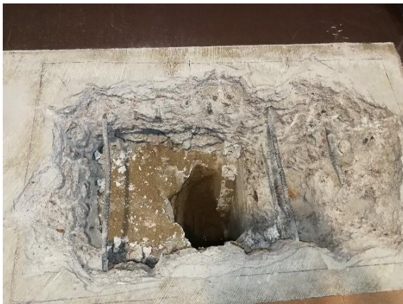
Kuva 23 Pilarianturan viereen tehty rakenneavaus.
