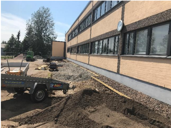
Kuva 9 Pihat oli tutkimushetkellä kaivettu auki ja pensaikot seinustalta poistettu. Rakennuksen vierustalle on asennettu sepelikaistat peruskorjauksen yhteydessä.
