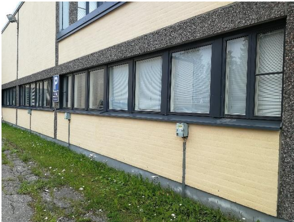
Kuva 59 Yleiskuvaa rakennuksen ikkunoista.
