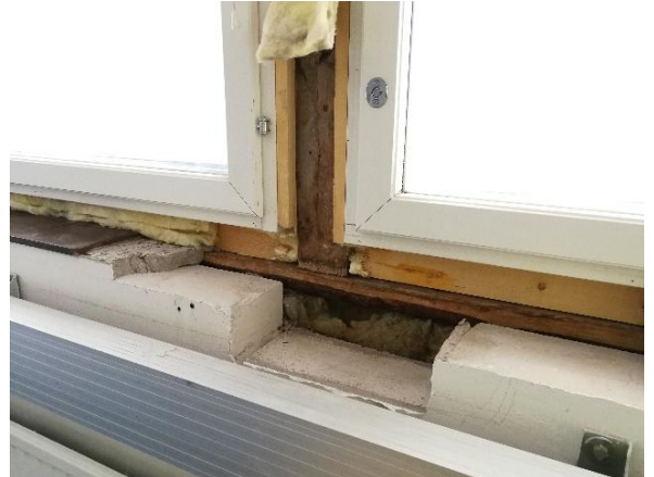
Kuva 70 Ikkunan alapuolista seinärakennetta avattuna. Ikkunan alta on avoin ilmayhteys seinän eristetilaan.
