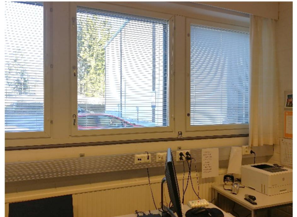
Kuva 60 Ikkunat ovat kolmilaisia MSE-ikkunoita.
