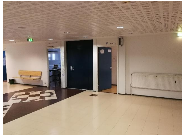
Kuva 74 Käytävätiloissa on vinyylilaatta molemmissa kerroksissa.
