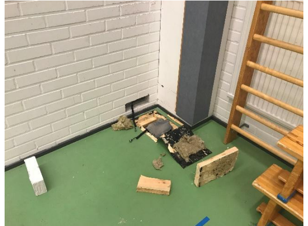
Kuva 44 Yleiskuva/esimerkki liikuntasalin alapohjan eristetilan ja maanpaineulkoseinän rakennekosteusmittauspisteistä.
