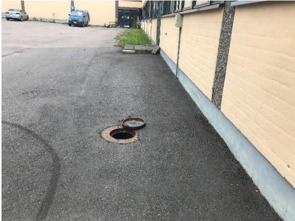
Kuva 13 Yleiskuva salaojien tarkastuskaivosta rakennuksen takapihan puoleisella alueella.
