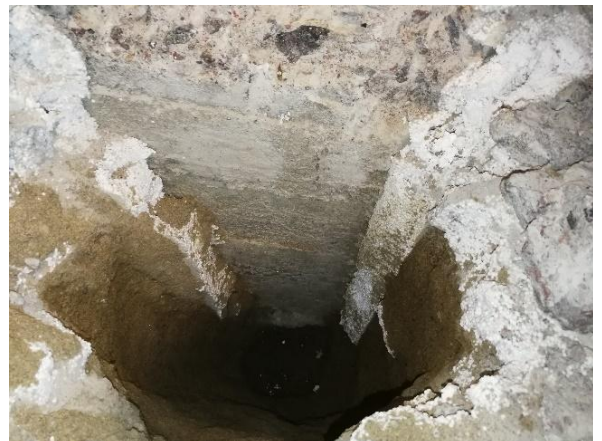
Kuva 24 Pilariantura eristetty EPS-lämmöneristeellä, maa-aines hienojakoista hiekkaa.
