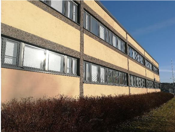
Kuva 47 Yleiskuvaa julkisivusta rakennuksen kaakkoispuolelta.
