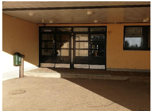
Kuva 62 Ulko-ovet ovat ikkuna-aukollisia, alumiinirunkoisia ovia. Ovet ovat pääosin hyväkuntoisia.
