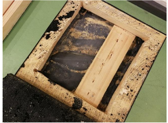
Kuva 36 Liikuntasalin lattian rakenneavaus. Lattialankkujen ja mineraalivillaeristeen välissä on muovikalvo.
