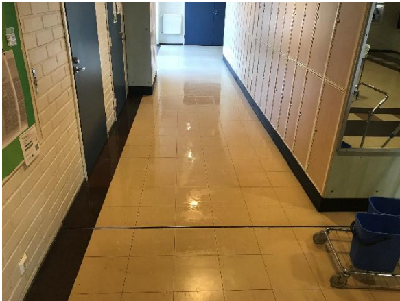
Kuva 33 Lattioiden pesun yhteydessä pinnoille jää irtovettä. Avonainen vinyylilaattasauma mahdollistaa vesien imeytymisen laatan alle.
