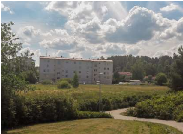
Kuva 17. Näkymä alueen pohjoispuolelta kaavoitettavalle alueelle päin, Nurmijärven kunta, asemakaavoitus, 2019. Taustalla näkyy uudempaa kerrostalotuotantoa vuosituhanen vaihteesta. Kyseinen kohde on viisikerroksinen (kerrosluvu V)
