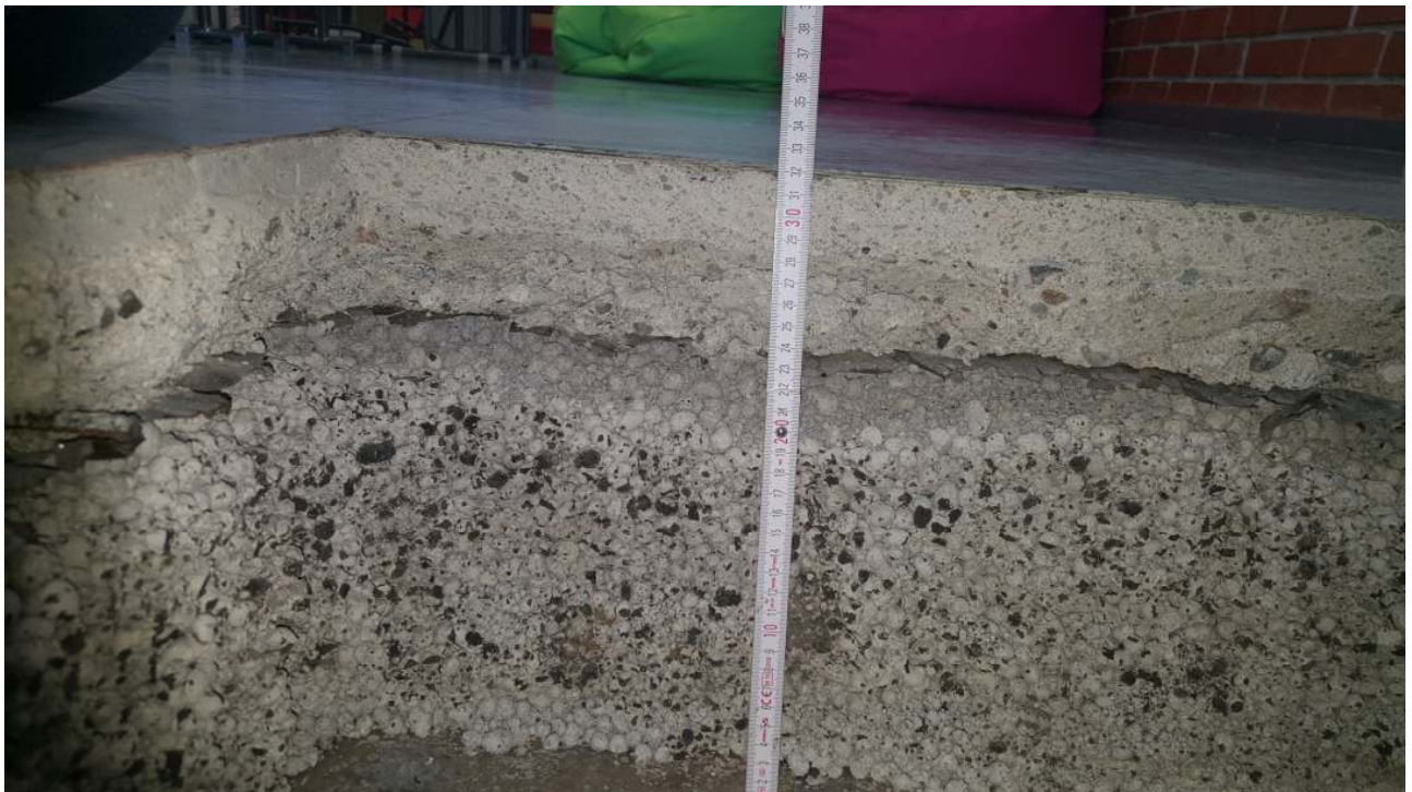
Kuva 6. Alapohjarakenteen rakenneavaus, luokka 186.
