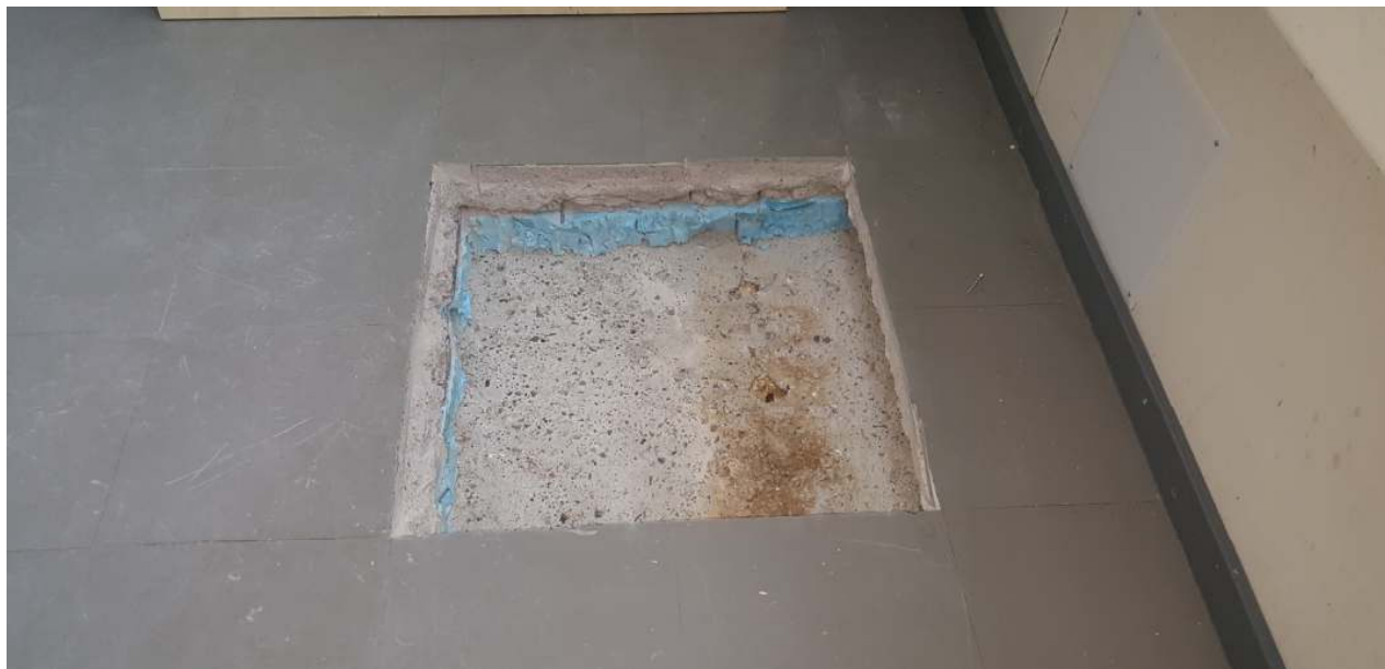
Kuva 2. Alapohjarakenteen rakenneavaus.
