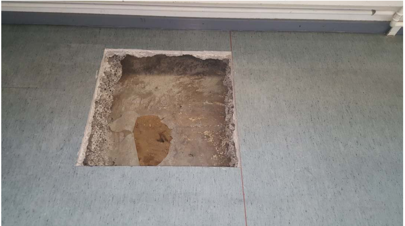
Kuva 5. Alapohjarakenteen rakenneavaus, luokka 186.
