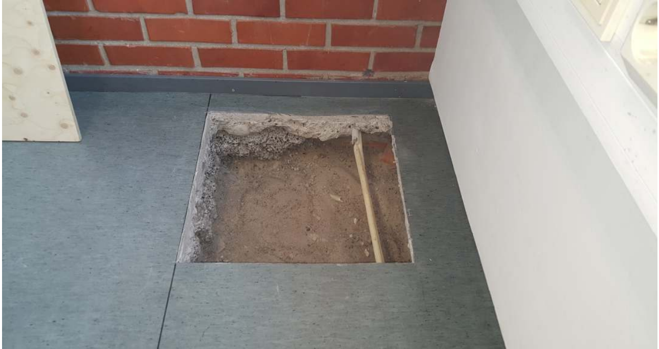
Kuva 3. Alapohjarakenteen rakenneavaus, luokka 167.
