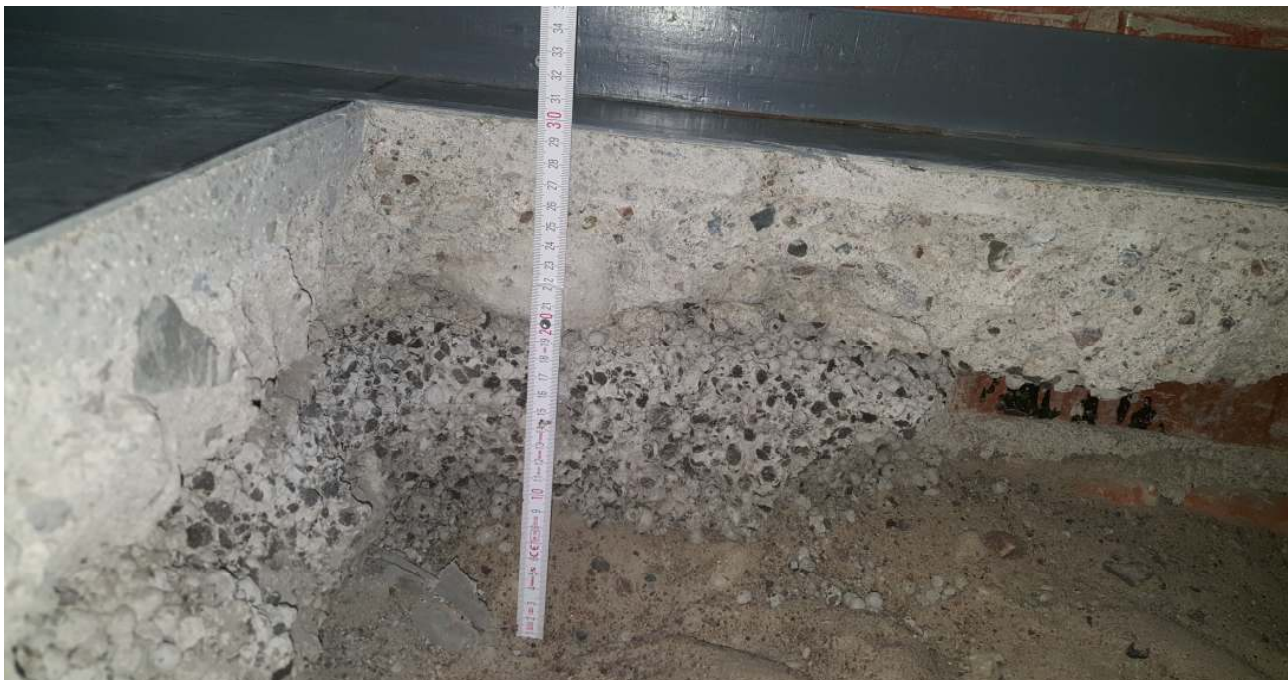
Kuva 4. Alapohjarakenteen rakenneavaus, luokka 167.
