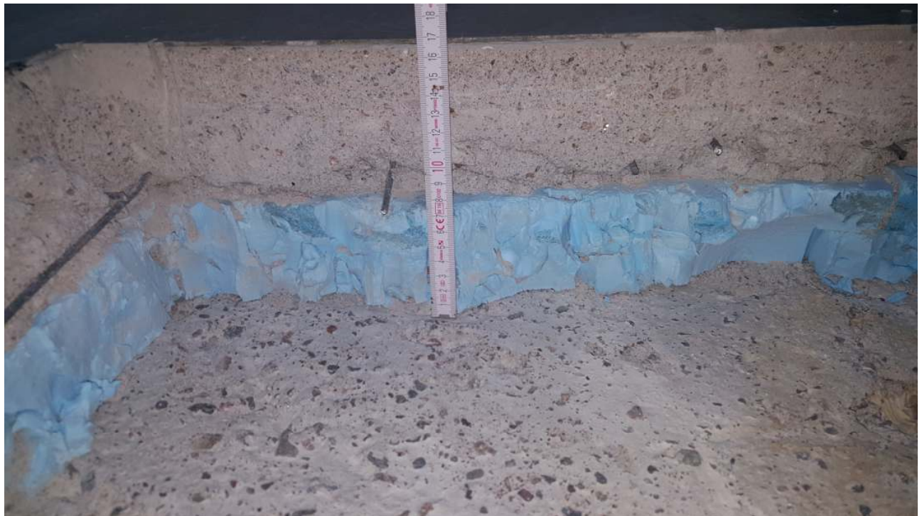
Kuva 8. Alapohjarakenteen rakenneavaus, luokka 122.
