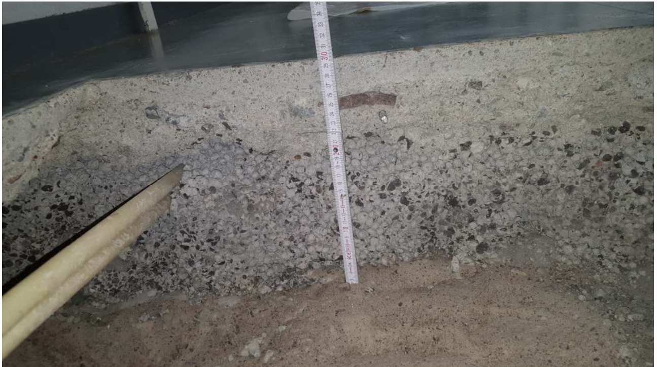
Kuva 1. Alapohjarakenteen rakenneavaus.
