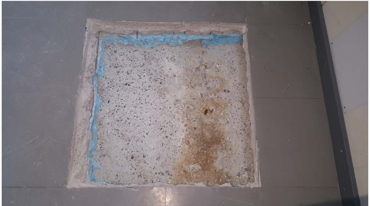
Kuva 7. Alapohjarakenteen rakenneavaus, luokka 122.
