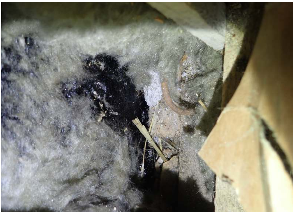
Kuva 11. Lämmöneriste on kiinni betonisokkelissa, sokkelin taustapinnassa on bitumisively.
