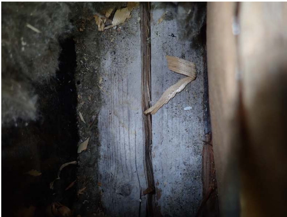
Kuva 15. Alaohjauspuun etureuna on kiinni sokkelissa.
