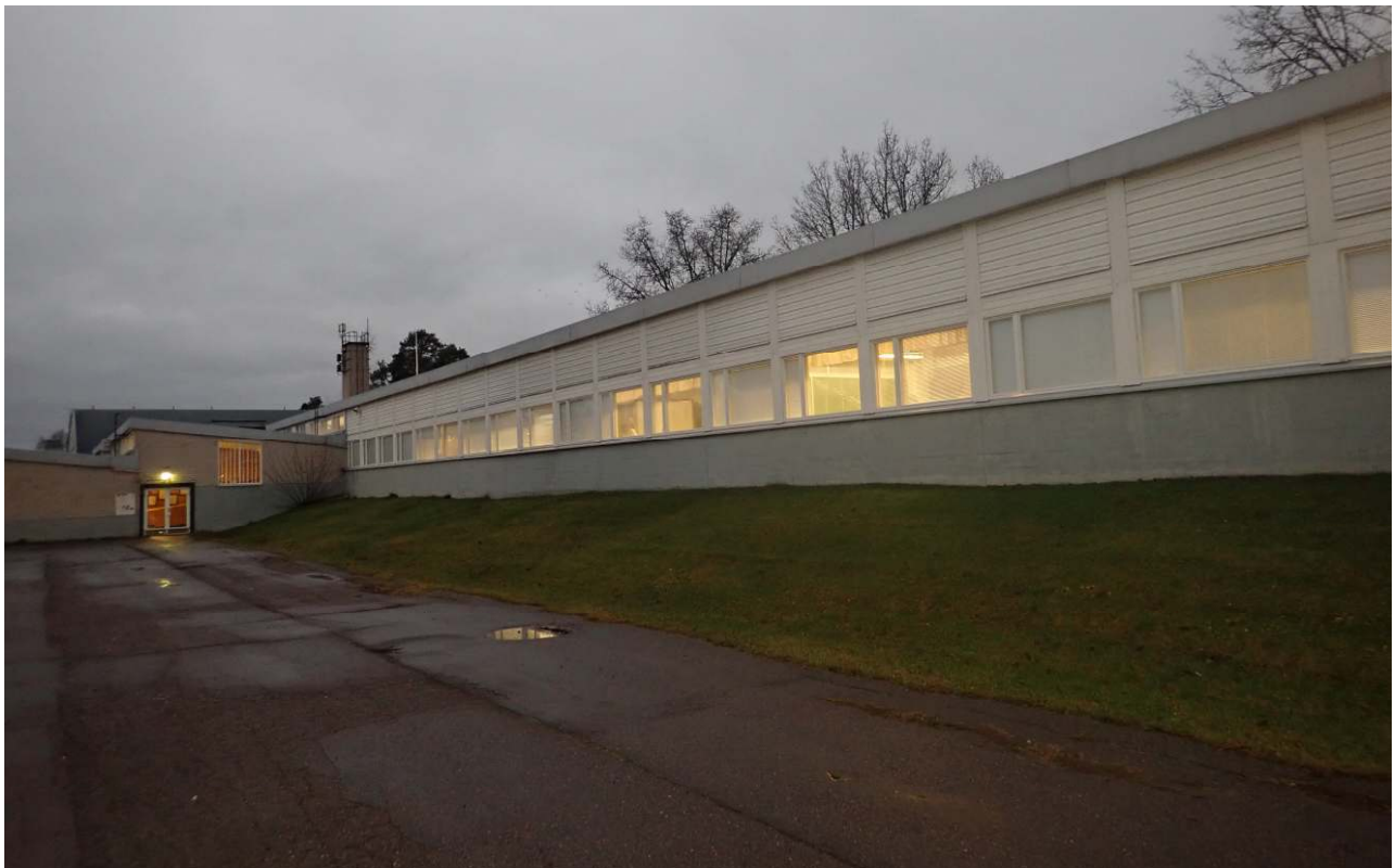
Kuva 52. Betonisokkeli ulottuu ikkunoiden alareunan tasolle.
