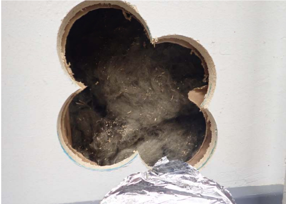
Kuva 8. Yleiskuva tutkimuspaikasta. Seinärakennetta on korjattu jollain aikaa, höyrynsulkuna on alumiinipinnoitettu paperi.
