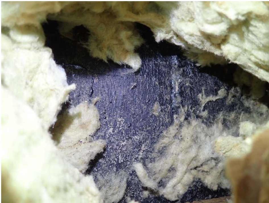
Kuva 5. Betonisokkelin taustapinnassa on bitumisively ja lämmöneristeet ovat kiinni betonisokkelissa.
