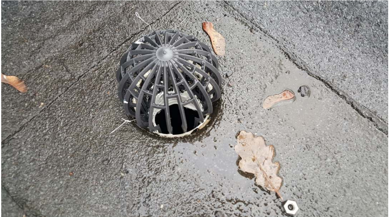
Kuva 44. Kattokaivo on uusittu jollain aikavälillä, kaivon juuri on tiivistetty tiivistysmassalla.
