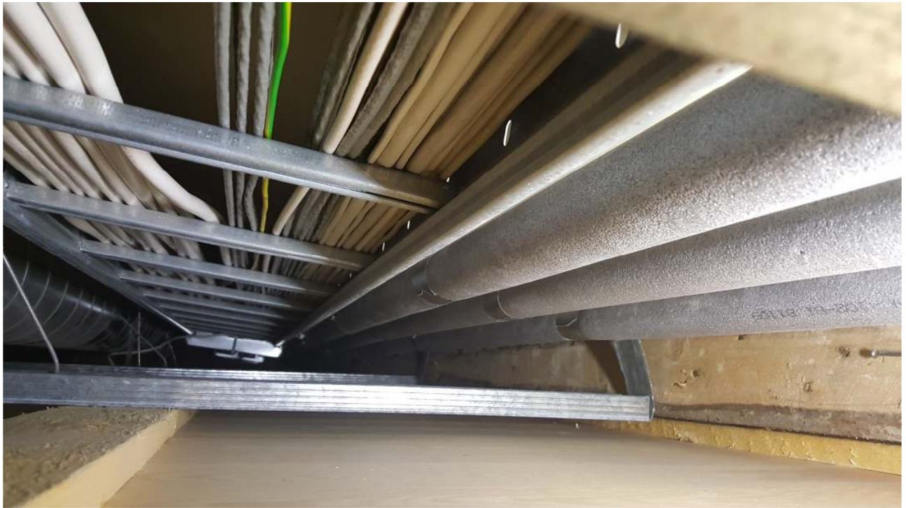
Kuva 31. Yleiskuva alaslaskutilan sisältä, tilassa ei havaittu vuotojälkiä.
