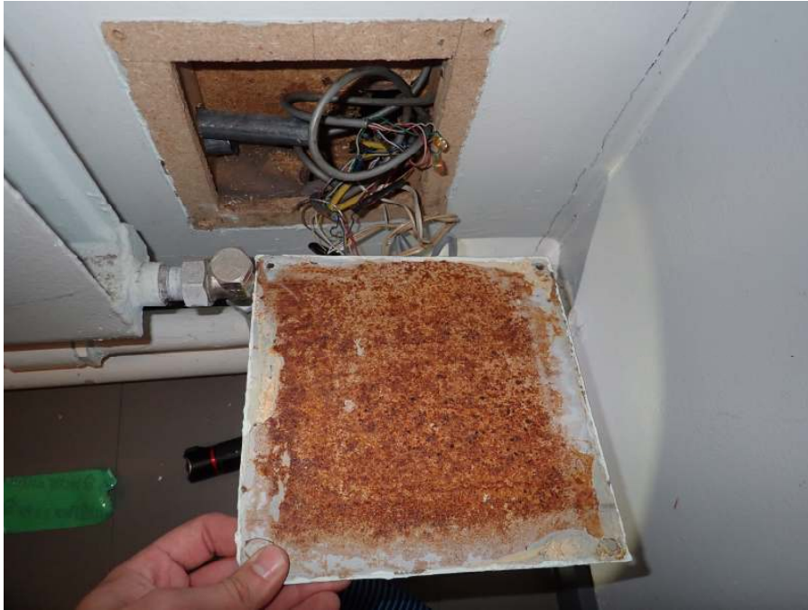
Kuva 22. Yleiskuva tutkimuspaikasta. Rakennetta tutkittiin kuvassa näkyvän peitelevyn takaa.
