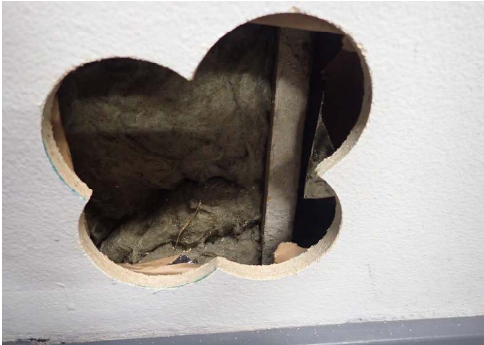
Kuva 10. Yleiskuva tutkimuspaikasta. Seinärakennetta on korjattu jollain aikaa, höyrynsulkuna on alumiinipinnoitettu paperi.
