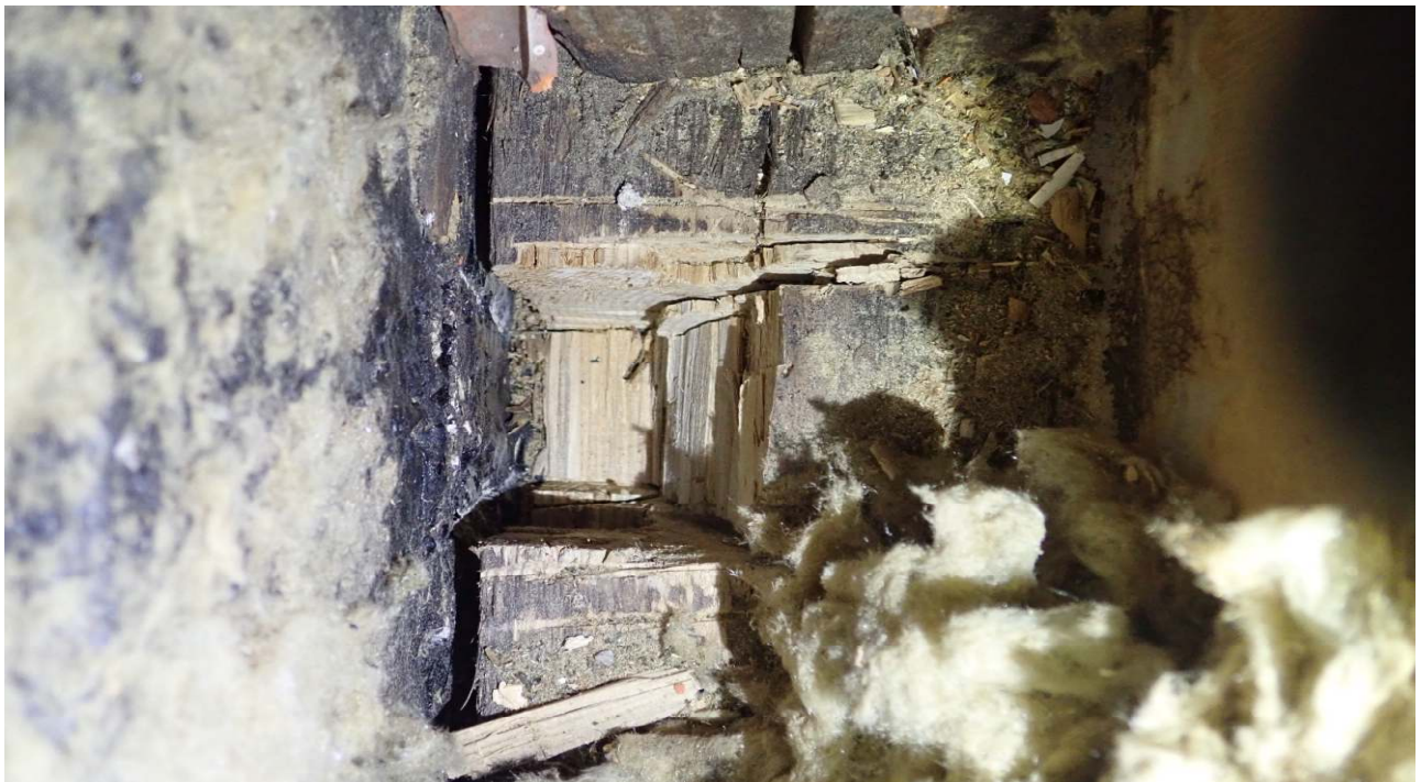
Kuva 3. Alaohjauspuun yläpinta on värjäytynyt tummaksi.
