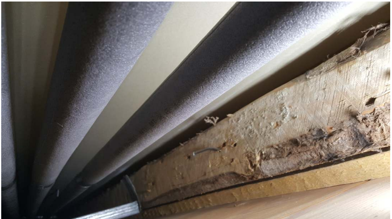
Kuva 32. Yleiskuva alaslaskutilan sisältä, tilassa ei havaittu vuotojälkiä.
