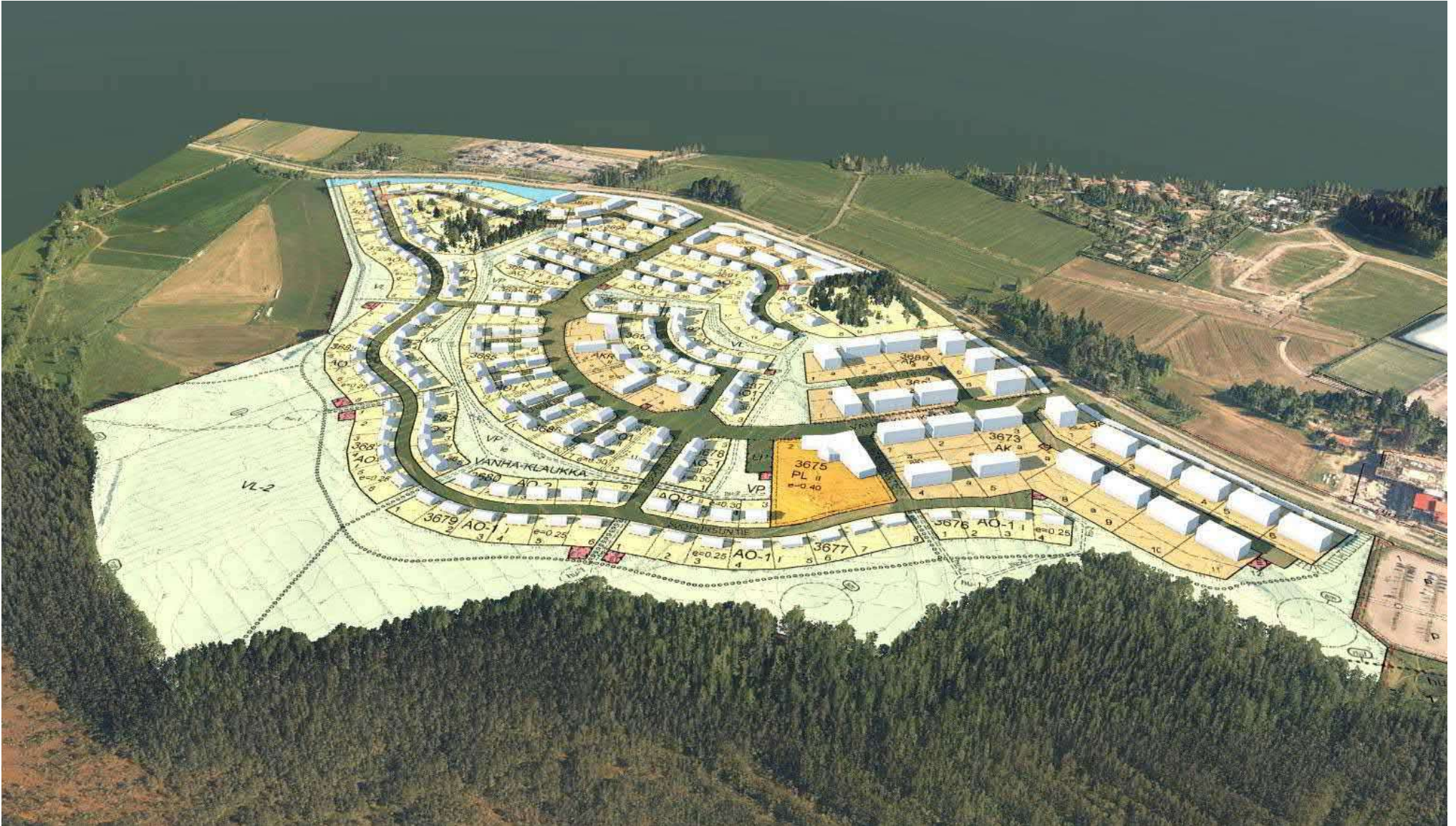
Kuva 3. Ilmakuva alueesta tehdystä 3D-mallinnuksesta.
