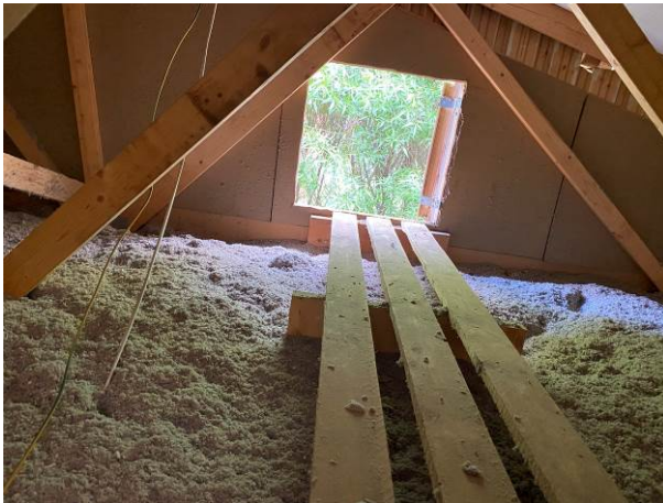
Käyntiluukku Toimisto-tilan päädystä.
