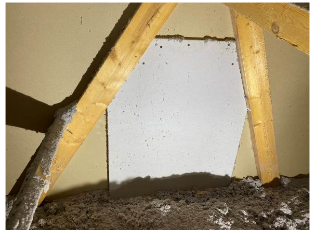
Yläpohjatila oli jaettu kolmeen erilliseen osastoon. Osastojen välillä oli kaksinkertainen kipsilevytyös kulkureittien kohdalla.
