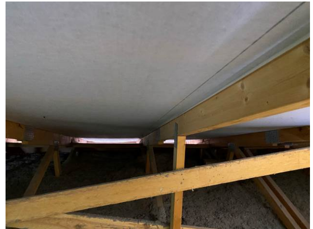
Yläpohjatilan tuulettuvuus on havaintojen mukaan riittävää.
