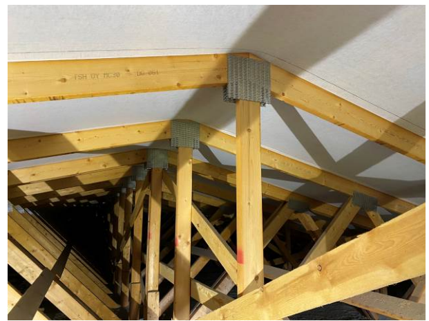
Yläpohjatilassa ei havaittu jälkiä vesikattovuodoista.
