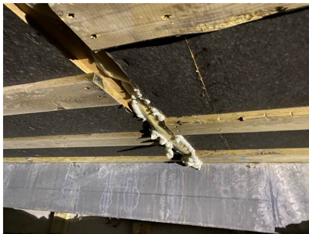
Alapohjarakennetta on tiivistetty uretaanivaahdotuksin.
