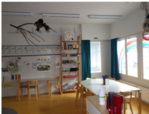
Päiväkotitiloissa ei havaittu poikkeavia hajuja tai viitteitä vaurioista.
