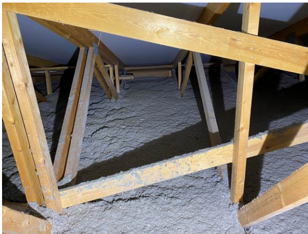
Yläpohjatilassa oli lämmöneristeenä puhallusvillaa. Villassa ei havaittu kosteusjälkiä tai muita viitteitä mahdollisista vaurioista.
