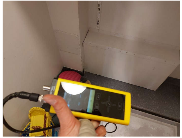
Kuva 10. Merkkiainekaasu kulkeutui sisätilaan alapohjasta koteloinnin kautta tilassa pääskyt.
