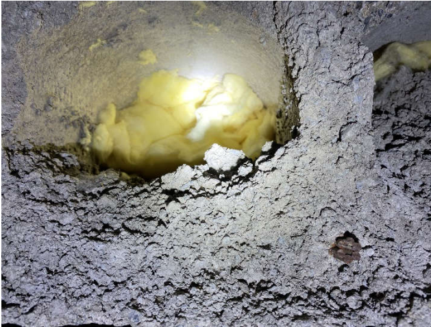
Kuva 3. Ontelolaattojen onteloita oli tukittu mineraalivillalla.
