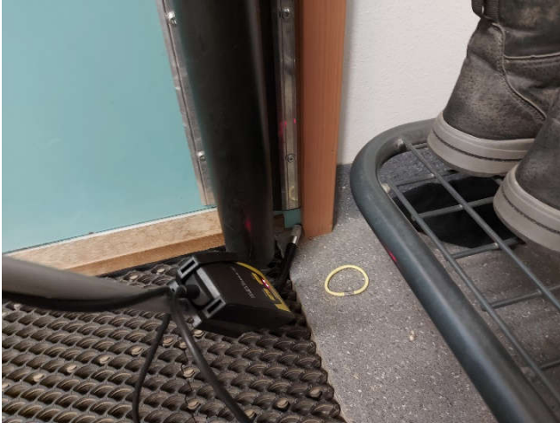
Kuva 13. Merkkiainekaasu kulkeutui sisätilaan alapohjasta eteisen kynnyksrakenteiden kautta tilassa pääskyt.
