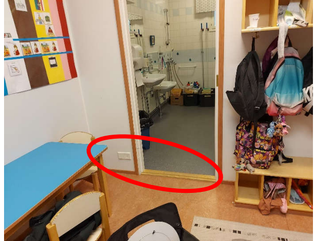
Kuva 14. Merkkiainekaasu kulkeutui sisätilaan alapohjasta mahdollisesti ontelolaatan onteloiden kautta tilassa pääskyt.
