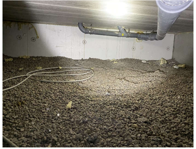
Kuva 4. Uuden puolen alapohjaa.
