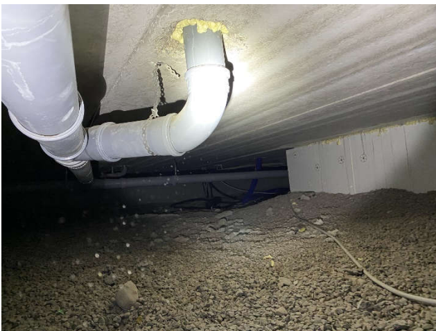
Kuva 5. Uuden puolen läpivientejä on tiivistetty uretaanivaahdolla.
