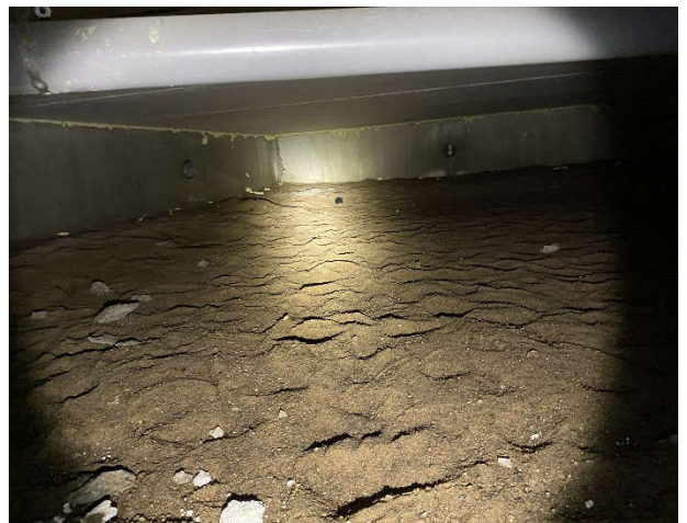
Kuva 6. Vanhan puolen alapohjaa.
