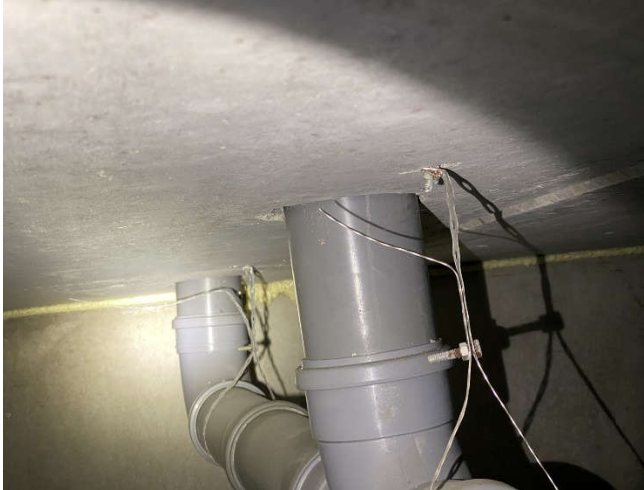
Kuva 7. Alapohjan läpivientejä, vanha puoli.
