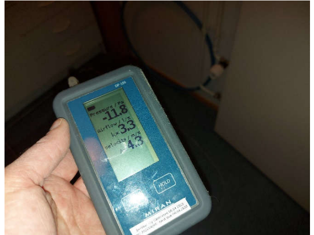
Kuva 2. Paine-ero tutkittavissa tiloissa oli n. -11...-12 Pa alapohjatilaan nähden.
