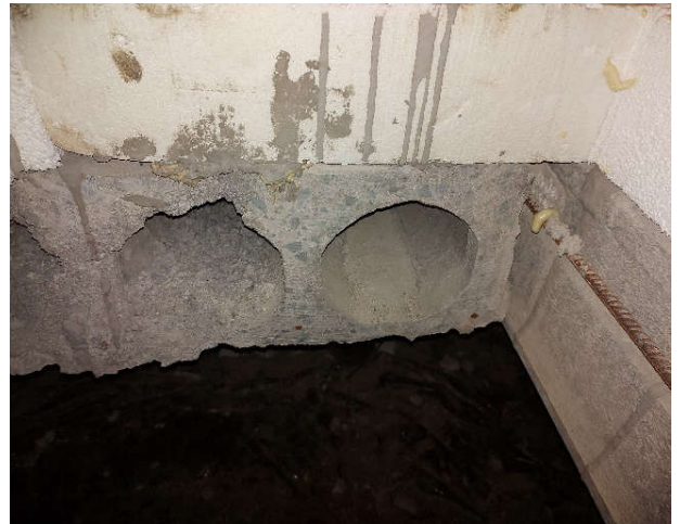
Kuva 4. Alapohjan ontelolaatan onteloita.
