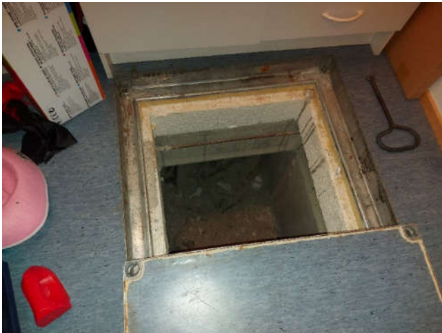
Kuva 3. Käynti alapohjaan.
