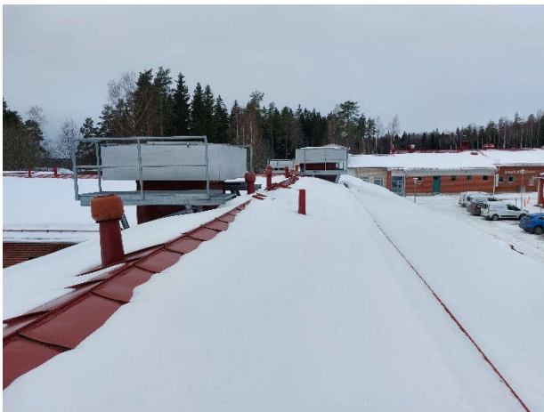
Kuva 89. Tarkastushetkellä vesikatolla oli lumipeite.
