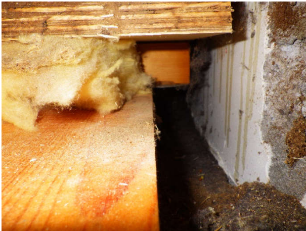
Kuva 25. AP20. Lattian alle kertynyttä likaa.
