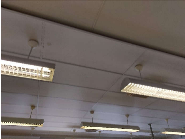
Kuva 67. Koulun luokkatilojen akustiikkalevyverhoilua.
