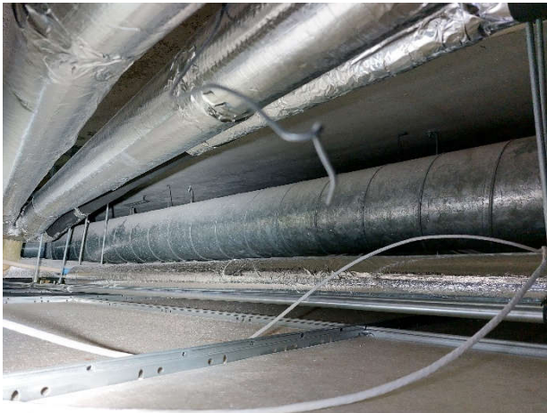
Kuva 61. Yleiskuvaa päiväkodin alakaton sisältä.
