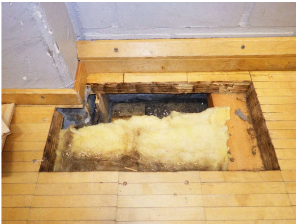
Kuva 23. AP20. Liikuntasalin lattiaan tehty tarkastusluukku.
