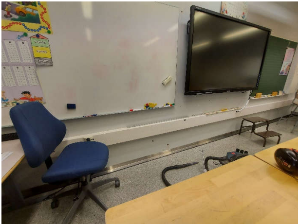
Kuva 44. Ra VS2 tehtiin laajennusosan tilaan 109.
