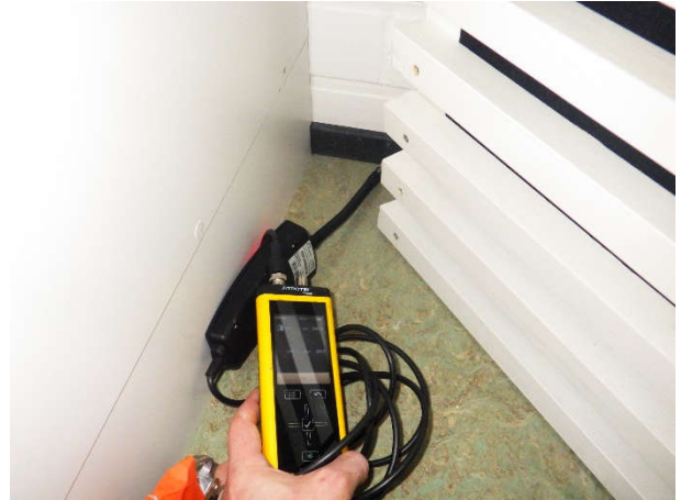
Kuva 22. Ilmavuotojen tarkastelua huonetilan puolelta.
