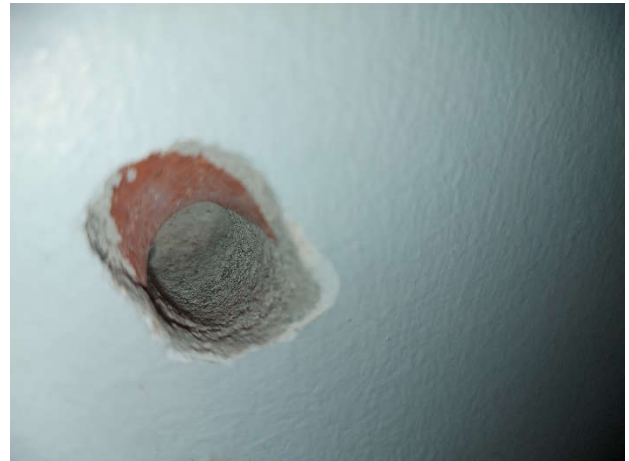
Kuva 45. Rakenteessa havaittiin tiiltä ja betonia.
