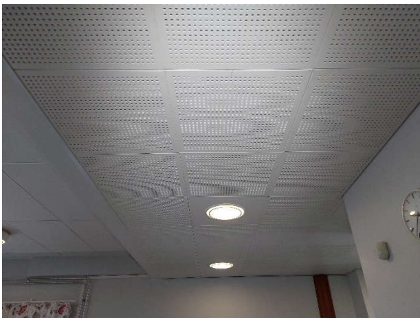
Kuva 65. Koulun ruokailutila alakattolevyt ovat rei'itettyjä kipsilevyjä.
