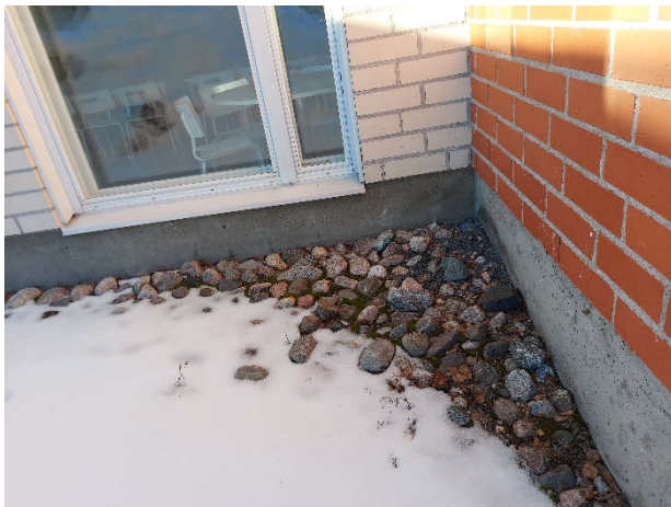
Kuva 40. RA US 9 avaus tehtiin ruokasaliin 103, koulun laajennusosaan.
