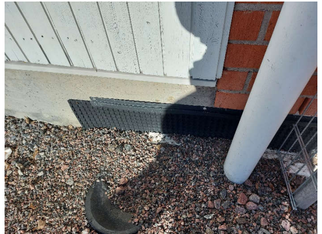
Kuva 35. Rakenneavauksen US12 kohdalla havaittiin patolevy pienellä alueella osittain maanvastaista ulkoseinärakennetta.
