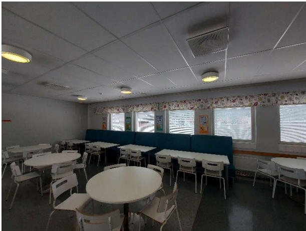
Kuva 34. Rakenneavaus US12 tehtiin ruokasalin sisäpihan puoleisen osittain maanvastaisen ulkoseinän alaosaan.
