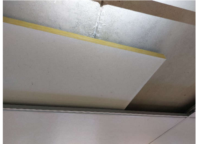
Kuva 68. Levyjen reunat ovat pinnoittamattomia.
