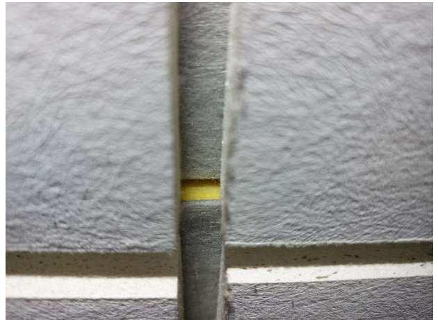
Kuva 58. Päiväkodin tiloissa uuden verhoilun alla on vanhaa, reunoiltaan pinnoittamatonta akustiikkalevyä.
