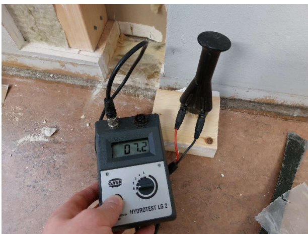
Kuva 49. Rakenneavauksen puurakenteet olivat kuivia.
