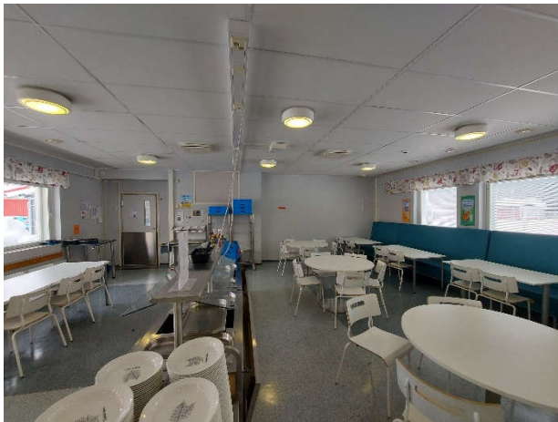
Kuva 43. Vanhaa ulkoseinää eli nykyistä väliseinää tutkittiin ruokasalin puolelle tehdyn rakenneavauksen kautta.
