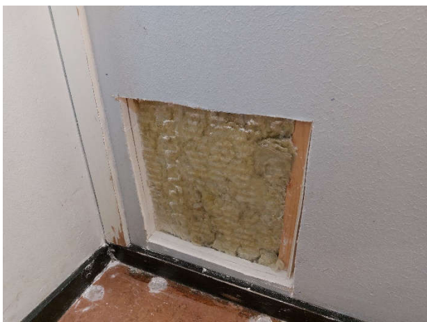
Kuva 51. Väliseinäavaus tehtiin kantavan pilarin viereen.
