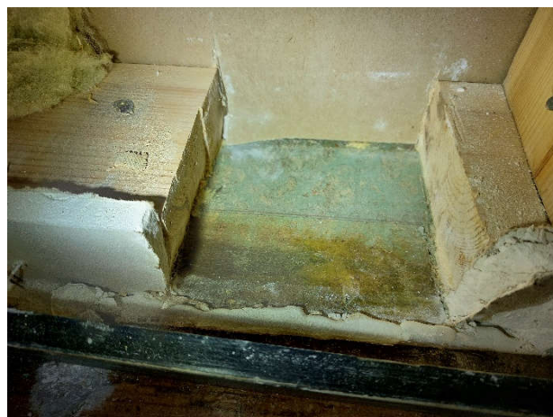
Kuva 52. Lattiapäällyste on yhtenäinen kipsilevyseinien alla.
