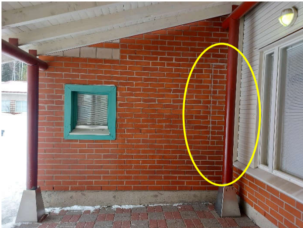
Kuva 48. Seinän tiilimurausta on korjattu jollain aikavälillä vanhalla ulkoseinälinjalla.
