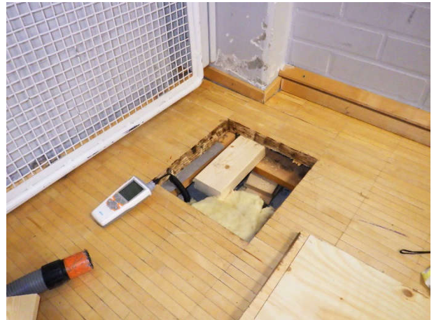
Kuva 26. AP21. Liikuntasalin lattiaan tehty tarkastusluukku.
