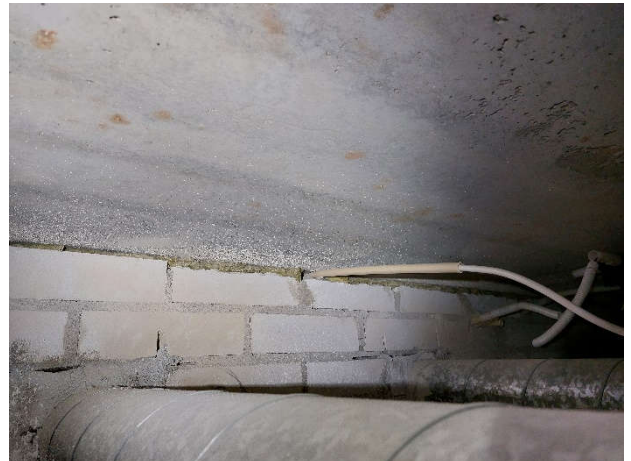
Kuva 62. Väliseinien yläosassa on villakaista.
