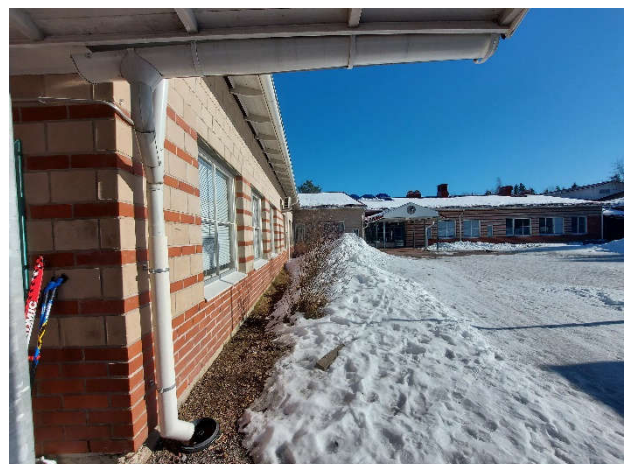
Kuva 9. Yleiskuvaa rakennuksen vierustalta.
