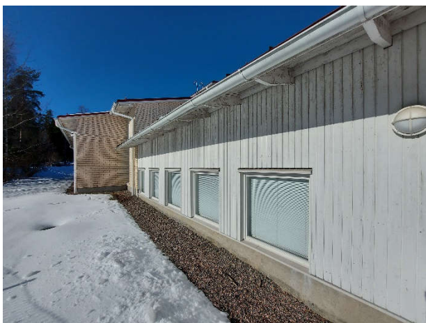
Kuva 8. Yleiskuvaa rakennuksen vierustalta.
