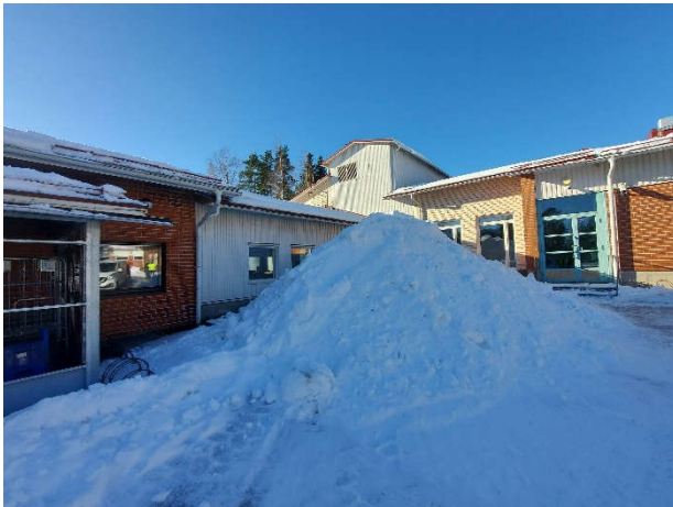
Kuva 30. Etupihan puoleista osittaista maanvastaista ulkoseinää. Lumet on kasattu lähelle ulkoseinää.
