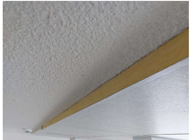
Kuva 64. Verhoilun reunat ovat pinnoittamattomia, mutta suojattu peltistalla.
