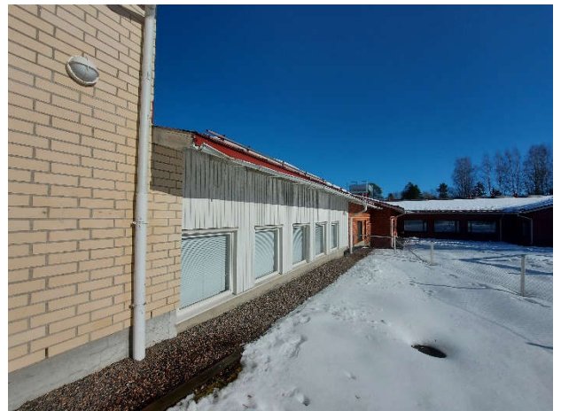
Kuva 33. Osittain maanvastaista ulkoseinää sisäpihan puolelta.
