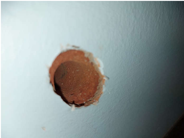
Kuva 46. Rakenteessa havaittiin tiiltä ja betonia.
