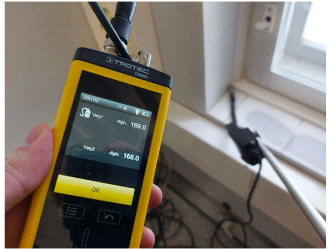
Kuva 91. Ilmavuotoa ikkuna-ulkoseinäliittymän kautta.
