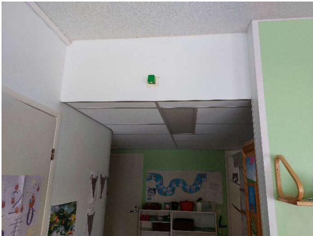
Kuva 59. Päiväkodin alaslaskettua kattorakennetta.
