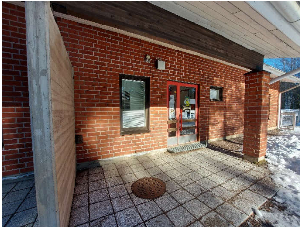
Kuva 10. Yleiskuvaa rakennuksen sisäänkäynniltä.
