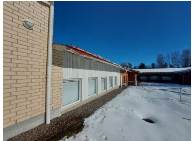
Kuva 31. Takapihan puoleista osittaista maanvastaista ulkoseinää.
