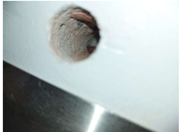
Kuva 47. Rakenteessa havaittiin tiiltä ja betonia.
