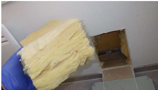
Kuva 36. Rakenneavaus US2. Rakenteessa havaittiin jonkin verran purua.
