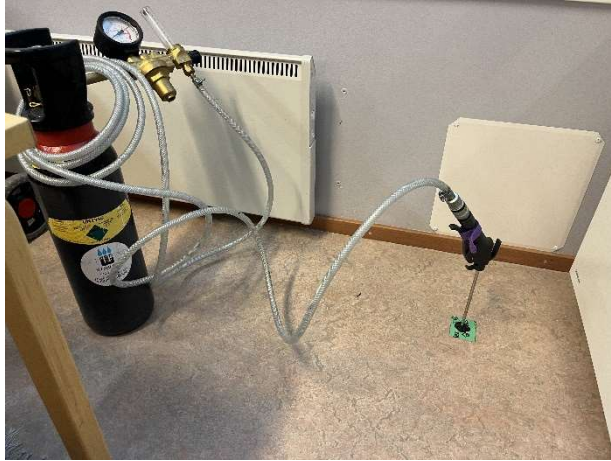
Kuva 82. Merkkiaineen syöttöä alapohjarakenteen eristetilaan.
