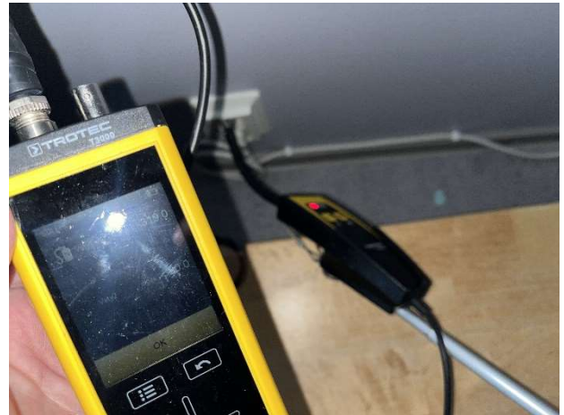
Kuva 85. Merkkiainekaasun havaittiin kulkeutuvan sisäilmaan sähköpistorasioiden kautta.
