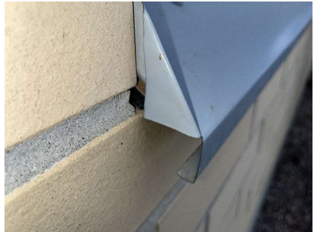
Kuva 31. Ulkoseinä-ikkunaliittymää, laajennusosa.
