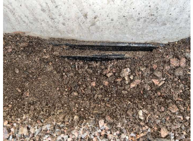
Kuva 14. Patolevyä, alkuperäisosa.
