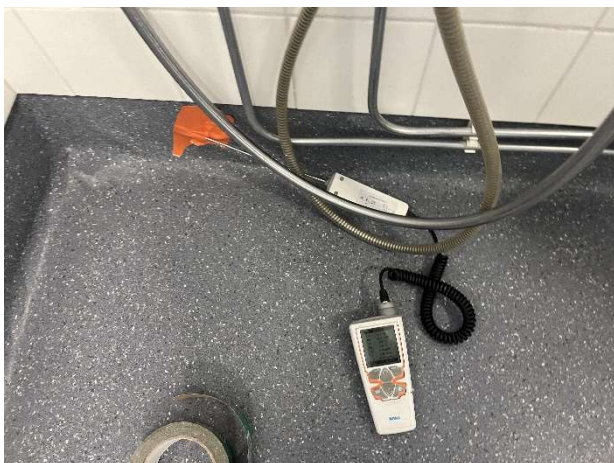
Kuva 19. Viiltomittausta Ahmojen wc-tiloissa, laajennusosa.
