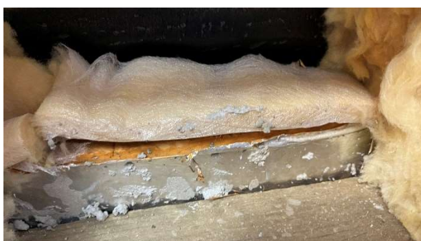
Kuva 51. Uretaanin yläpinnan ja kovavillan alapuolisen villakaistan rakenne.
