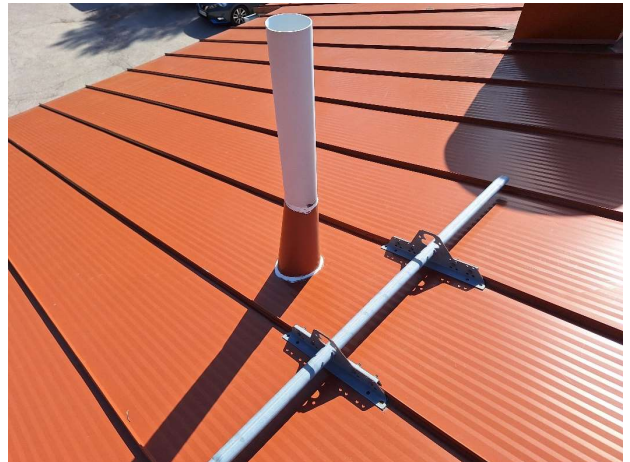
Kuva 67. Alkuperäisosa. Viemärin tuuletusputki.
