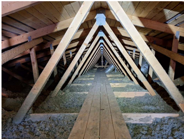
Kuva 74. Yleiskuvaa laajennusosan yläpohjasta.
