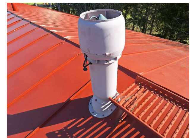
Kuva 69. Laajennusosa. Huippumuri.
