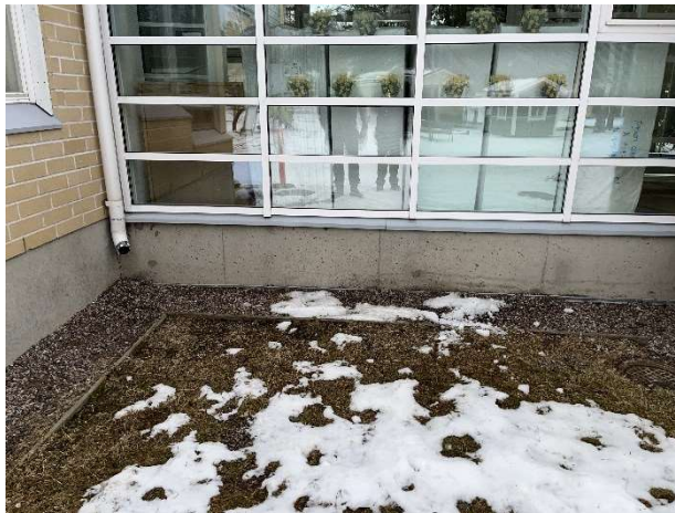
Kuva 15. Rakennuksen vierustaa, yhdyskäytävä.
