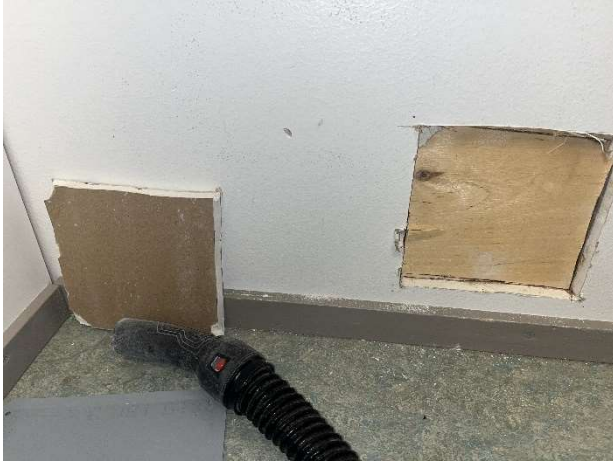
Kuva 54. VS3. Rakenneavausta WC-tilojen vastaiseen väliseinään.
