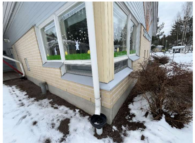
Kuva 12. Ulkoseinän vierustaa, alkuperäisosa.
