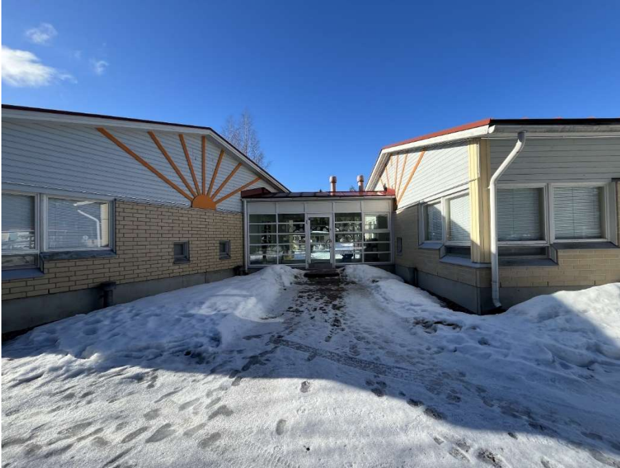
Kuva 1. Alkuperäisosan ja laajennusosan välinen yhdyskäytävä.
