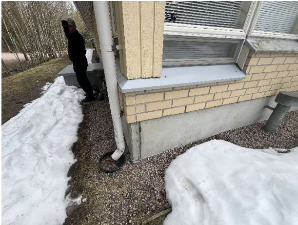
Kuva 9. Laajennusosan ulkoseinien vierustojen sepelöintiä ja sadevesien ohjausta.
