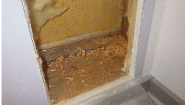
Kuva 36. Rakenneavaus US2. Rakenteessa havaittiin jonkin verran purua.
