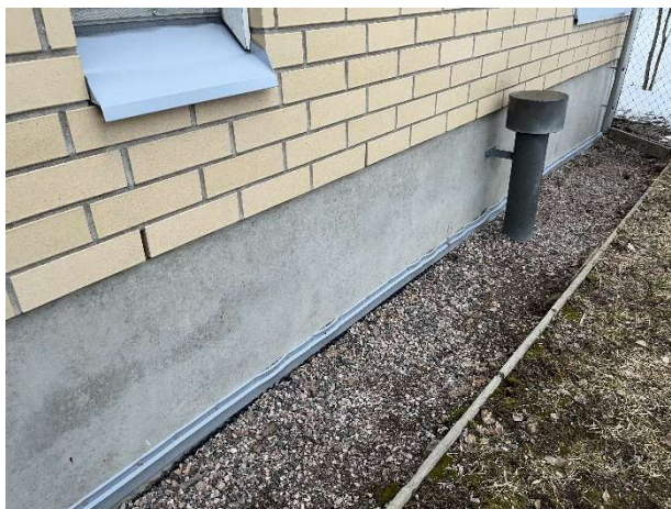
Kuva 17. Rakennuksen vierustaa, laajennusosa.
