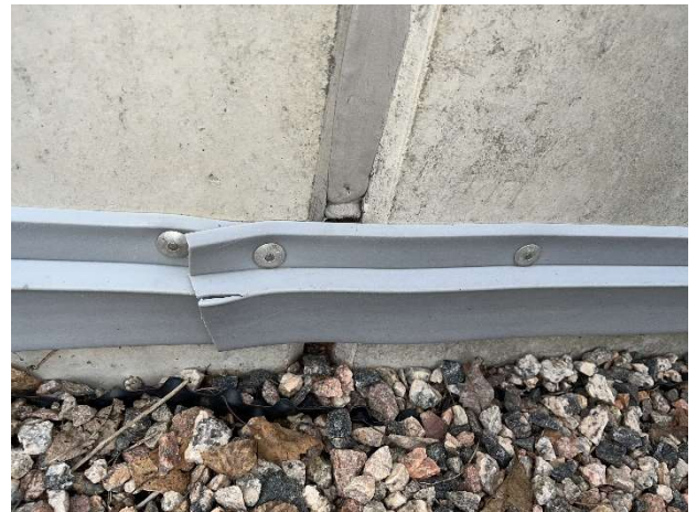
Kuva 16. Patolevy on irronnut reunalistasta.
