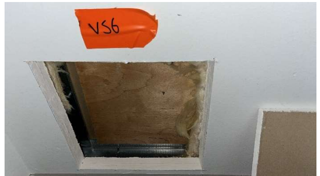
Kuva 57. VS4. Rakenneavausta. Väliseinät ovat peltirankaisia. Peltirangan reunassa havaittiin ruostejätkiä.
