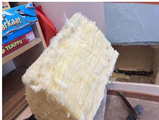
Kuva 50. Rakenneavaus US17. Lämmöneristeissä ei havaittu tummentumaa.
