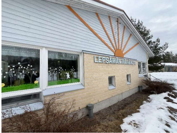
Kuva 13. Ulkoseinän vierustaa, alkuperäisosa.
