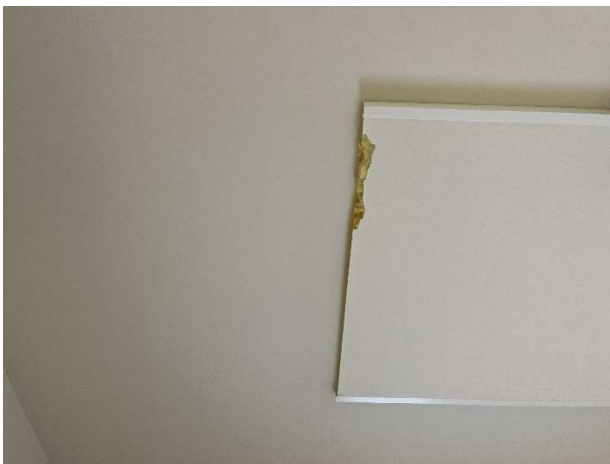
Kuva 96. Rikkinäinen akustiikkalevy.
