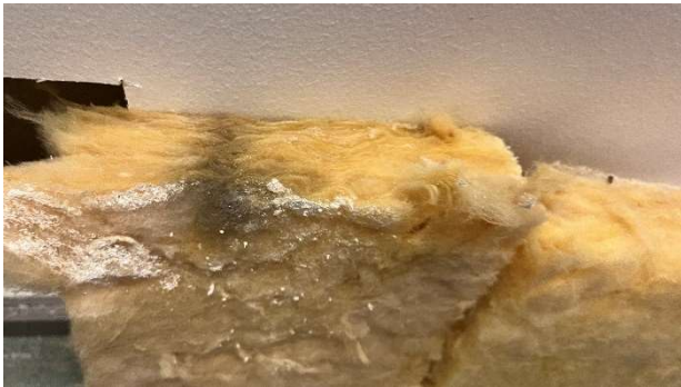
Kuva 56. VS4. Rakenneavausta. Villassa havaittiin lievää tummumaa.
