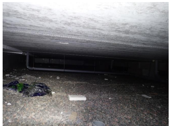
Kuva 33 Yleiskuvaa alapohjan ryömintätilasta, johon merkkiainekaasua laskettiin.
