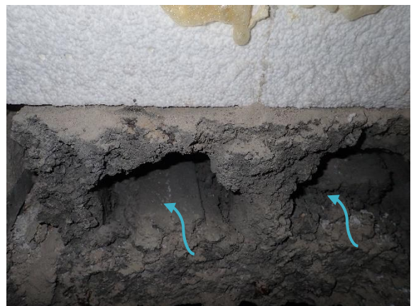
Kuva 27 Käyntiluukun kohdalla kylmän ilman suoraa virtausta ontelotilaan ei ole estetty.
