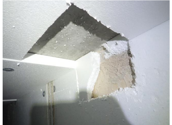
Kuva 23 Sokkelin ja ontelolaattojen liittymää tarkasteltiin poistamalla ontelolaatan alapintaan kiinnitettyä lisäeristystä.
