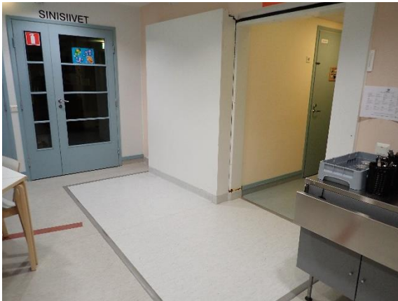
Kuva 12 Väestönsuojan edessä levyrakenteinen lattia.
