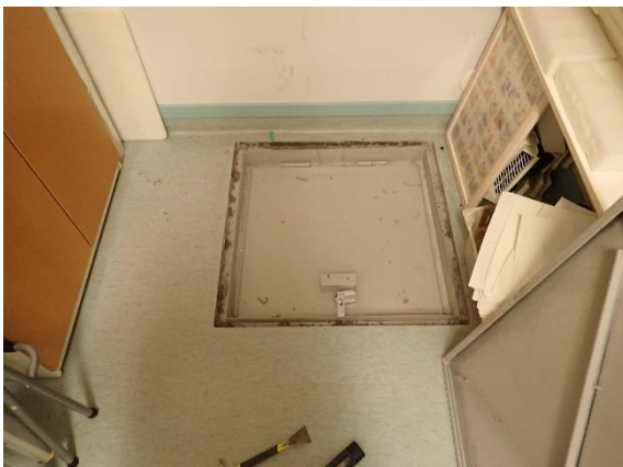
Kuva 10 Sisempi luukku, jossa saranat ja lukkotelki. Ei kiristysmekanismia. Raollaan lukon puolelta.
