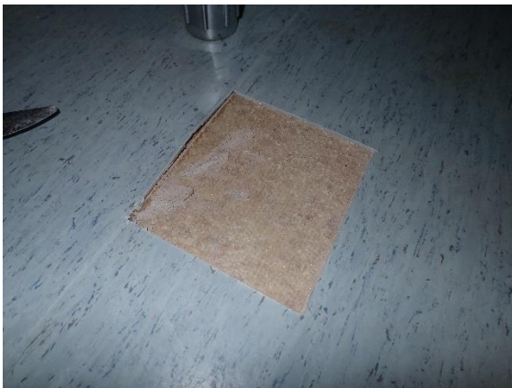
Kuva 28 Näytepala tilassa 040 vaatehuolto. Avauskohdassa ei poikkeavia havaintoja.
