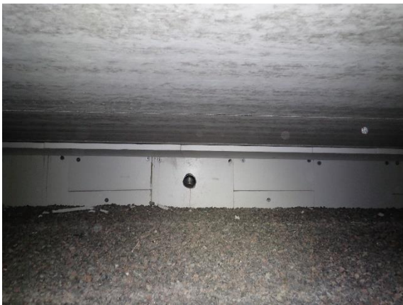
Kuva 24 Reunavyöhykkeen eristystä. Keskellä nähtävissä ryömintätilan tuuletuksen korvausilmaputki.
