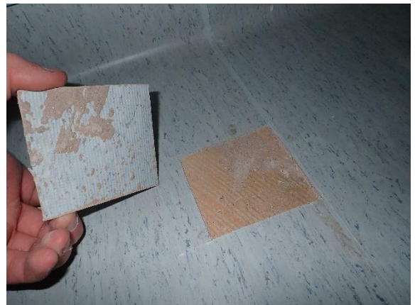
Kuva 29 Näytepala tilassa 033 varasto. Avauskohdassa ei poikkeavia havaintoja.
