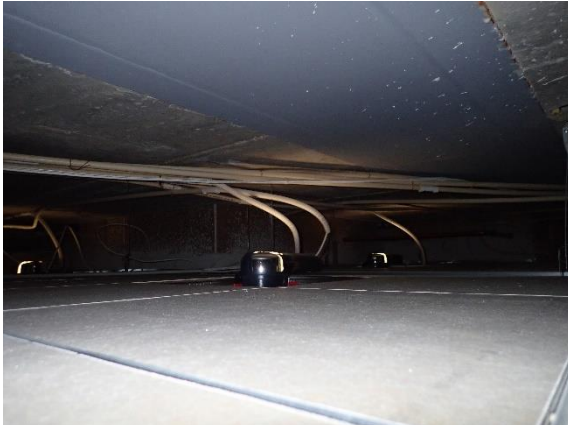
Kuva 50 Alakattojen yläpuolinen tila oli sattumanvaraisessa tarkastelussa siisti.
