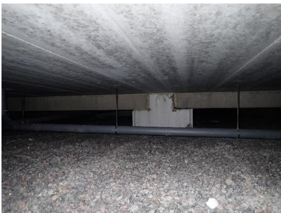
Kuva 14 Ryömintätila on pääsääntöisesti siisti ja hyvin toteutettu. Pohjamateriaalina on hyvin kosteutta läpäisevä karkea sepelikerros. Viitteitä kosteuden kertymisestä ryömintätilaan ei havaittu.
