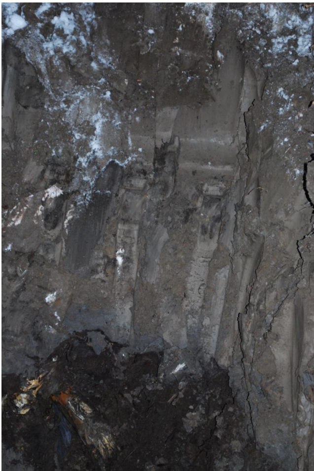
Kuva 25. KK9. Koekuppa kaivettu 2 m syvyydelle.
