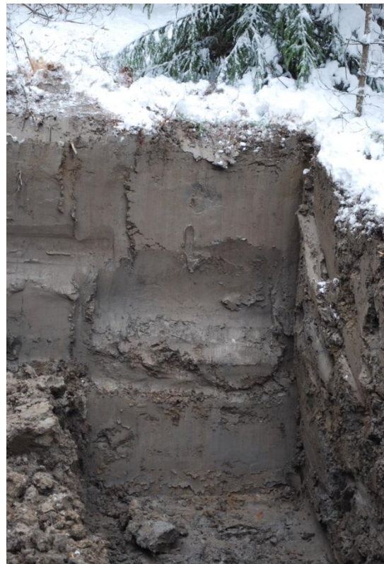
Kuva 10. KK3. Koekuoppa kaivettu 3,0 metrin syvyydelle.
