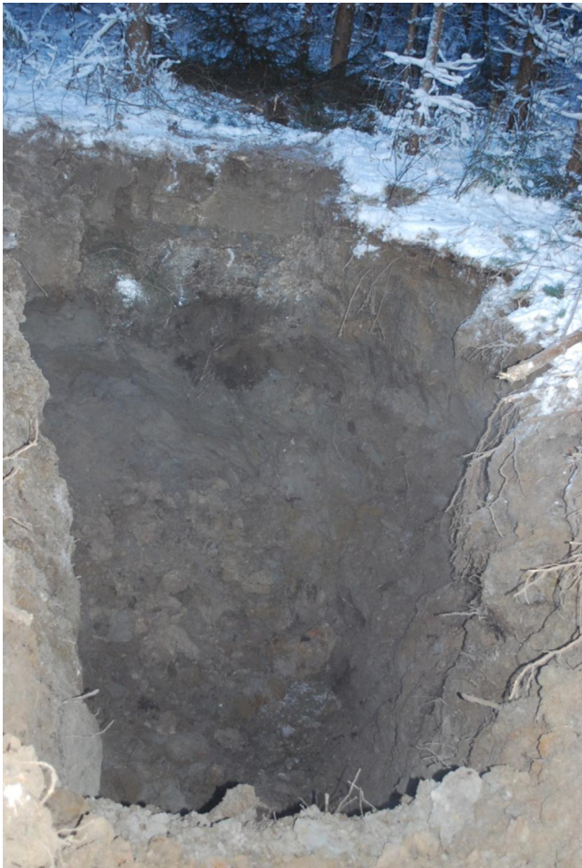
Kuva 21. KK6. Koekuoppa kaivettu 5,2 m syvyydelle.
