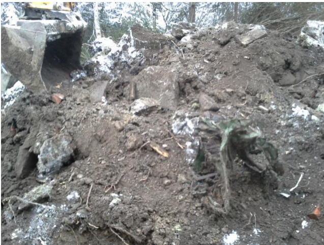
Kuva 3. KK1. Metalliriromua, tiiltä ja puuta täyttömaan seassa.
