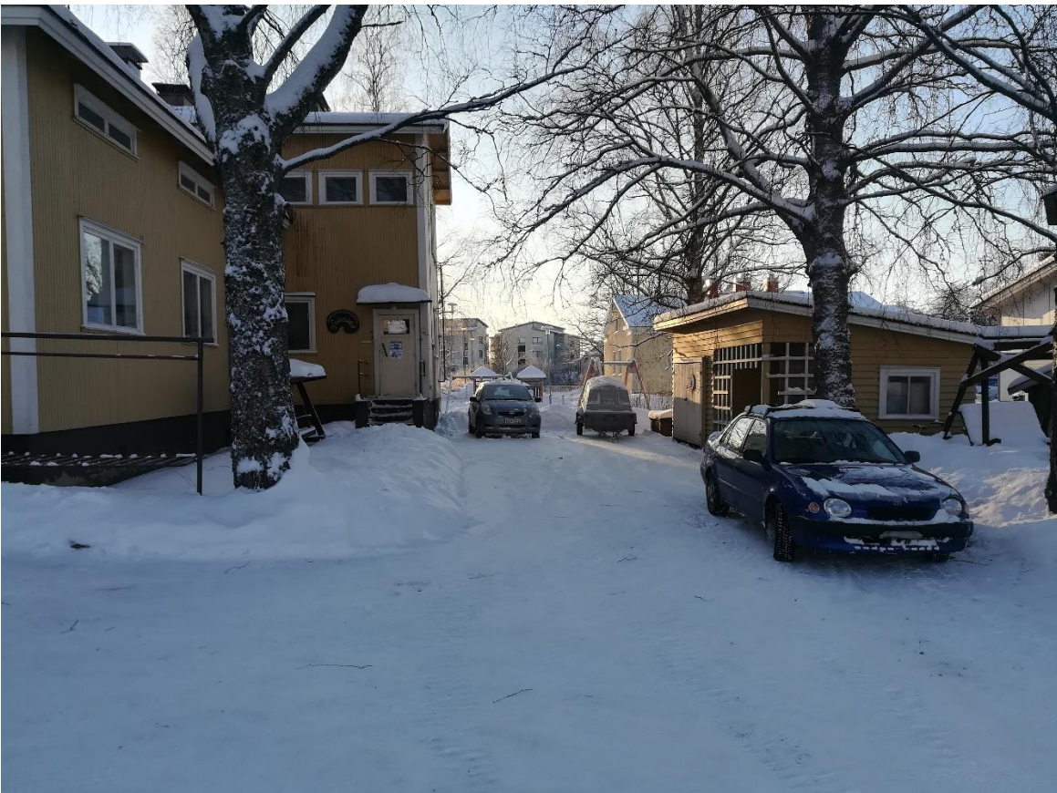
Kuva 6. Tutkimuspiste SW 5 koillisesta lounaaseen kuvattuna. Tutkimuspisteen sijainti on etuoikealla olevan auton alapuolella. Rakennuksessa toimii kirpputori.
