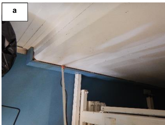
Kuvat 16a ja b. Salin molempien sisäänkäyntien vieressä havaittiin voimakasta ilmavuotoa liikuntasalin tuulettavan jalkalistan kohdalta.
