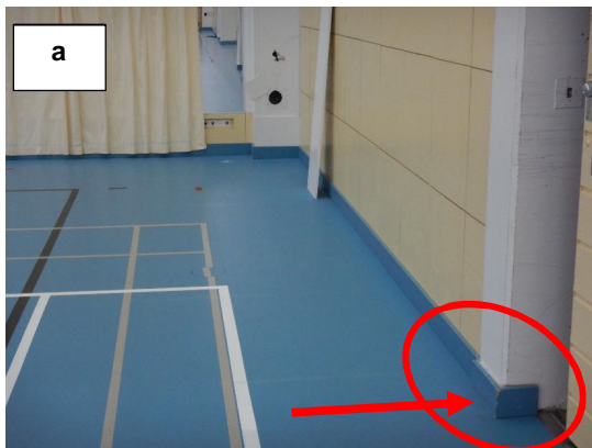
Kuvat 15a ja b. Itäseinällä, ensimmäisen pilarin juuresta, havaittiin voimakasta ilmavuotoa (kuva a). Voimakasta ilmavuotoa havaittiin myös oviaukon oikeasta reunasta, väliseinän juuresta (kuva b).
