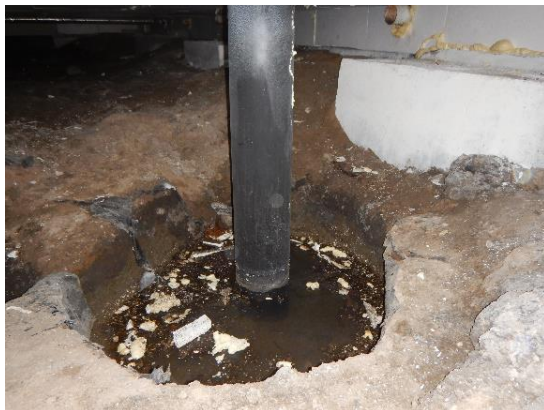
Kuva 2a ja b. Liikuntasalin alapuoleisessa ryömintätalassa pohjavesi oli varsin lähellä ja maa oli paikoin kostea eri puolilla alapohjatilaa. EPS-eristeet oli asennettu tiiviisti paikoilleen. Levyjen saumoja oli tiivistetty polyuretaanivaahdolla.
