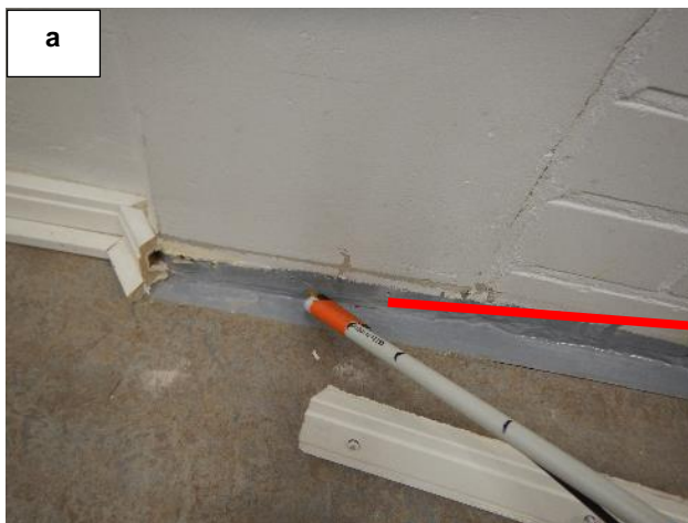
Kuvat 10a ja b. TKR-pinnoitteella tehdyssä tiivistyksessä oli lohkeamia, joista havaittiin ilma- vuotoa. Lisäksi tiivistyksessä oli pistemäisiä vuotokohtia sekä vuotokohta jalkalistan kiinnitys- kohdissa. Kuvat luokasta 11.
