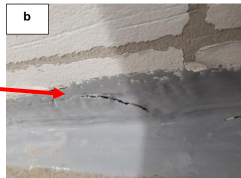
Kuvat 10a ja b. TKR-pinnoitteella tehdyssä tiivistyksessä oli lohkeamia, joista havaittiin ilma- vuotoa. Lisäksi tiivistyksessä oli pistemäisiä vuotokohtia sekä vuotokohta jalkalistan kiinnitys- kohdissa. Kuvat luokasta 11.
