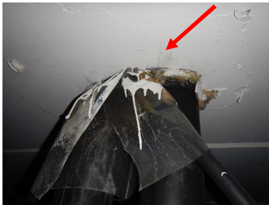
Kuva 3 a ja b. Liikuntasalin alapohjan läpivientien ilmatiiveydessä oli selviä puutteita.
