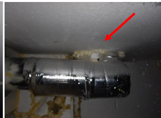
Kuva 3 a ja b. Liikuntasalin alapohjan läpivientien ilmatiiveydessä oli selviä puutteita.
