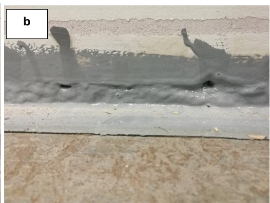
Kuvat 11a ja b. TKR-tiivistys on tehty pintarakenteiden päälle ja tiivistyksissä on jalkalistan mekaanisten kiinnikkeiden aiheuttamia reikiä (ilmavuotokohtia).
