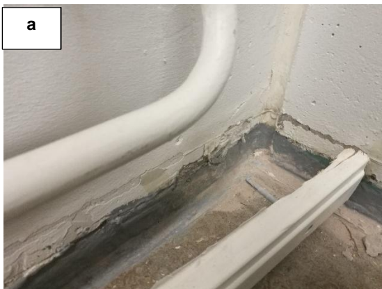
Kuvat 11a ja b. TKR-tiivistys on tehty pintarakenteiden päälle ja tiivistyksissä on jalkalistan mekaanisten kiinnikkeiden aiheuttamia reikiä (ilmavuotokohtia).
