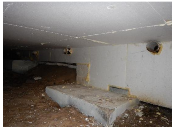
Kuva 2a ja b. Liikuntasalin alapuoleisessa ryömintätalassa pohjavesi oli varsin lähellä ja maa oli paikoin kostea eri puolilla alapohjatilaa. EPS-eristeet oli asennettu tiiviisti paikoilleen. Levyjen saumoja oli tiivistetty polyuretaanivaahdolla.
