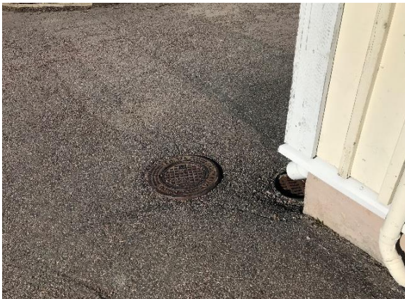
Kuva 9 Rakennuksen eteläpäädyssä havaittiin salaojien tarkastuskaivot.
