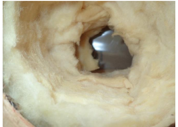
Kuva 46 Puurunkoisen ulkoseinän mineraalivillaaeristeet vaikuttivat aistinvaraisesti hyväkuntoisilta. Jälkimmäisenä rakenteessa höyrynsulkumuovi.
