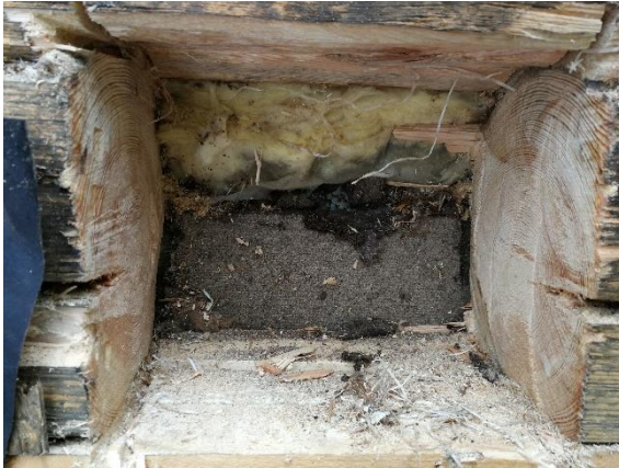
Kuva 25 Kevytbetonivalun ja ulkoseinän liitosta tutkittiin tekemällä rakenneavaus hirsiseinään.
