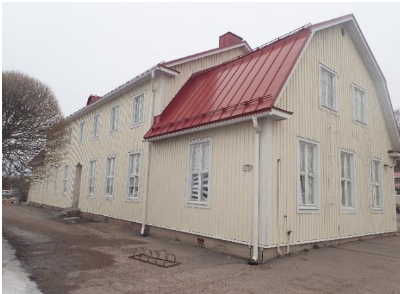
Kuva 3 Maanpinnan kallistukset rakennuksen vierustalla ovat pääosin tasaiset tai loivasti pois päin rakennuksesta. Piha-alueet ovat pääosin asfaltoituja.
