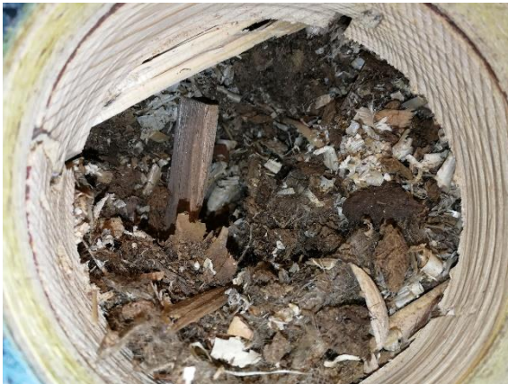
Kuva 20 Alapohjan rakenneavaus tilassa 112 (AP5).
