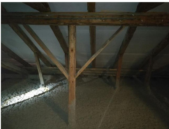
Kuva 61 Yleiskuvaa yläpohjasta. Puuosat ovat kirkkaat ja hyväkuntoiset.
