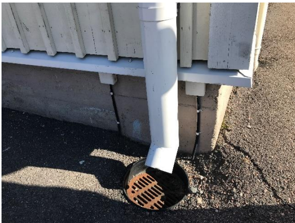
Kuva 5 Kattovedet on ohjattu sadevesijärjestelmään.
