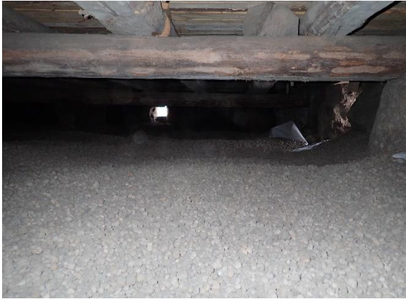
Kuva 12 Yleiskuvaa ryömintätilasta rakennuksen pohjois- päädyssä. Ryömintätila on siistikuntoinen.
