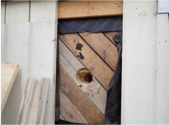
Kuva 43 Eteläpäädyn puurunkoisen laajennusosan ulkoseinien kuntoa ja rakennetta tutkittiin rakeneavauksin ulkopuolelta.
