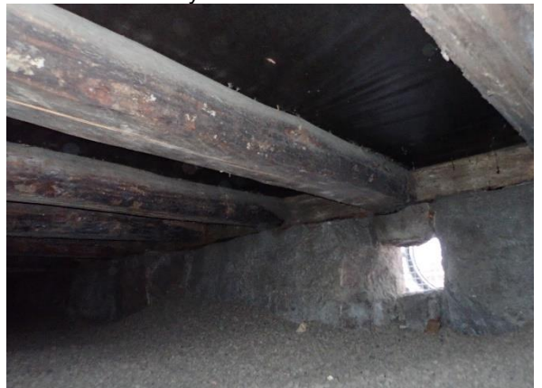
Kuva 17 Alapohjaan on asennettu tervapaperi rakennuk- sen luoteisnurkalla, pienellä alueella.
