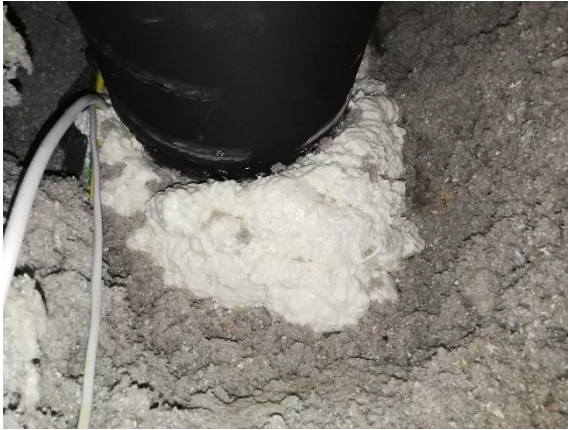
Kuva 63 Ryömintätilan ilmanvaihtokanavan yläpohjan läpivienni tiivistetty uretaanivaahdolla.
