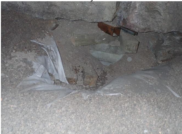
Kuva 16 Luonnonkivisokkelin kiviä on kiilattu puutavaralla ja rautaputkillla.
