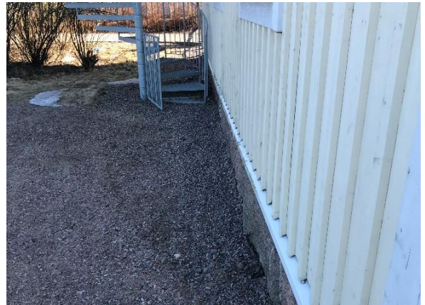
Kuva 4 Rakennuksen pohjoispäädyssä rakennuksen vierustalle on asennettu sorakaista.
