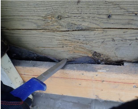
Kuva 41 Hirsissä ei havaittu lahovaurioita tai muita vaurioita.
