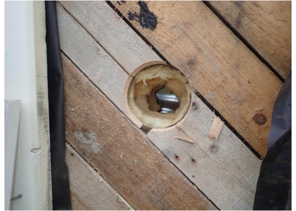
Kuva 44 Rakenteessa on alkuperäinen vinolaudoitus, jonka jälkeen lämmöneristeenä on käytetty mineraalivillaa.
