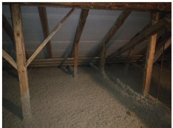
Kuva 62 Yläpohjan eristeenä on käytetty puhallusvillaa.
