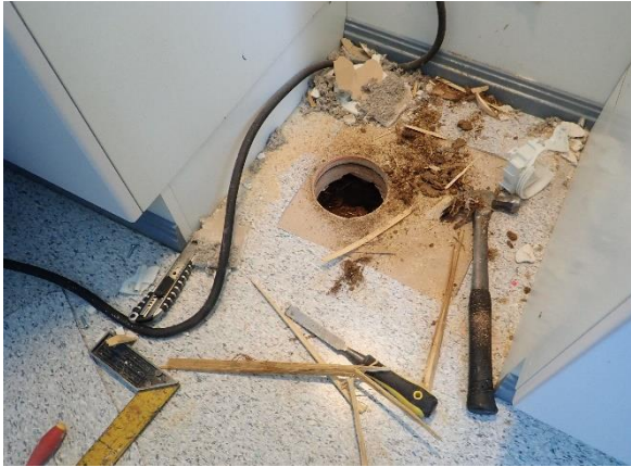
Kuva 54 Välipohjan rakenneavaus suoritettiin toisen kerroksen keittiöön/taukotilaan.
