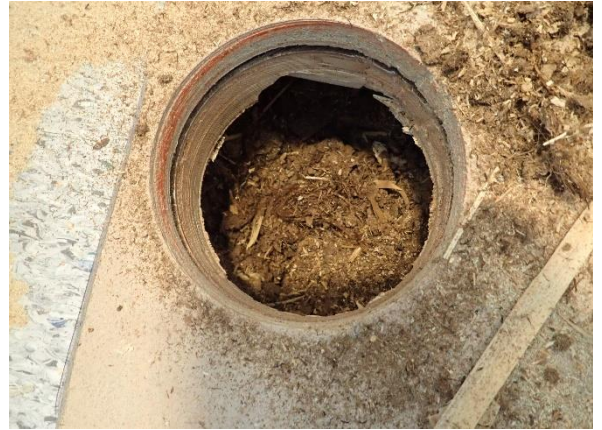
Kuva 55 Välipohjan eristeenä on käytetty mm. turvetta.
