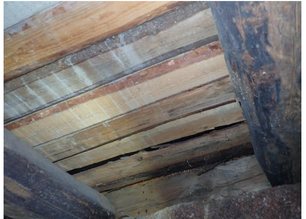
Kuva 15 Alapohjan puurakenteen vaikuttivat aistinvaraisesti arvioituna hyväkuntoisilta.
