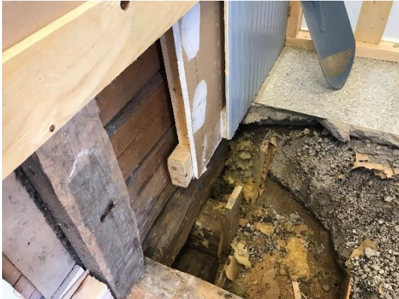
Kuva 57 Hirsirunkoista väliseinää vasten on koolattu kipsilevy ja puupaneeli. Alapohjasta on suora ilmayhteys väliseinärakenteen koolauksen taakse.
