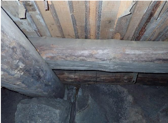
Kuva 14 Alapohjan kantavat puurakenteet vaikuttivat aistinvaraisesti arvioituna hyväkuntoisilta.
