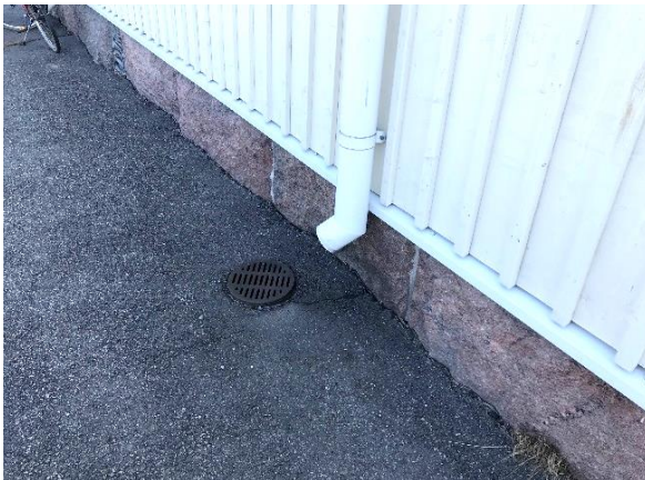
Kuva 7 Hirsirunkoinen rakennuksen osa on perustettu luonnonkivisokkelin varaan.
