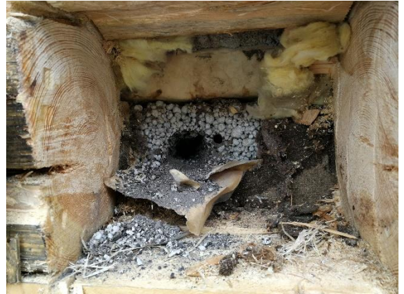
Kuva 26 Kevytbetonivalu on valettu tuulensuojalevyä vasten. Kevytbetonin ja teräsbetonilaatan väliin on asennettu valupaperi. Mineraalivillaa on asennettu sisäpuolisen koolauksen alapuolelle.
