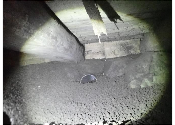
Kuva 19 Kevytsoran läpi on tuotu tuuletusputket sokkelista ryömintätilan tuulettumisen mahdollistamiseksi.
