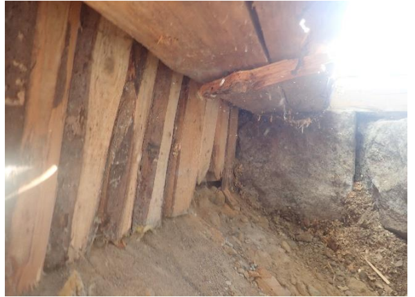
Kuva 32 Käytävätilojen hiekkatäytöt ja kevytbetonivalut on toteutettu laudoitusta vasten, joka on jätetty rakenteeseen.
