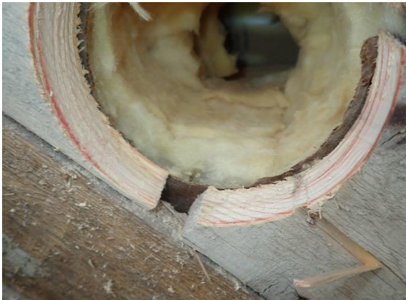
Kuva 45 Vinolaudoituksen takana on alkuperäinen tervapaperi.
