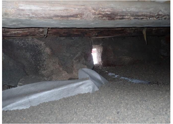
Kuva 13 Kevytsoran alle on asennettu suodatinkangas.
