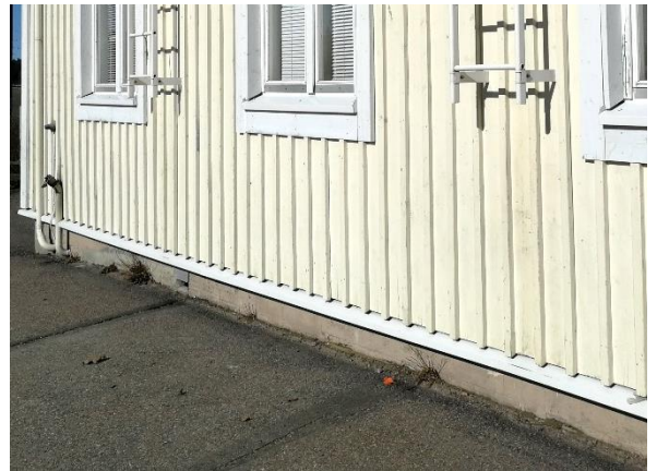
Kuva 8 Rakennuksen eteläpäädyssä sokkeli on betonirakenteinen. Vedeneristyksestä ei saatu varmuutta.
