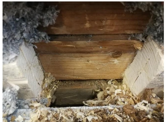
Kuva 23 Ulkoseinän ja alapohjan liittymärakenne tilassa 109 (AP2).
