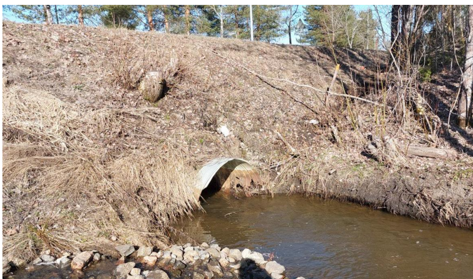
Kuva 11. Kissanoja ja Väinöntien alittava teräsrumpu. [Ramboll 4/2022]
