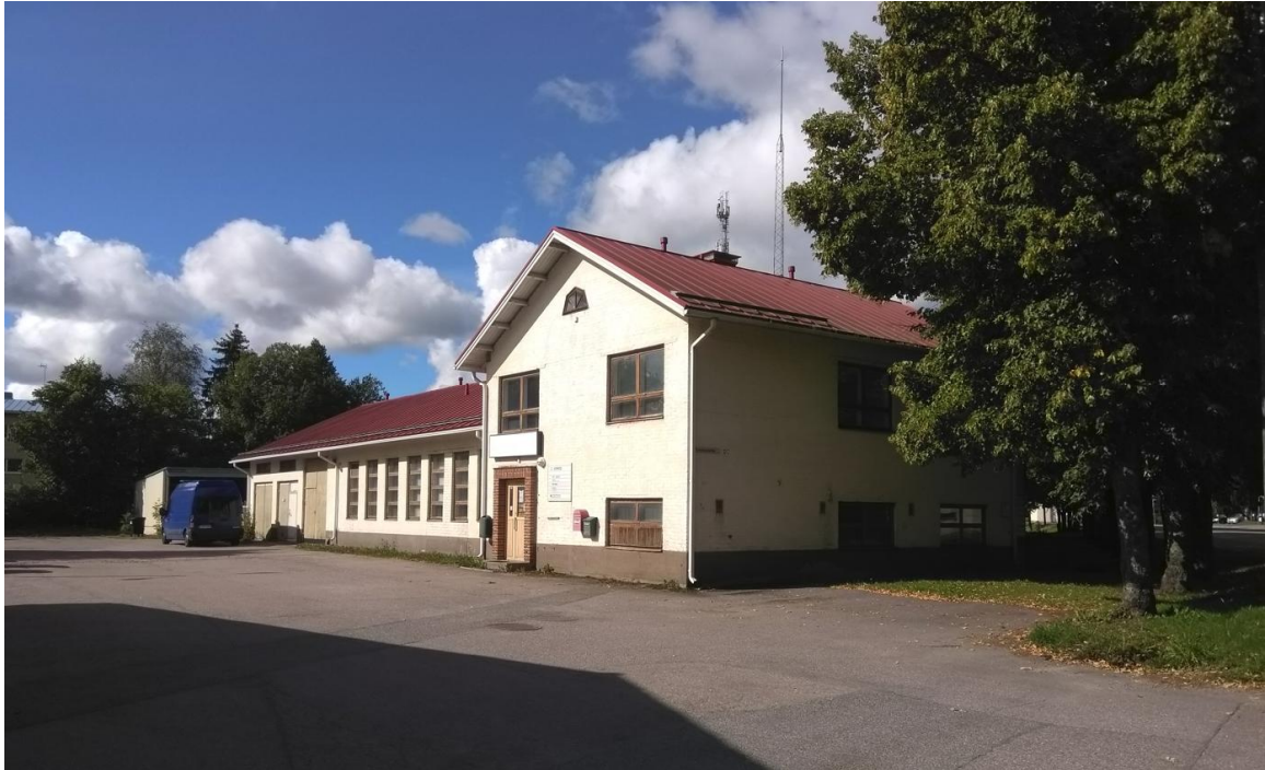
Kuva 7. Yleiskuva suunnittelualueelta, Vanhan sähkölaitoksen kiinteistö ja päällystetty piha-alue Punamullantien suunnasta katsottuna. [Ramboll 9/2021]
