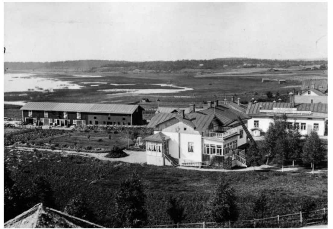
Kuva 4. Koksen lääketehdaan rakennuksia 1910-luvulla. Kuvaaja Väinö Vallinkoski. Kuvalähde: Nurmijärven museo.
