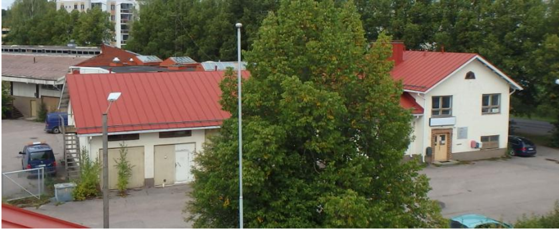
Kuva 6. Rakennuksen kakkoissivu. Piha on asvaltoitu, pihalla ei ole kaivoja. Sokkelin vierustalla kasvaa puuntaimia.
