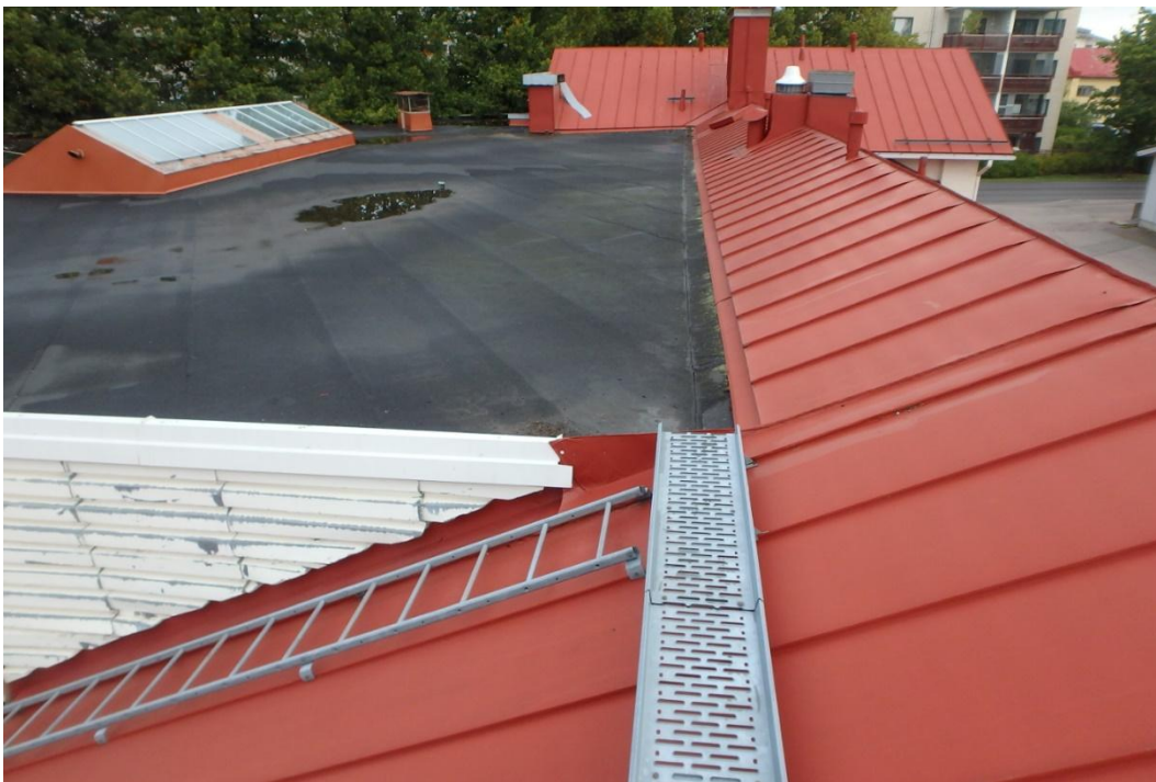
Kuva 18. Vesikatto on harjakatto ja katteena on saumattu pelti. Laajennusosan tasakatto tulee osittain harjakaton päälle.
