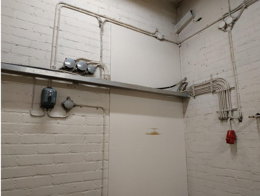
Kuva 38. Valaisinripustuskiskoa on käytetty johtoreittinä muutamissa 1. kerroksen tiloissa.
