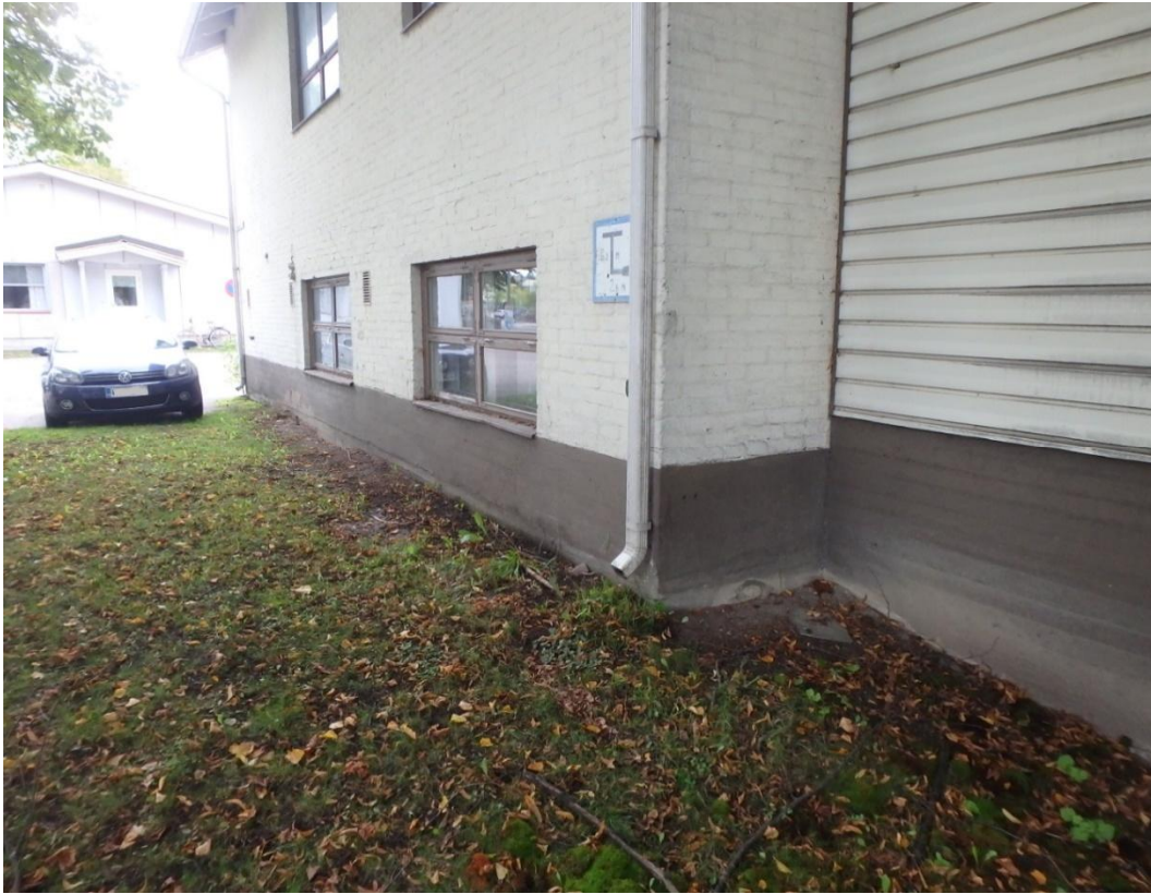
Kuva 8. Rakennuksen koillissivulla on nurmialuetta sokkeliin saakka. Sadevedet ovat ohjattu sokkelin vierustalle.
