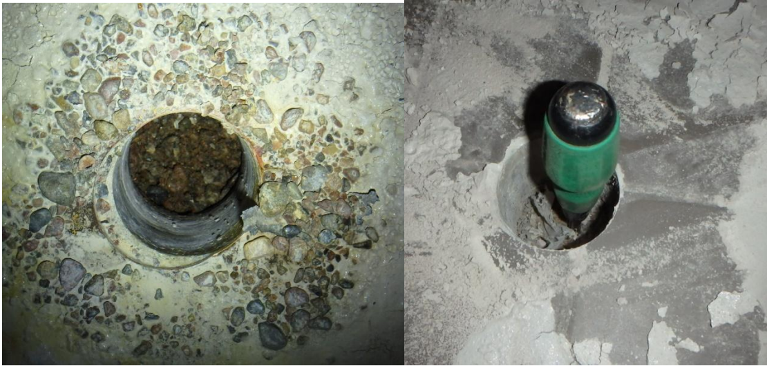
Kuva 15. Rakennuksen alapohjan avaukset. Alapohjan täyteenä on hiekkaa. Oikealla kuvassa on paikallisesti uusittu alapohjarakenne, jossa betonilaatan ja täyteen välissä on muovi.
