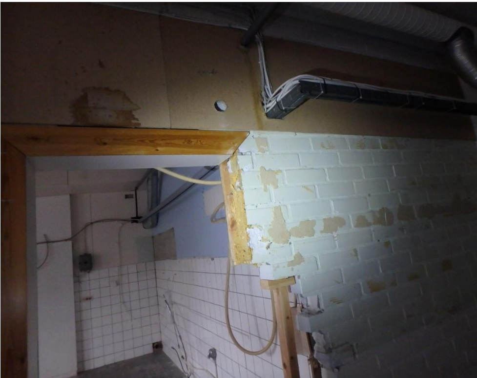
Kuva 26. Väliseinän tiilimuuraus tuettu tilapäisesti.
