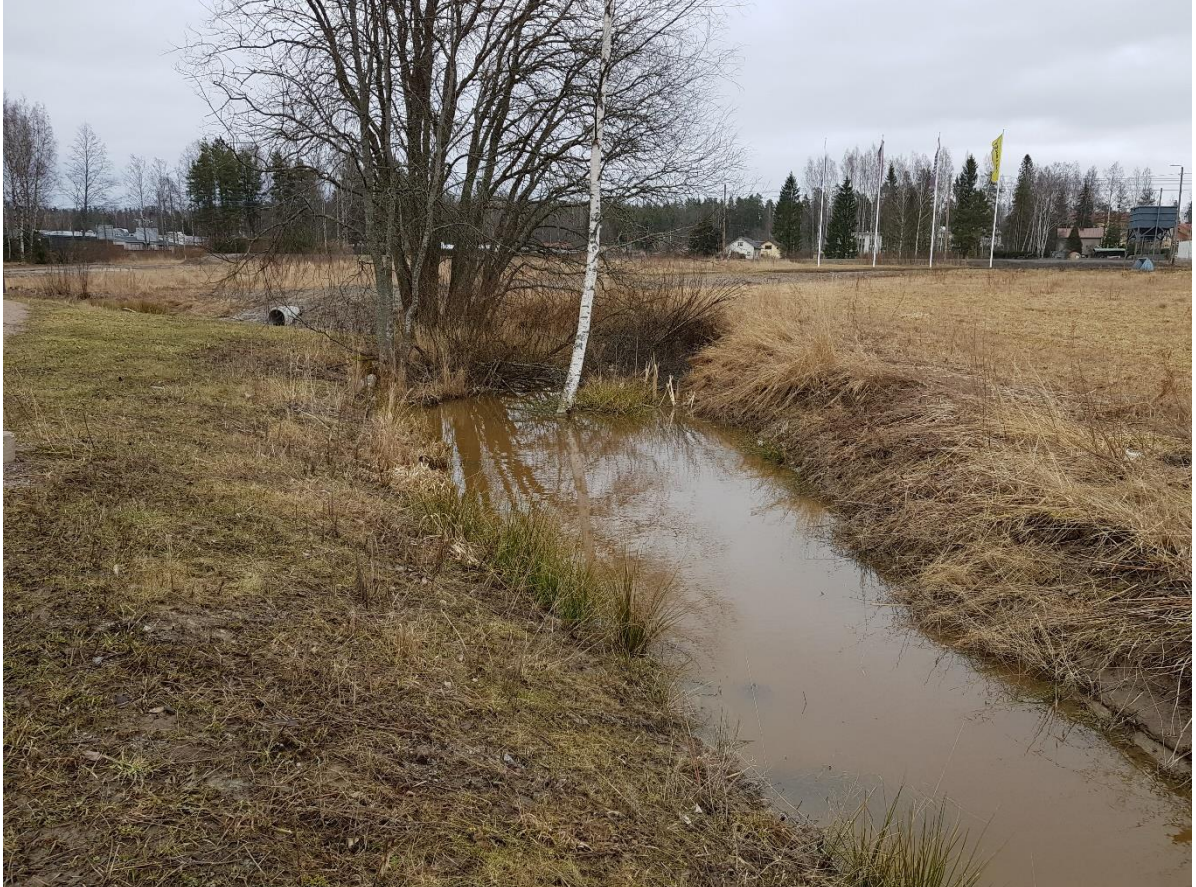
Kuva 16. Kuva laskuojasta levennyksen jälkeen. [Ramboll, 3/2020]
