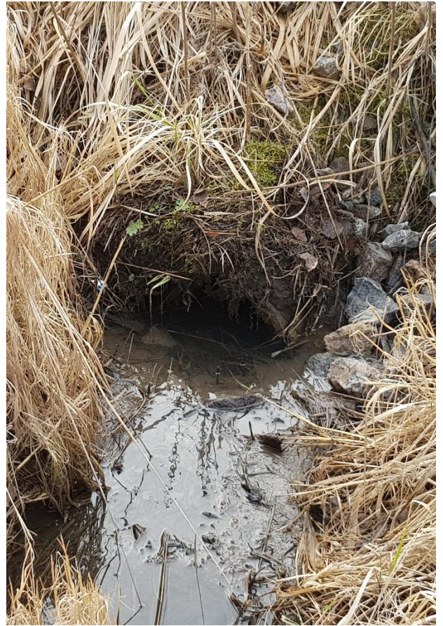
Kuvat 7 ja 8. Rajamäentien reunaaja Hellaskujan päästä etelän suuntaan katsottuna sekä rumpu Hellaskujan purkupisteen kohdalla. Rummun korko ja ojan pituusprofiili tulisi tarkistaa jatkosuunnittelun yhteydessä. [Ramboll, 3/2020]
