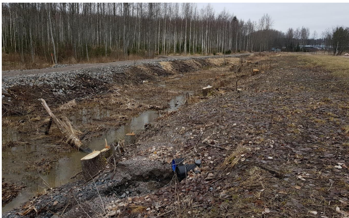
Kuva 18. Laskuojan vesitilavuus kasvaa alajuoksua kohden. Kauppakeskuksen hulevesialtaan vedet purkavat ojaan. [Ramboll, 3/2020]
