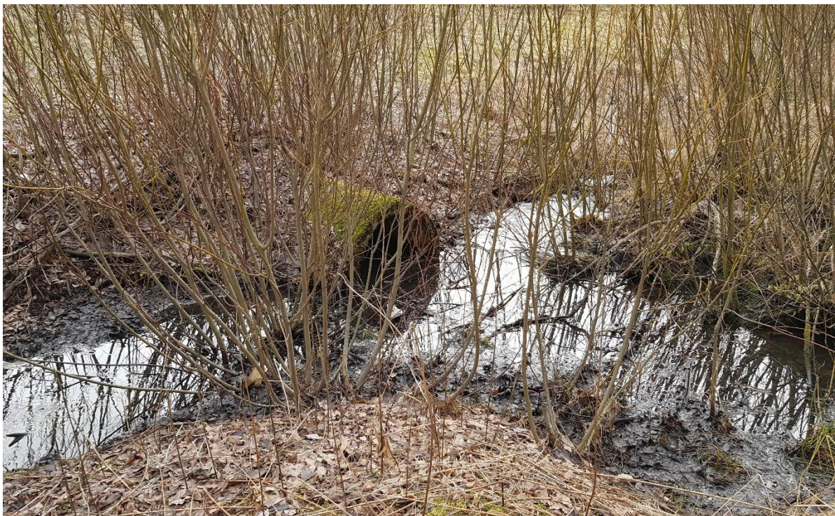
Kuva 6. Rajamäentien länsipuolen reunaoja, johon Rajamäentien pohjoisosien vedet kulkeutuvat. Kuvassa näkyy suunnitellun alikulun pohjoispuolelta Rajamäentien alittava 800 B rumpu, joka johtaa hulevesiä Rajamäentien itäpuolelta länsipuolelle. [Ramboll, 3/2020]
