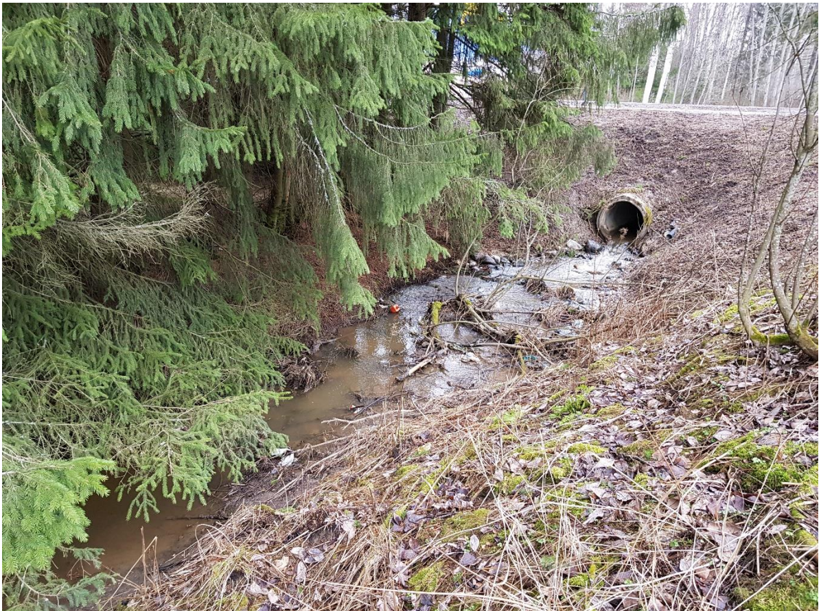
Kuva 20. Laskuoja Kiljavantien eteläpuolella ja Kiljavantien alittava 800 B rumpu. Oja muuttuu etelämpänä Matkunojaksi. [Ramboll, 3/2020]
