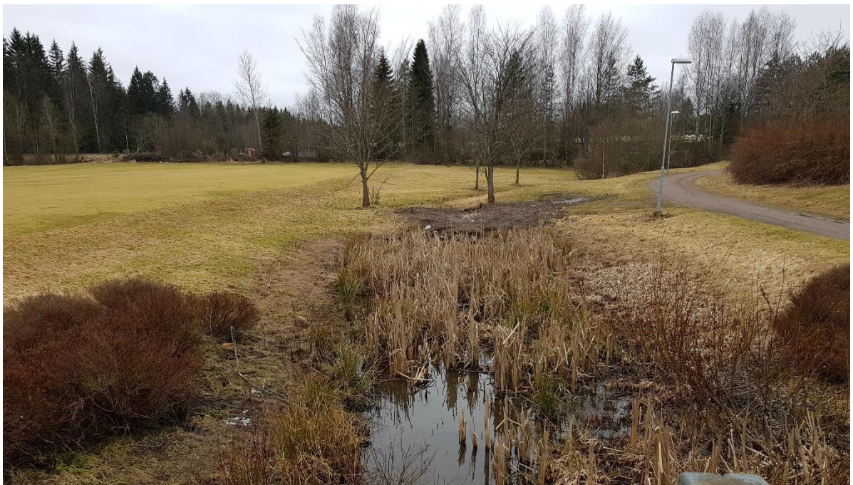
Kuva 22. Urheilukentän eteläpuolella sijaitseva hulevesipainanne, johon kirjaston alueen hulevedet johdetaan Arenkujan purkupisteestä ennen Matkunojaan johtamista. [Ramboll, 3/2020]
