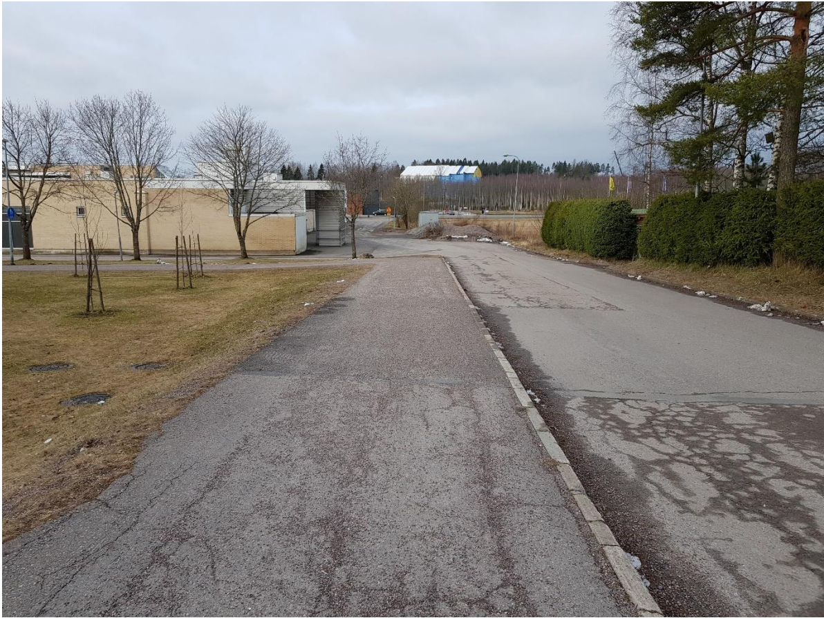
Kuva 4. Yleiskuvaa Hellaspolusta nykytilassa. Kuva otettu Hellaspolun ja Kievarintien risteyksestä lännen suuntaan katsottuna. [Ramboll 3/2020]
