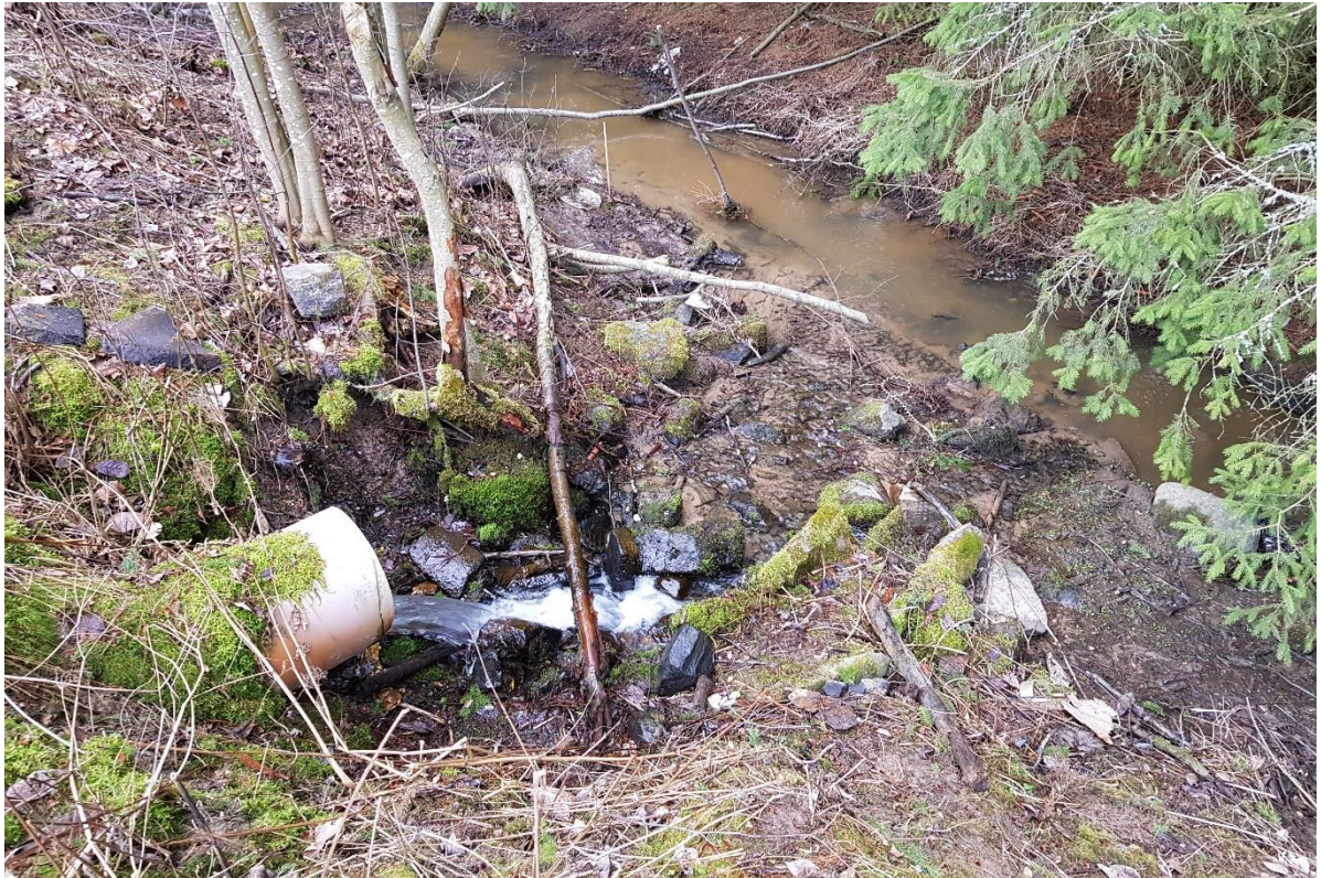
Kuva 21. Hulevesien purkupiste Rajamäentien ja Kiljavantien risteysalueen ja sen eteläpuolisen kaavamuutosalueen hulevesille. [Ramboll, 3/2020]
