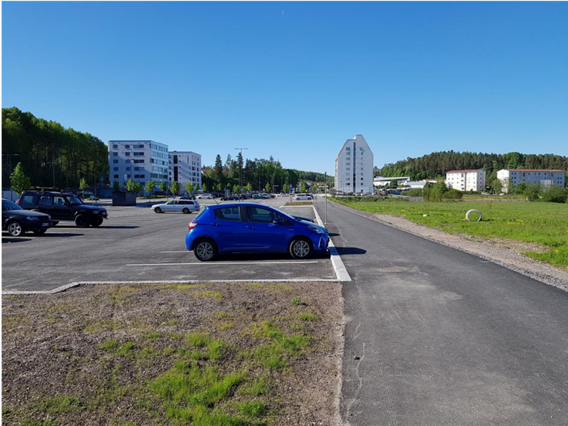
Kuva 9. Luhtajoen rakennettua liityntäpysäköintialuetta pohjoisesta etelään päin katsottuna. [Ramboll 6/2021]
