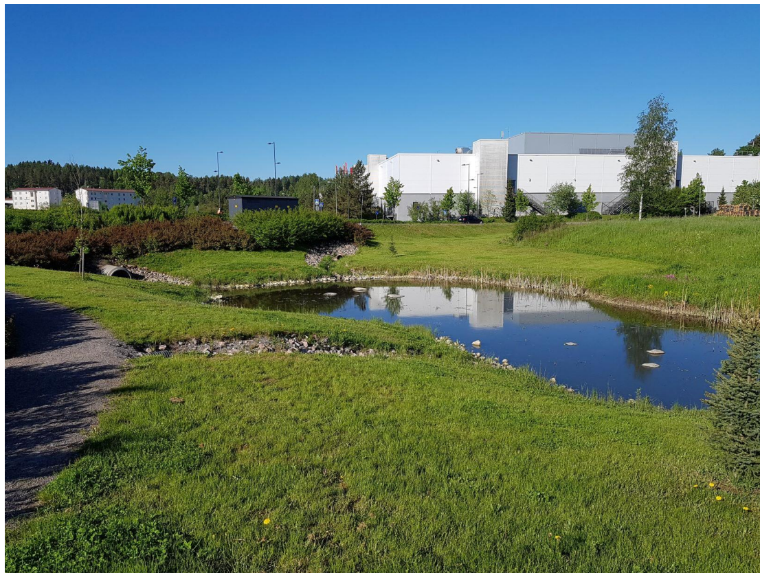
Kuva 12. Rakennettu hulevesiallas Viirintien pohjoispuolella. [Ramboll 6/2021]
