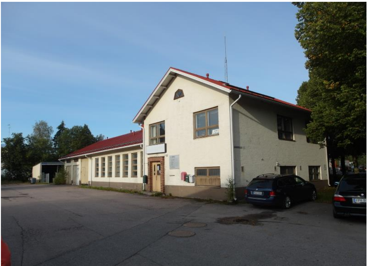
NURMIJÄRVEN SÄHKÖLAITOKSEN ALUE, 53I SÄHKÖLAITOKSEN TOIMITILA, VANHA OSA
