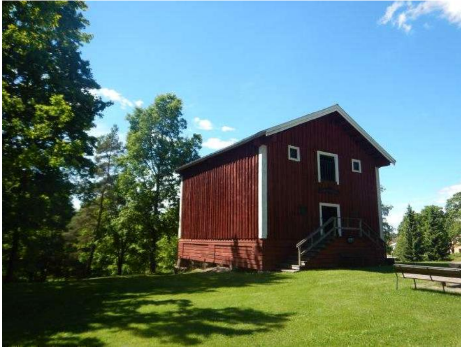
Koillis- ja kaakkosjulkisivut
