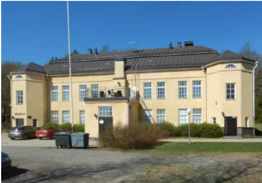
Ahjola, itäjulkisivu, sisäänkäymnit
