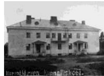
Pohjoissivu 1930-l. NMA.
