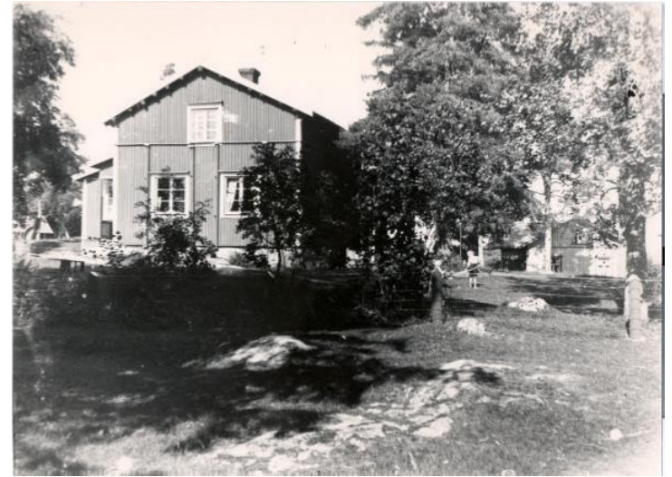
Malakias Costianderin suvun talo (Mäntylä) Nurmijärven kirkonkylässä kalliisella nurmella, kesä 1924. Talon pääty, alakerrassa kaksi kuusiruutuista ikkunaa, ylhäällä harjakaton alla yksi kuusiruutuinen ikkuna, talon pitkällä sivulla oleva kuisti näkyy vasemmalla. Pihamaalla kasvaa nurmea ja lehtipuita. Oikealla taaempänä näkyy vaaleaksi maalattu harjakattoinen puurakennus, Sivenin talo. Kuva Reino Kostia. NMA
