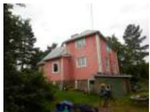
Itä sivu, pohjoispääty
