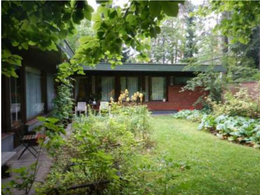
Sisäpiha, länsisivu, etelä sivu
