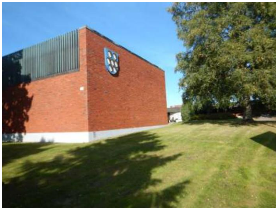
Kokoussaisiipi, sisäänkäynti eteläjulkisivulla
