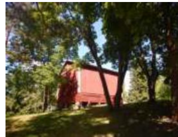
Kaakkois- ja lounaisjulkisivut
