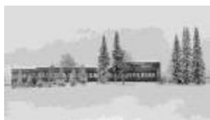
Julkisivu länteen 1960-l. NMA.
