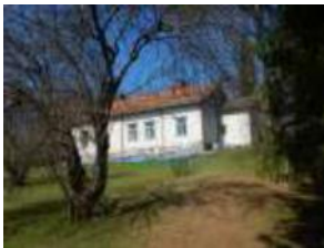
Itäpäädyän laajennus Punamullantieltä
