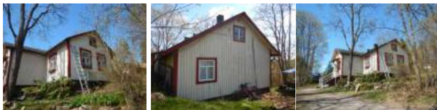
Kuisti ja eteläjulkisivun itäosaa
