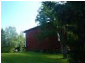
Lounais- ja luoteisjulkisivut
