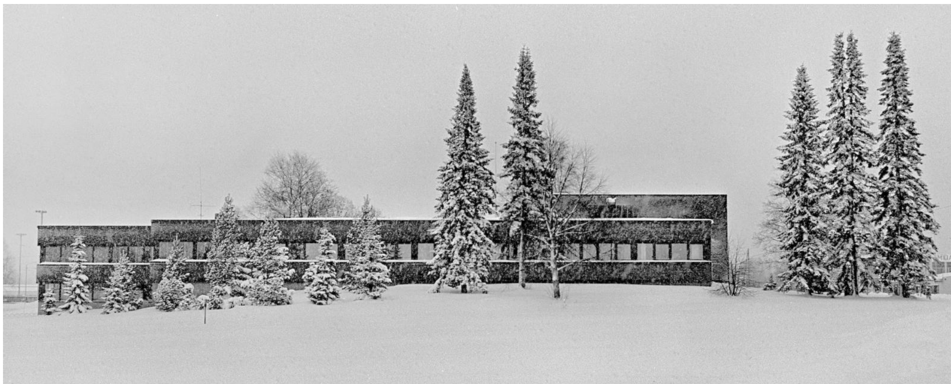
Kunnatalon pohjoissivu ennen laajennusta. NMA.
