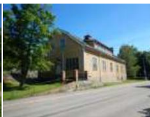
Länsi- ja pohjoisjulkisivu
