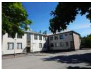
Pohjois- ja itäsiivut sisäpihalla.
