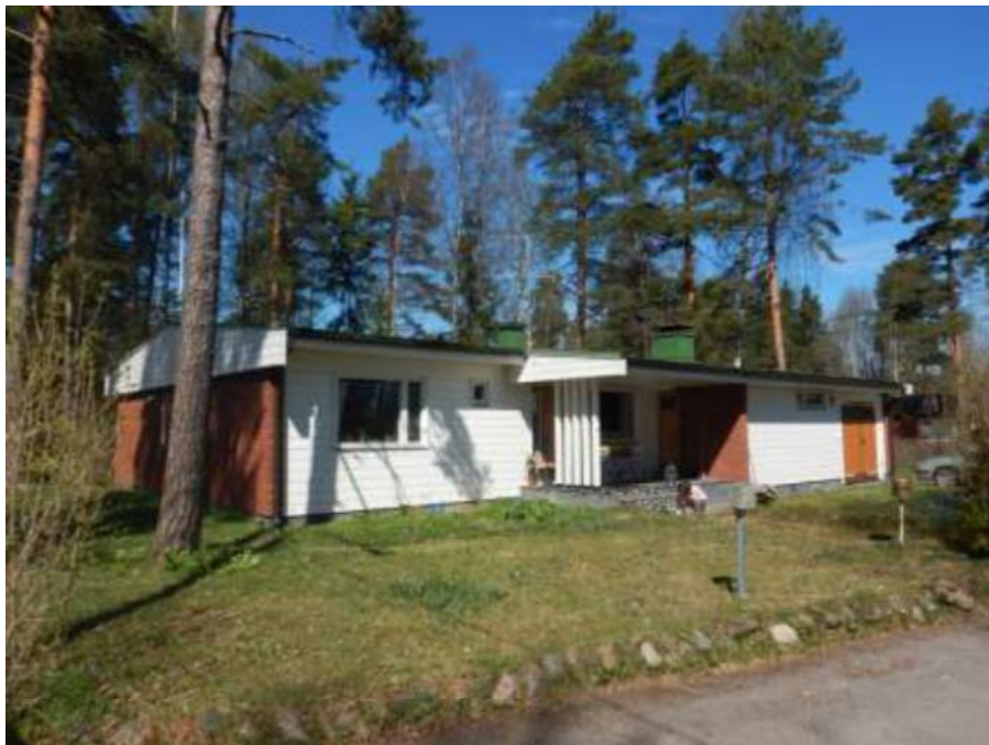
Itäulkisivu Puontilankaarella, eteläpääty
