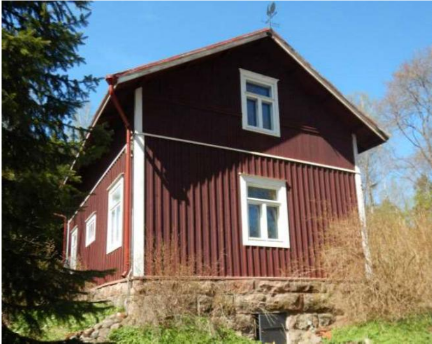
Päätyulkisivu itään Puontilankaarelle
