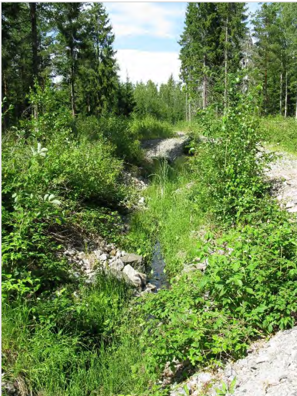
Kuva 6. Puron luiskat on vuorattu kivimurskalla, mutta kasvillisuus on silti puskenut siitä läpi.
