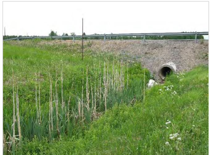
Kuva 20. Kuvassa on Keikkumäentien allttava rumpu, sekä uomassa kasvavaa osmankäämiä.
