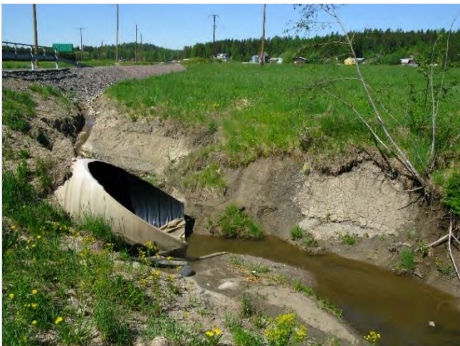
Kuva 1. Rajamäentien alittava rumpu on mitoitukseltaan riittävä.
