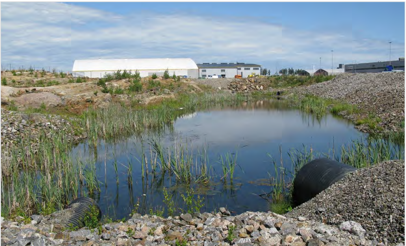
Kuva 1. Keinotekoinen hulevesiallas toimii Ilvesvuoren hulevesien viivyttäjänä ennen kuin sen vedet jatkavat virtaamistaan Kertunojaan.
