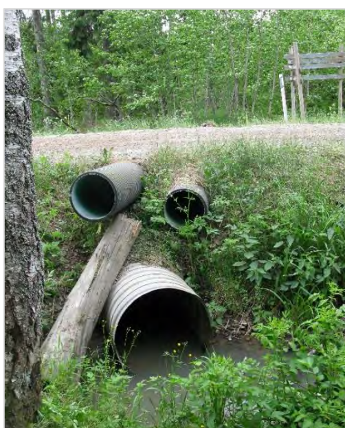
Kuva 17. Heinojan tien alittavat kolme rumpua.
