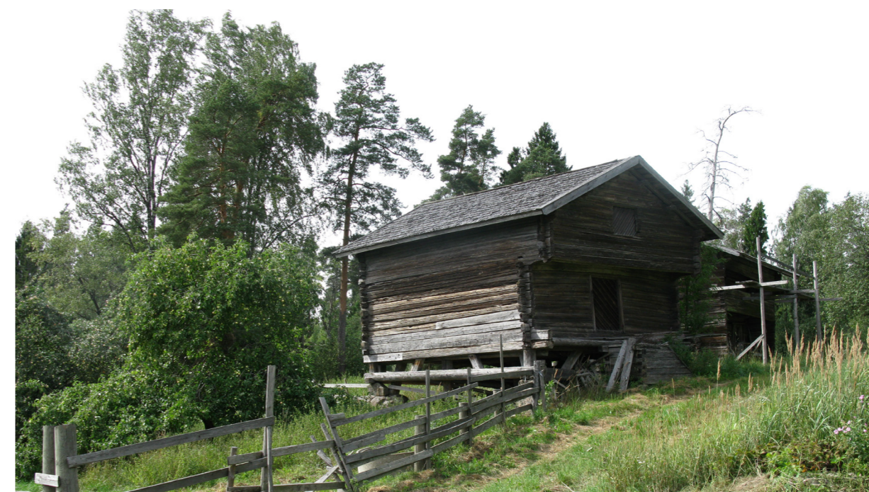
Kuva 19. Ojakkalan pihapiiriin kuuluva vanha aitta on edelleen pystyssä.
