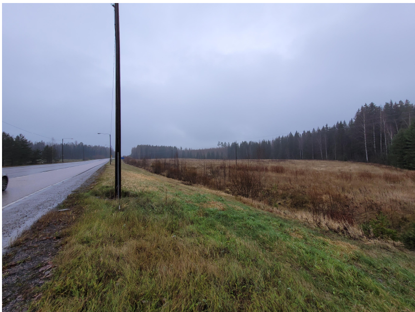
Kuva 8. Maantie 130 tontin eteläosassa katsottuna pohjoiseen
