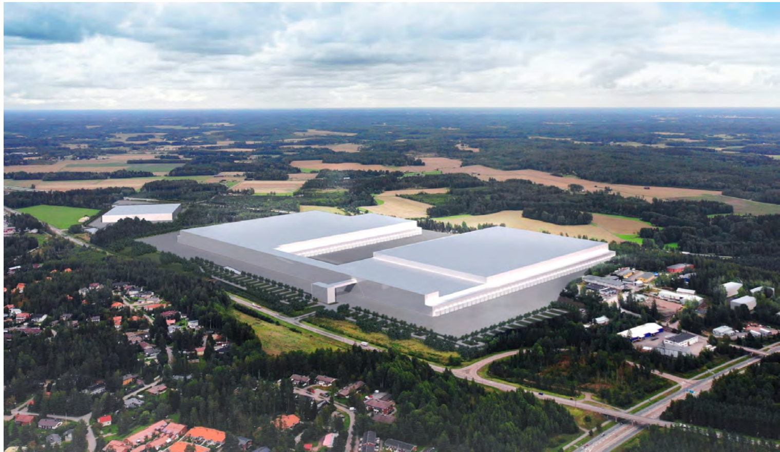
Ilmakuva logistiikkakeskuksesta loppulaajuudessaan.
