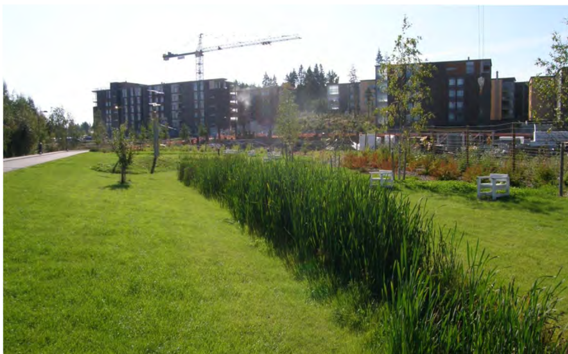
Kuva 2. Rambollin suunnittelema rehevänä viherpainanteena toteutettu biopidätys Suurpellon alueella Espoossa.
