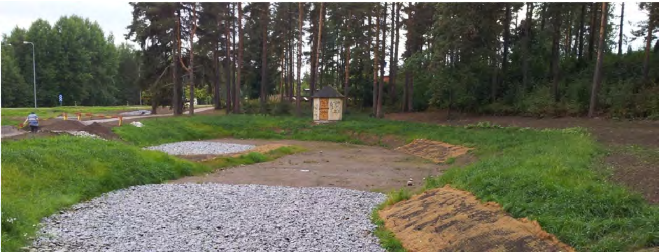
Kuohunlahden puiston hulevesiallas noin 2,5 kuukautta eroosiosuojamaton ja nurmikylvön jälkeen. Allasta ympäröivät luiskat ovat vahvan kasvillisuuden peittämät ja allas on valmis vastaanottamaan hulevesiä. Kuvan etualalla luiskaa suojaa pelkkä matto ilman nurmikylvöä, koska alueelle on tarkoitus istuttaa myöhemmin kosteikkokasvillisuutta. Kuva 1.9.2013.
